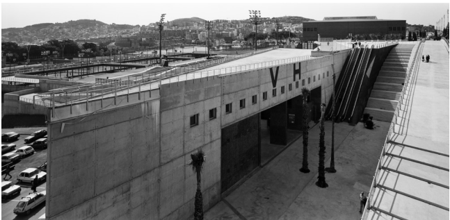
Obras de la Zona Olímpica del Vall d'Hebron
