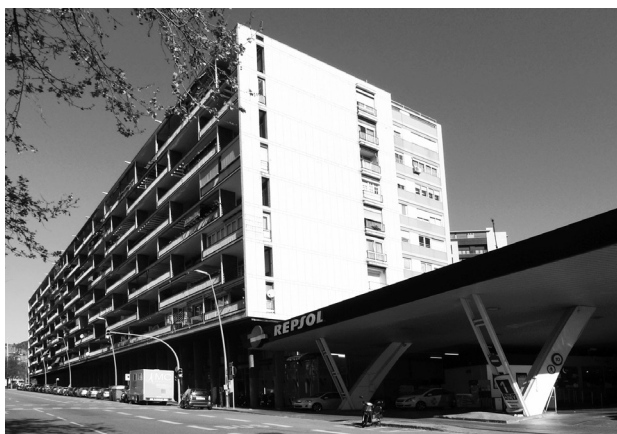
Fig 32. Edificio SEIDA, Francisco Mitjans. Barcelona, 1953-60.
