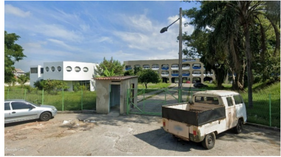
Figura 8: Entrada para o terreno da unidade CIEP 312.
