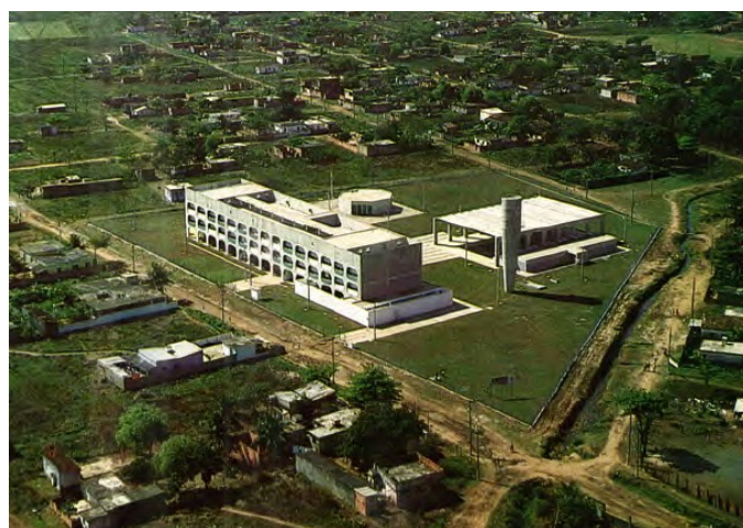
Figura 2: Imagen aérea de un CIEP de nueva construcción.
