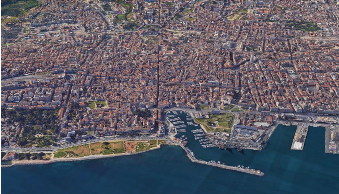
Fig. 04 Vista aérea del Centro Histórico de Palermo con los cuatros "mandamenti". Fuente: Elaboración de los autores a partir de Google Earth.
