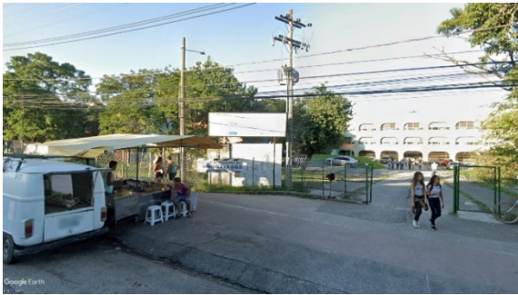
Figura 7: Entrada para o terreno da unidade CIEP 311.
