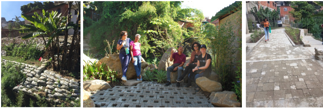
Fig.5 taludes con geotextiles y plantíos productivos. Fig. 6 Parque de las Piedras, con rocas testimoniales de la tragedia del 99, y vegetación con flores. Fig. 7 Rampa, muro y pavimentos de adoquines manufacturados con piedras de la quebrada Catuche. Fuente: www.ccscity450.com
