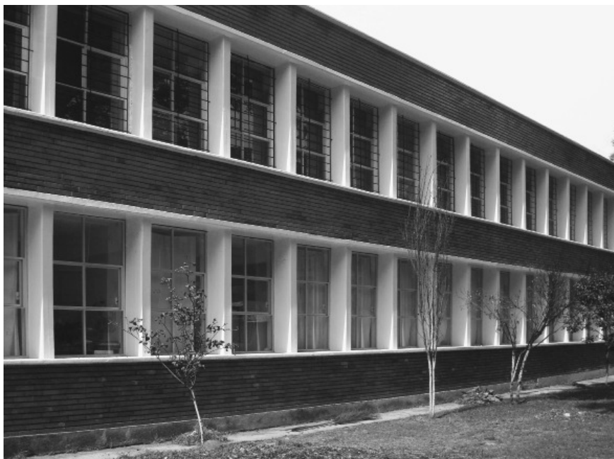
ERCR, fotografía actual. Vista de la fachada levante del edificio de aulas. Fuente: Arais Reyes Meza, 2012.
