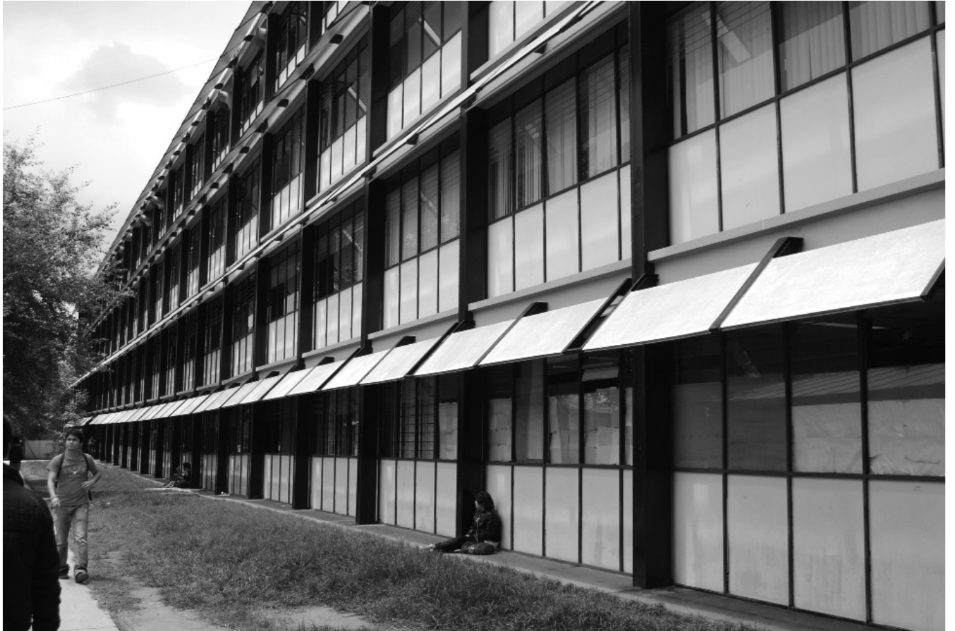
Vista actual de la fachada de un edificio tipo de aulas, los parasoles no son parte del proyecto original de Pérez Rayón, fueron añadidos posteriormente. Fuente: Juan Pablo Ortiz, 2012
