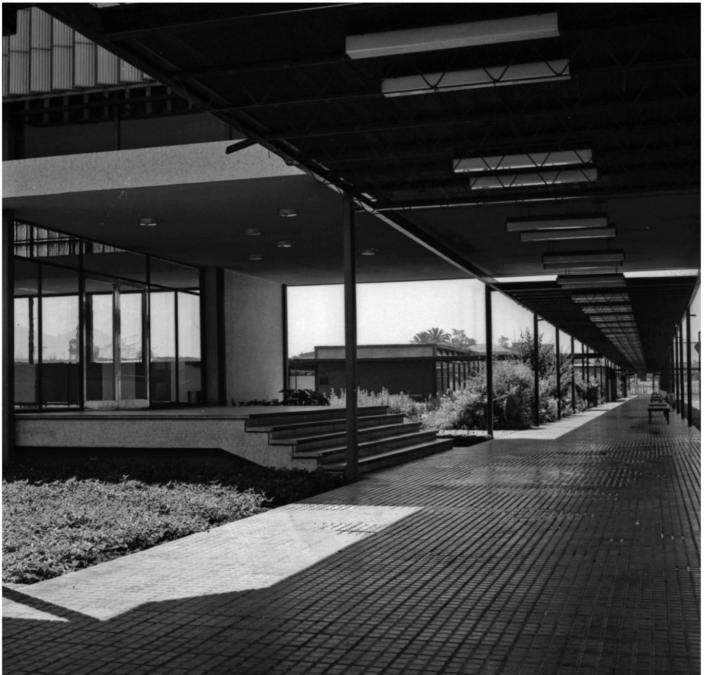
Circulación de segundo orden. Porche del edificio Sur de Administración. Fuente: Archivo de Documentación Gráfica y Audiovisual de la Universidad de Santiago de Chile.
