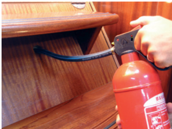
Fig. 10. Vacinando un extintor en el compartimento del motor
