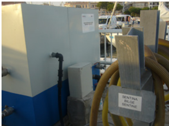
Fig. 6. Instalación recepción puerto deportivo
