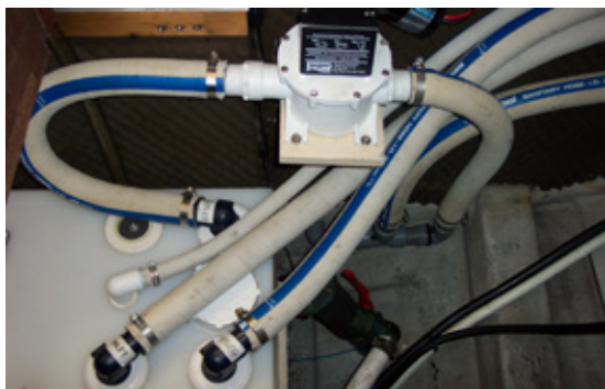
Fig. 5. Sistema de retención de las instalaciones sanitarias
