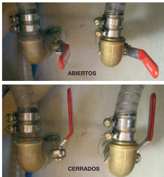
Fig. 18. Grifos de fondo abiertos y cerrados
