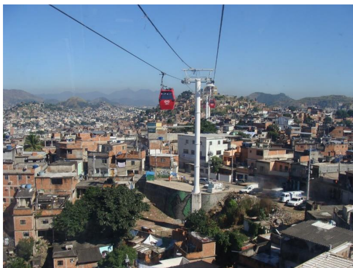
Fig. 8. Vista desde el Teleférico. Área de intervención del pilar 20. Diferencia de nivel entre la calle y el terreno baldío más abajo.
