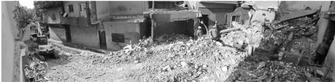
Fig. 25 Villa 20. Demolición en curso para aperturas de calles. Año 2018. Fuente: IVC – GCBA
