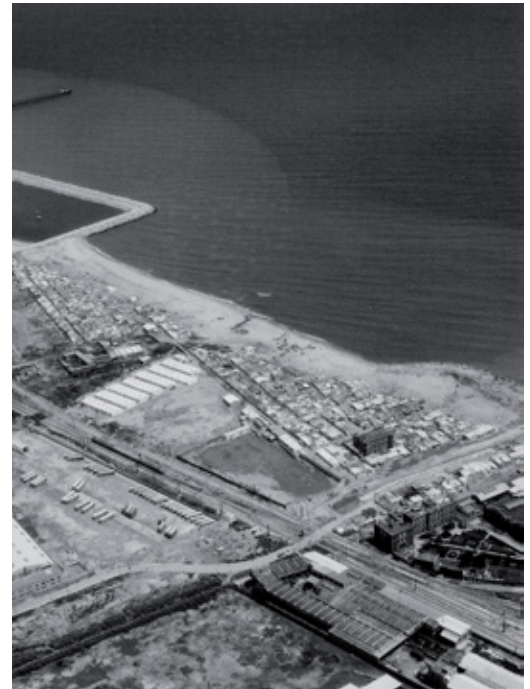
Aerial image with the isolated aspect of the places :: fig.5/ Imatge aèria on s'hi observa l'aïllament dels polígons
