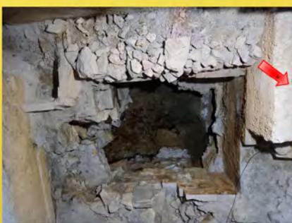
Vista cenital del manantial y detalle del arranque de bóveda en CF2
