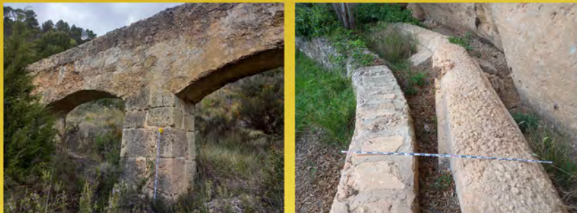
Primer acueducto y ceñajo con la traída, canal y conducción a la par.
