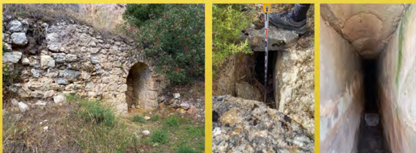
Muro de conexión del canal al tramo excavado, tapa de laja caliza y vista interior con tapa moldeada
