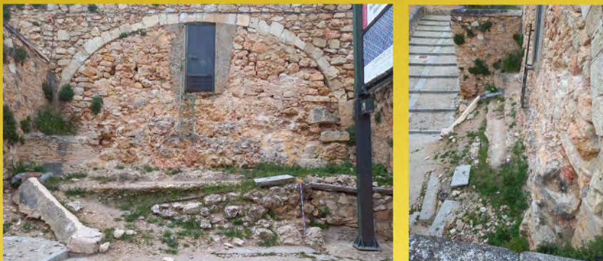
Puente del Castillo en Trabuco que aloja el filtro. Al pie, restos del cajero del canal y alcantarilla.
