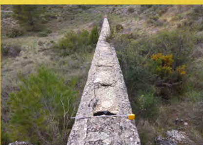
Canal, con cimentación, cajero y tapas en lajas calizas y en mortero de hormigón
