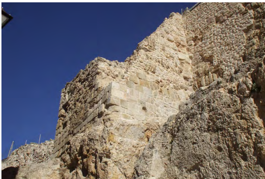
Figura 3. Vista de uno de los torreones de la C/ Bajada del Carmen donde se aprecia la técnica constructiva islámica.
