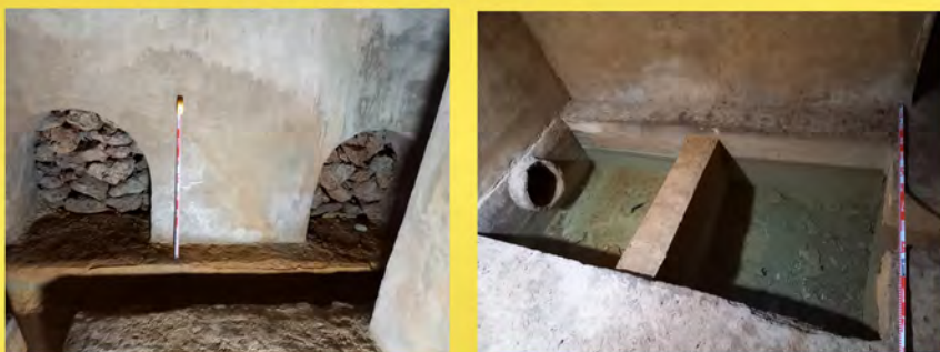
Drenaje mediante galería subterránea, encauzamiento, decantador y tubería de remisión
