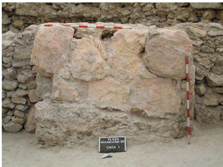
Figura 4. Muro islámico realizado en grandes mampuestos de caliza roja apoyados en la roca.
