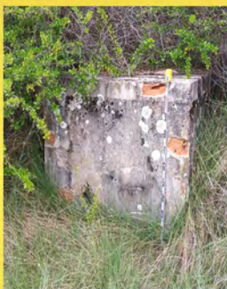
Aliviadero junto a la CUV-9141, primera almenara de la conducción y registro repartidor para riego
