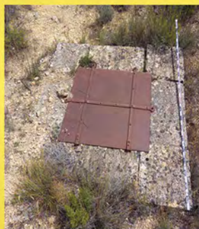
Aliviadero junto a la CUV-9141, primera almenara de la conducción y registro repartidor para riego
