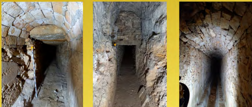
Umbral del primer sector, adintelado; comienzo de la mina y tercer sector, abovedado.
