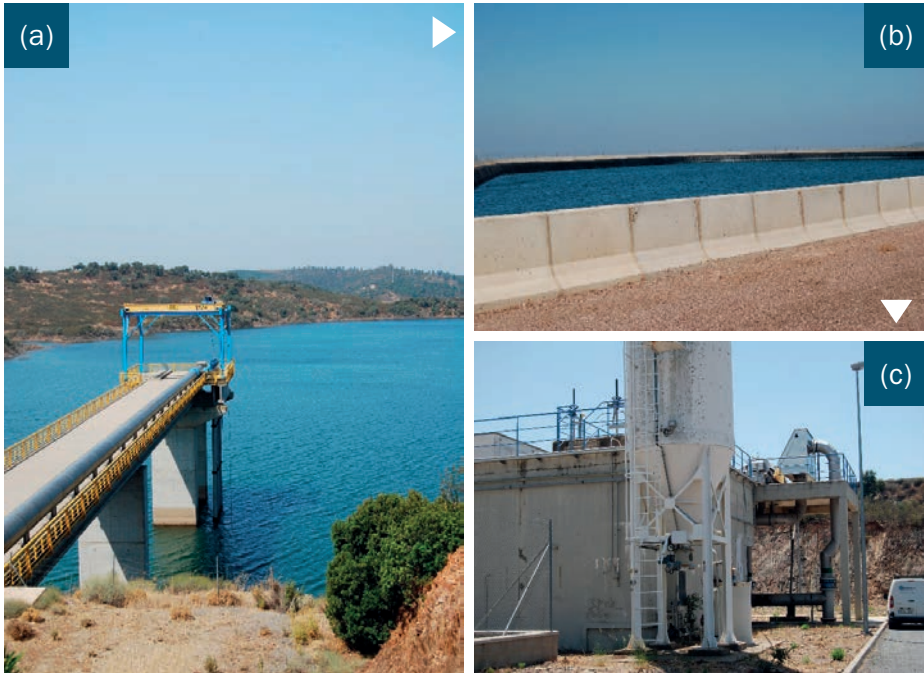
FIGURA 7: Bombeo Palafito (a) en el embalse del Andévalo que impulsa el agua a la balsa Cabezo del Pasto (b) que se constituye como depósito de regulación del caudal de agua que llega a la ETAP Andévalo (c) (19/06/2017)
