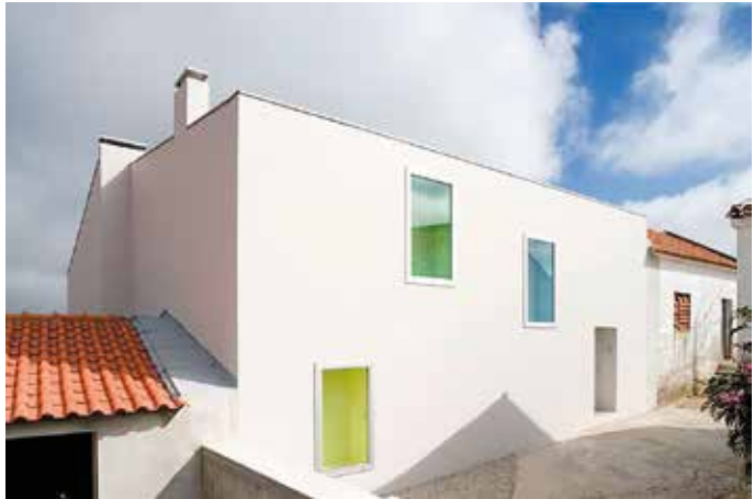
Fig. 6. House in Sobral da Lagoa, Óbuidos, 2008
