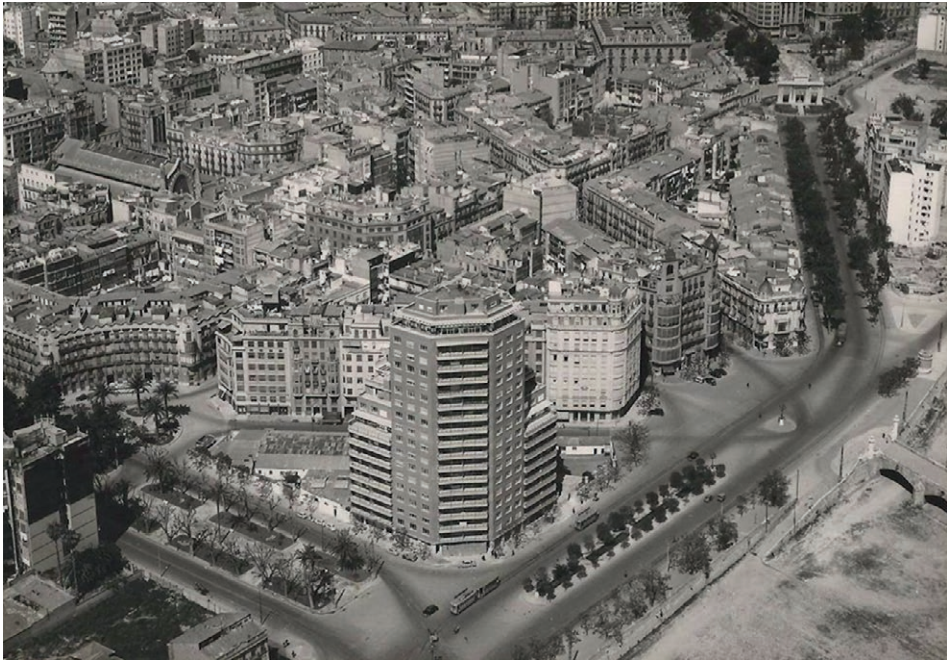
Figura 61. La Torre Valencia a punto de finalizar, formando parte de la trama del Ensanche pero en cierto modo de espaldas a este.
