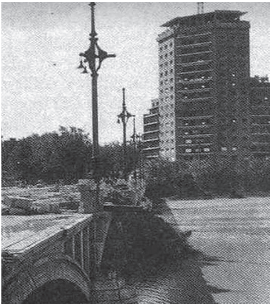
Figura 28. Daños producidos por la riada en el puente de Aragón que obligaron a sustituir completamente los antepechos perdidos. La Torre Valencia en construcción.
