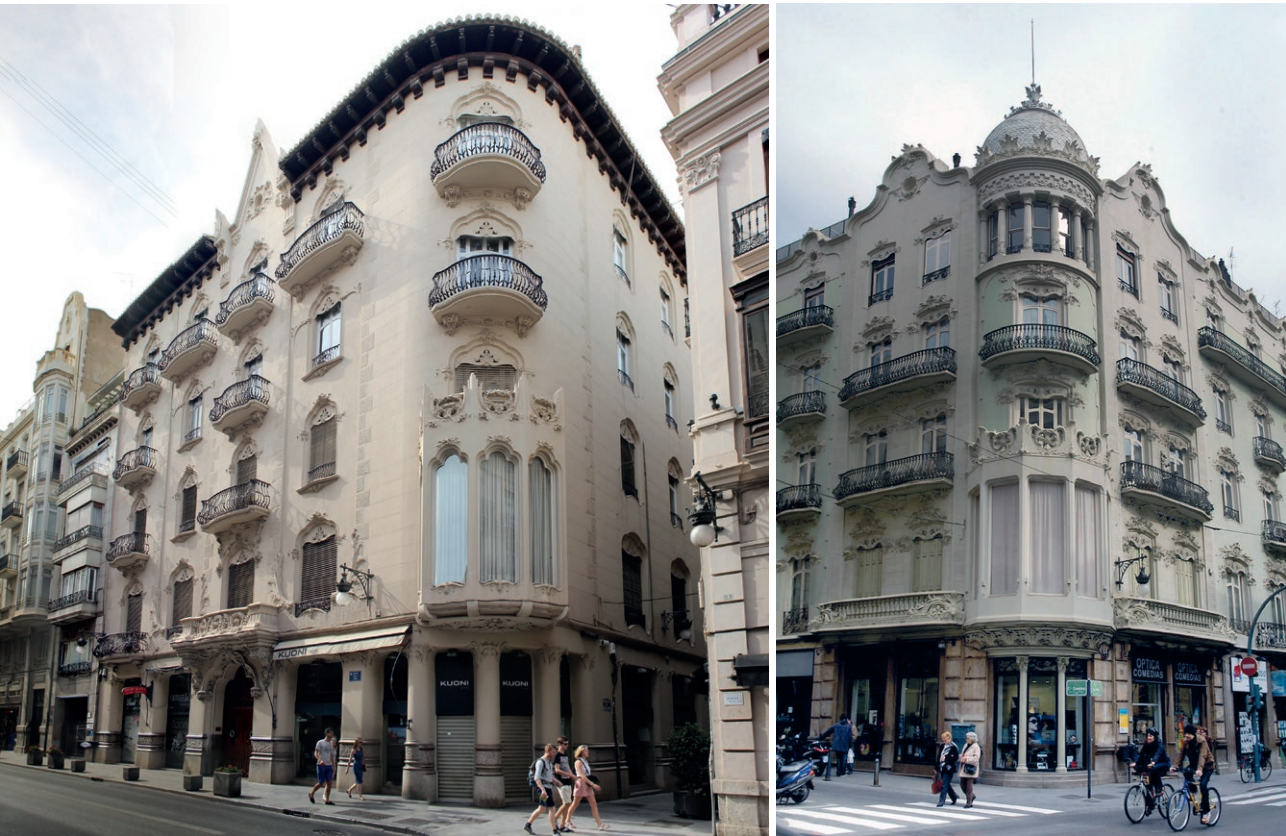
Figura 130. Casas en la calle de la Paz esquina a calle Bonaire y en la calle de la Paz esquina a calle Comedias, promovidas por Manuel Gómez y Gómez.
