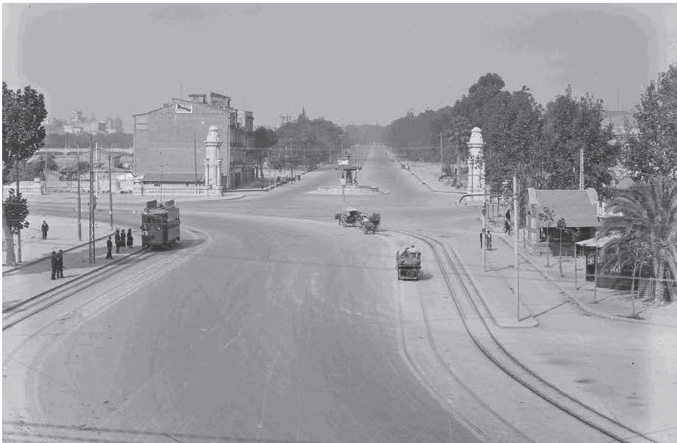
Figura 23. El Paseo de la Alameda, en proceso de prolongación, vista desde la Avenida del Puerto en el que se aprecia el nuevo trazado de las líneas de tranvía.
