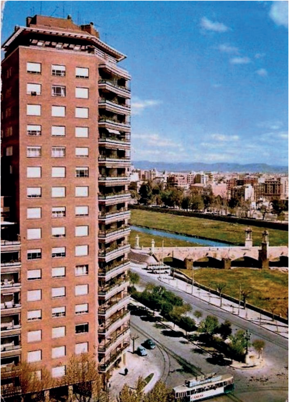
Figura 124. Vista a mitad de altura de la Torre Valencia junto al río y las montañas al fondo.
