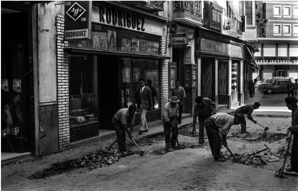
La tienda fotográfica de Rodríguez en la calle San Francisco 25. Operarios trabajando en las labores de la nueva pavimentación, 1970. Fotografía Rodríguez
