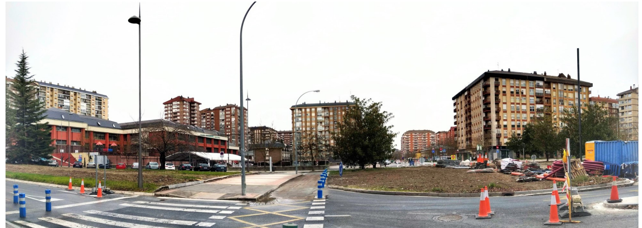
FIGURA 3 Obras de adecuación de la calzada para la construcción del carril exclusivo para el BEI (Bus Eléctrico Inteligente) Fuente: Elaboración propia
