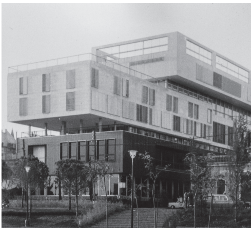
El Col·legi de Metges poc després de la seva inauguració. Façana des dels jardins del Dr. Roig i Raventós, en què s'observen els diferents volums i els voladissos respecte als cossos inferiors. La posició dels paraments vidriats accentua la sensació de buit
