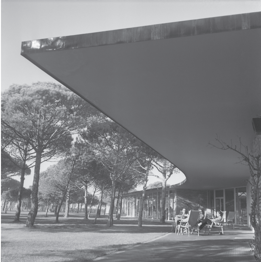
Club de Golf del Prat. Voladís fantàstic de la coberta, que evidencia que coneixia les tècniques estructurals més avançades (pretensatge). Protegia l'entrada al Club i alhora oferia un recer per contemplar el forat 1 i la platja.
