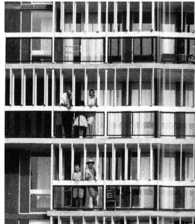
Fragment de la façana al riu Charles, amb les baranes transparents i les lamel·les blanques _ 16
