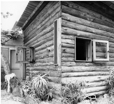
Vista exterior del Cabanon _ 9
