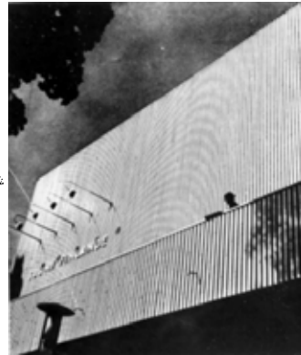
Fotografía de la fachada
