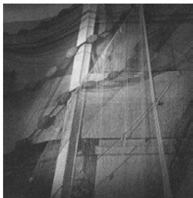
Redes sobre la estructura metálica portante
