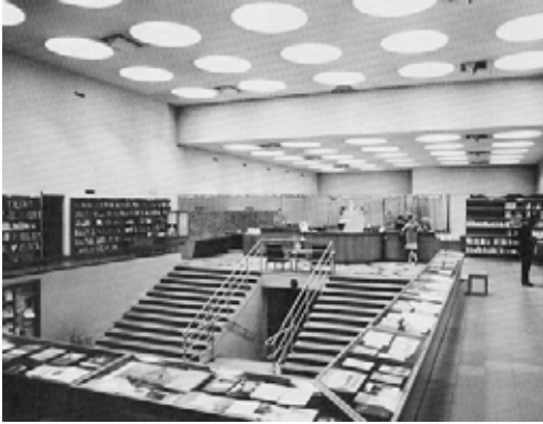
Interior de la biblioteca de Viipuri, A. Aalto
