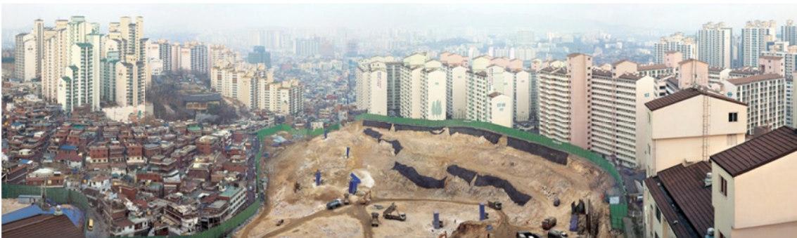
Fig. 08 Renovación urbana en Ha-Wangsimni (하왕십리) mediante la eliminación de los tejidos urbanos previos, dentro de la New Town Initiative. Fuente: Colectivo 'Flying City'.
