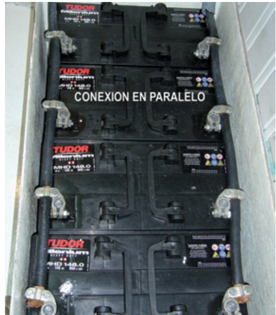
Fig. 44. Baterías conectadas en paralelo
