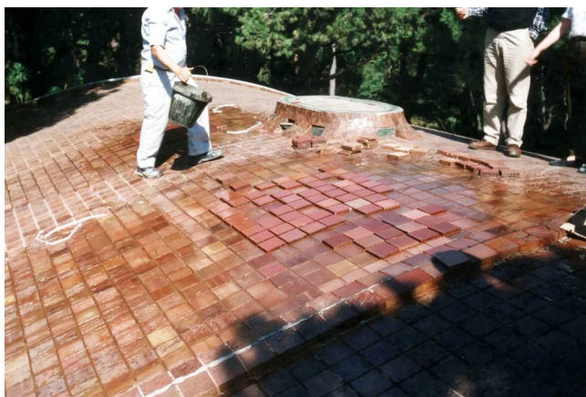
La Ricarda, restauración de la cubierta, 2000
