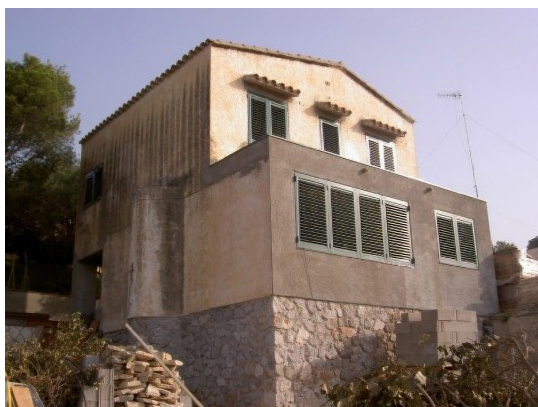
Casetes del Garraf desfiguradas, proyecto original de Sert y Clavé, 1932-1935 (Sitges) Fotografía de Fernando Álvarez Prozorovich, 2003
