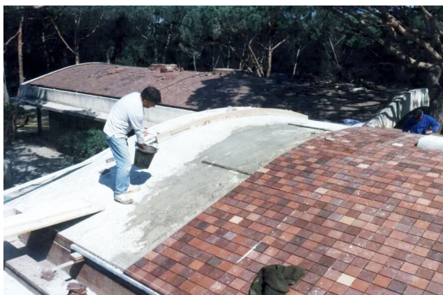
La Ricarda, restauración de la cubierta, 2000
