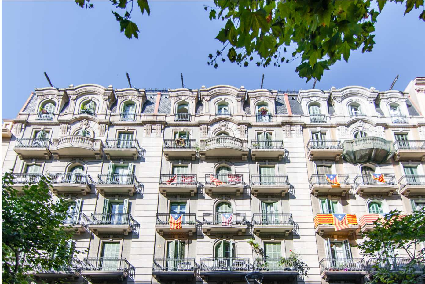
Figura 36 Carrer de Muntaner, 185. Josep Alemany, arquitecte, 1929 (Fotografia juny 2014).
