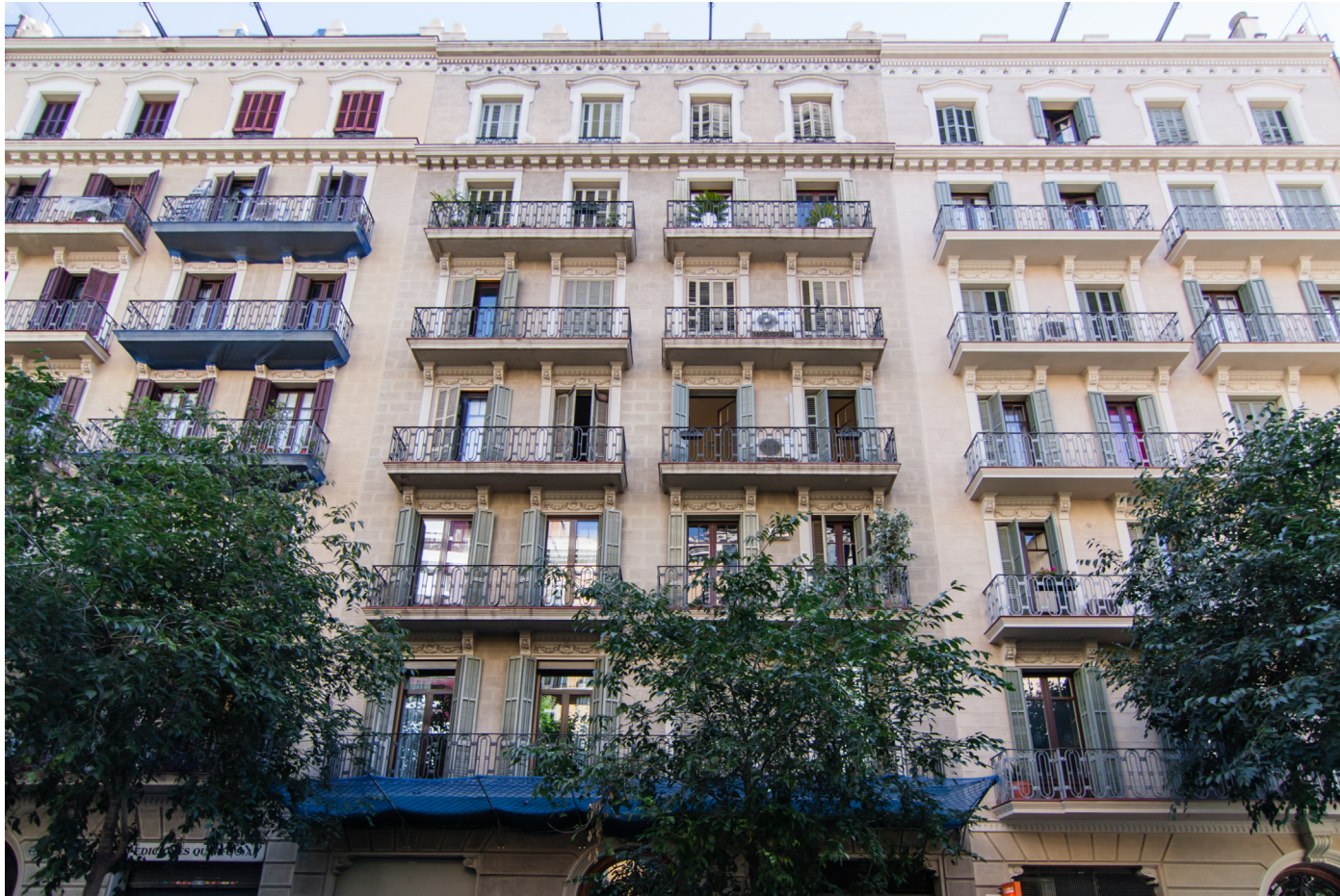
Figura 35 Carrer de Casanova, 212. Antoni Bartra, arquitecte, 1926 (Fotografia juny 2014).
