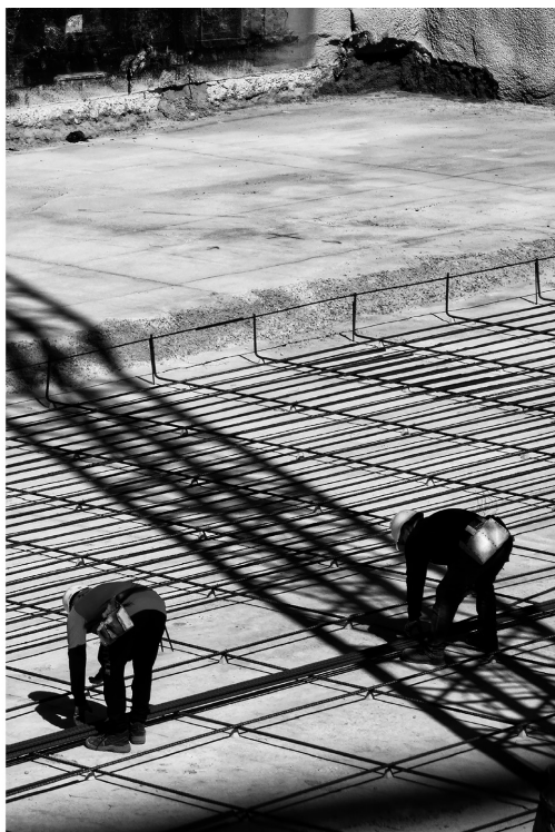
Fig. 5 Fotografía de obra. Zuriñe Roscales. Dirección de Obra
