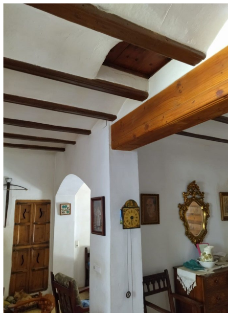
Fig. 9. Trampilla para la provisión de los sacos de hoja de morera a la parte superior de la vivienda.
