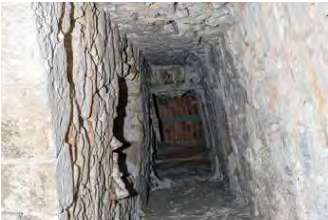
Detalle superior del primer pozo de necesarias
