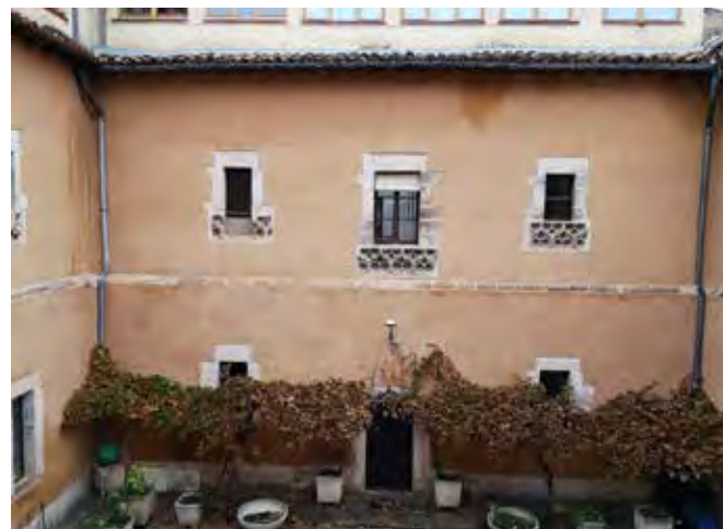
Patio del convento de Mercedarios Calzados, con los antepechos góticos
