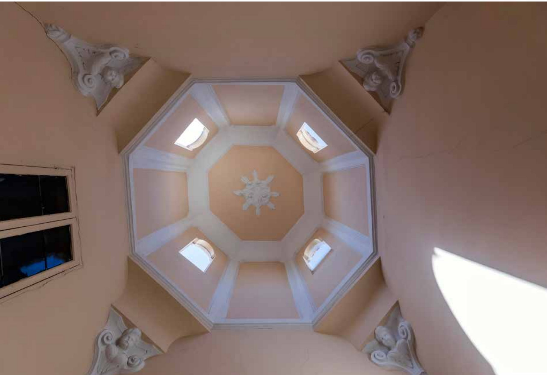
Cúpula de la escalera
