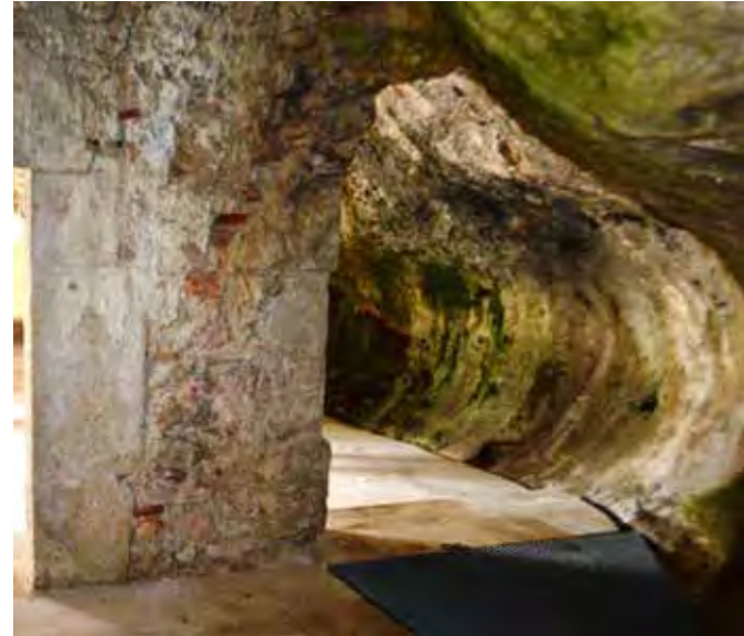
Sótanos con afloramiento de la roca madre
