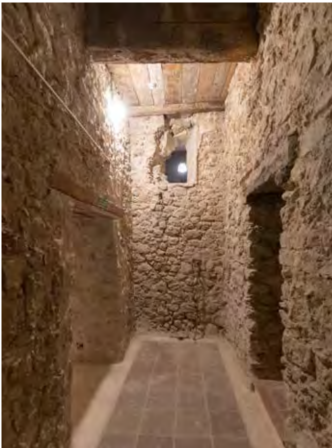
Muros de sostén en los pisos inferiores, después de la restauración
