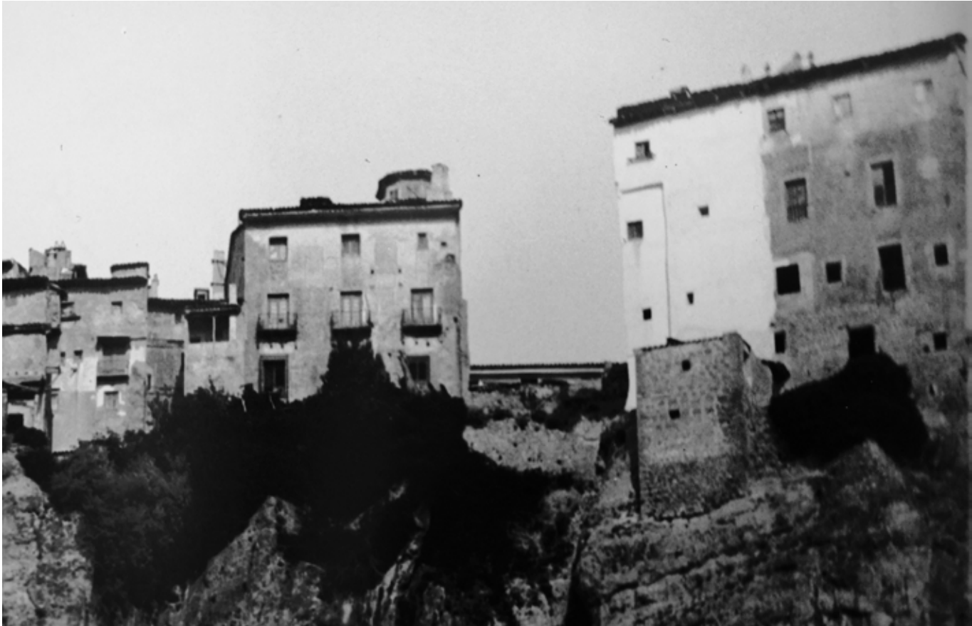
A la derecha de la imagen, edificio del antiguo Seminario hacia 1900
