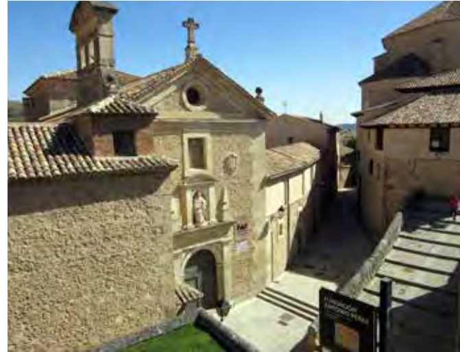
Antigua casa del ama y crujía anexa en la actualidad
