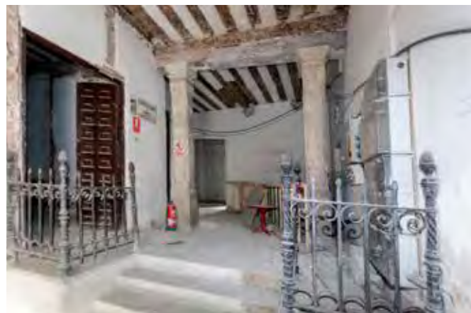
Zaguán de la casa del Corregidor, antes de la restauración
