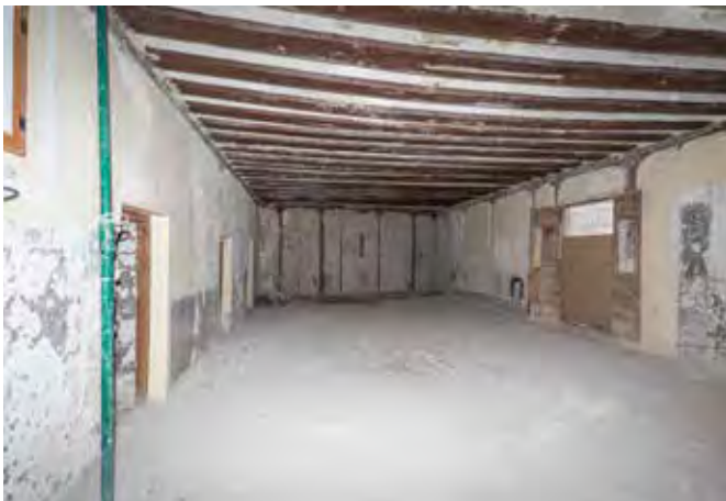
Sala de presos en el nivel menos dos respecto de la cota cero, antes de la restauración
