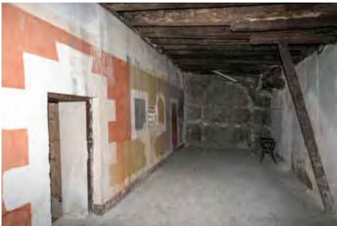
Antigua caballeriza, antes de la restauración
