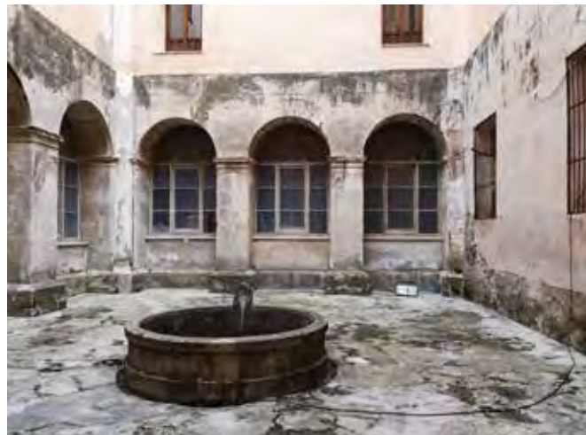
Patio Nuevo, en la tercera fase. A la derecha, el muro de separación con la primera fase
