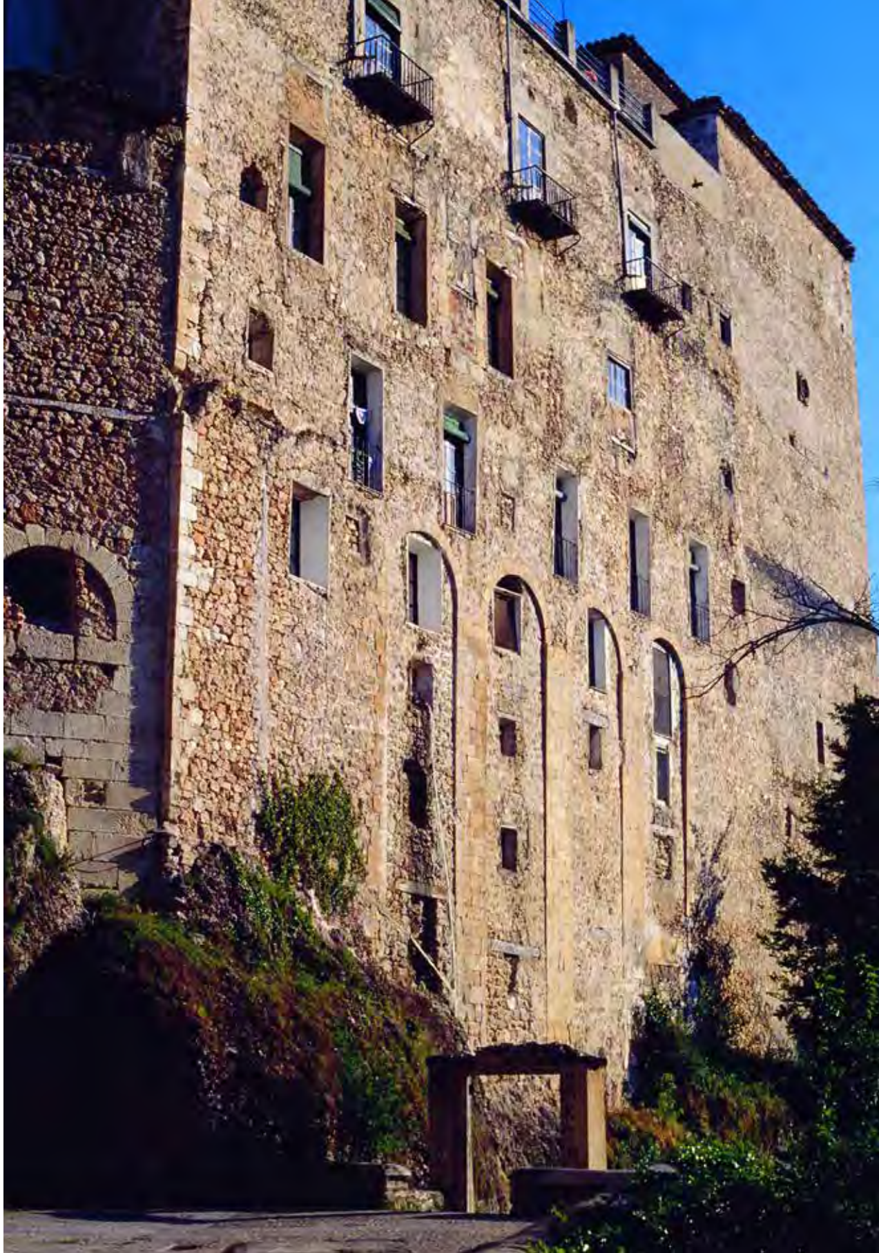
Fachada a la hoz del Júcar de la casa-palacio de los marqueses de Cañete, antes de ser revocada
