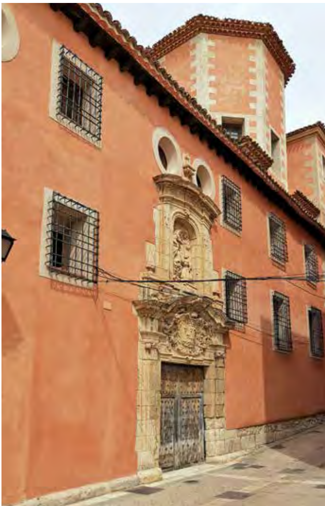
Fachada a la calle de la primera fase, con la portada de la capilla y el cimborrio de la escalera
