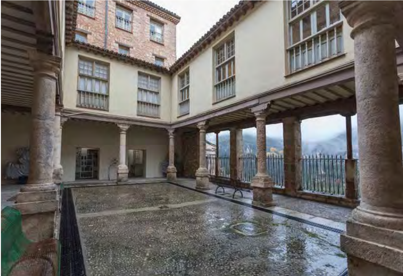
Claustro en la actualidad. A la derecha, corredor renovado en 1651
