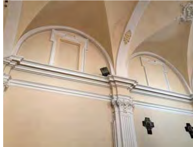
A la izquierda, ventana tapiada en el muro noroeste de la capilla
