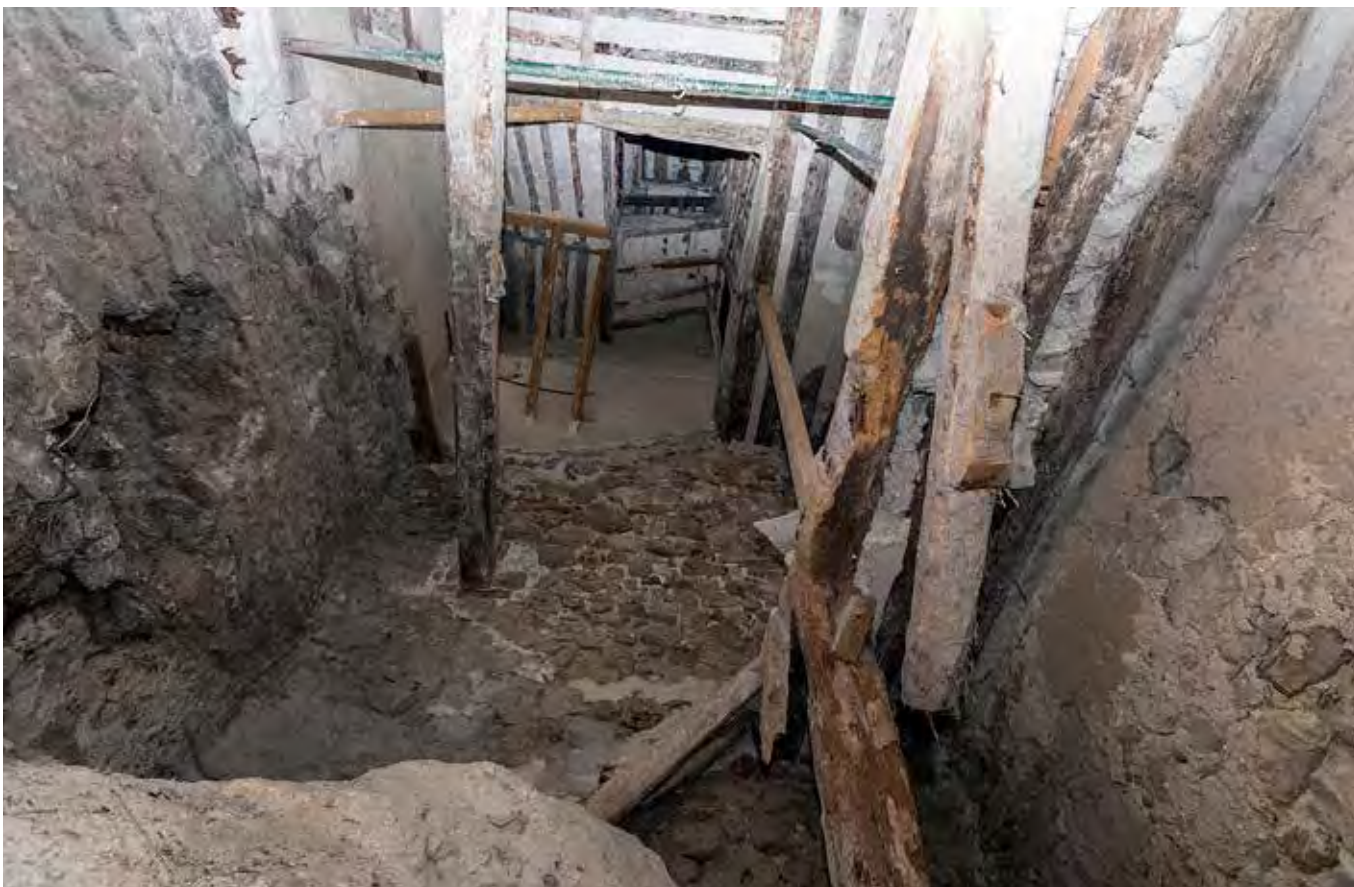
Escalera de la cárcel, que nunca habría podido enlazar con las antiguas carnicerías situadas debajo
