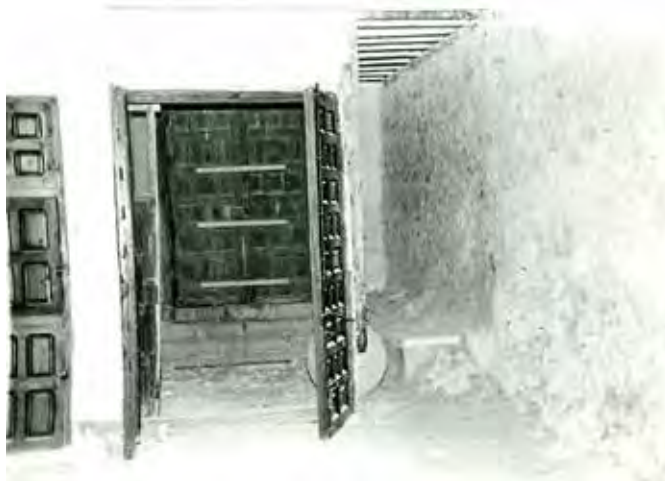
Estado anterior a la restauración de la portería y el locutorio externo, con el torno a la izquierda
