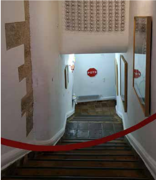
La nueva escalera denominada de Covarrubias pasando bajo el suelo de la antigua cocina
