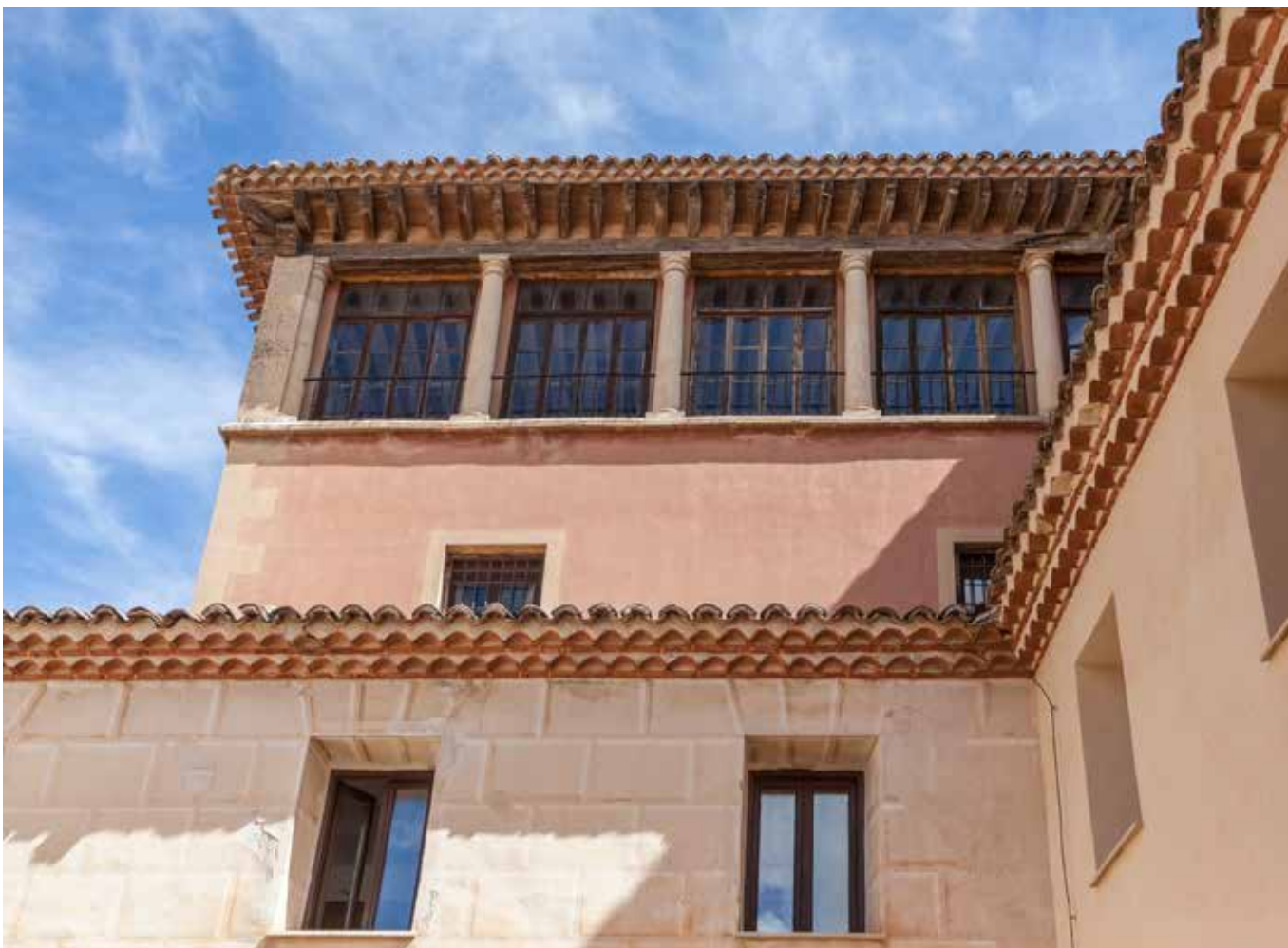
Columnata de orden toscano de la galería, desde el patio Nuevo
