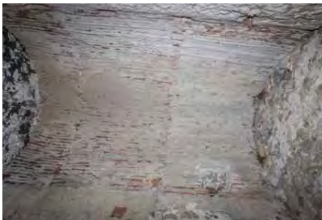
Bóveda de cañón en ladrillo de la celda interior
