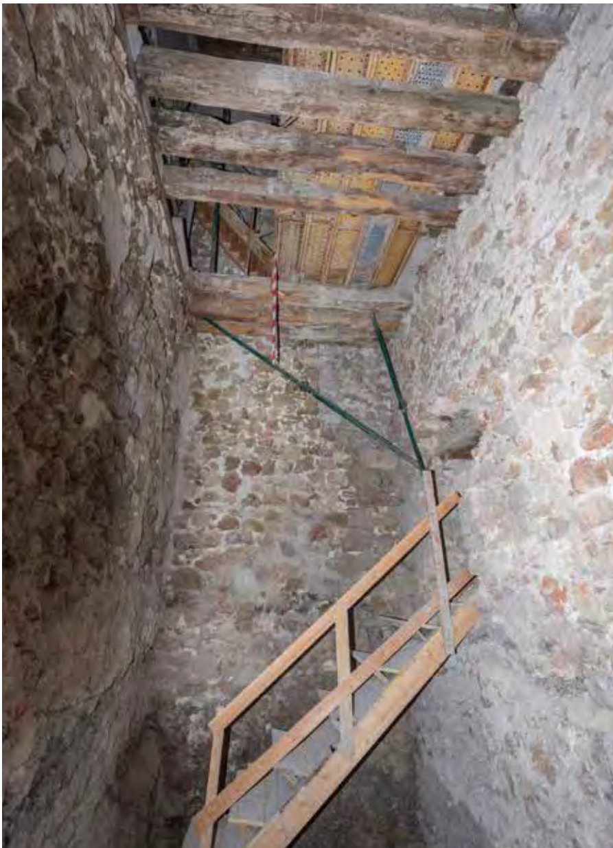
Estructuras de la cárcel, antes de la restauración
