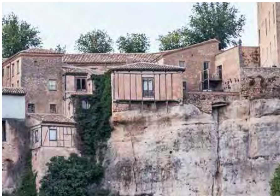
Desde la esquina de la Inquisición a la derecha, al cuarto del coro a la izquierda, primera fase del convento en el Castillo
