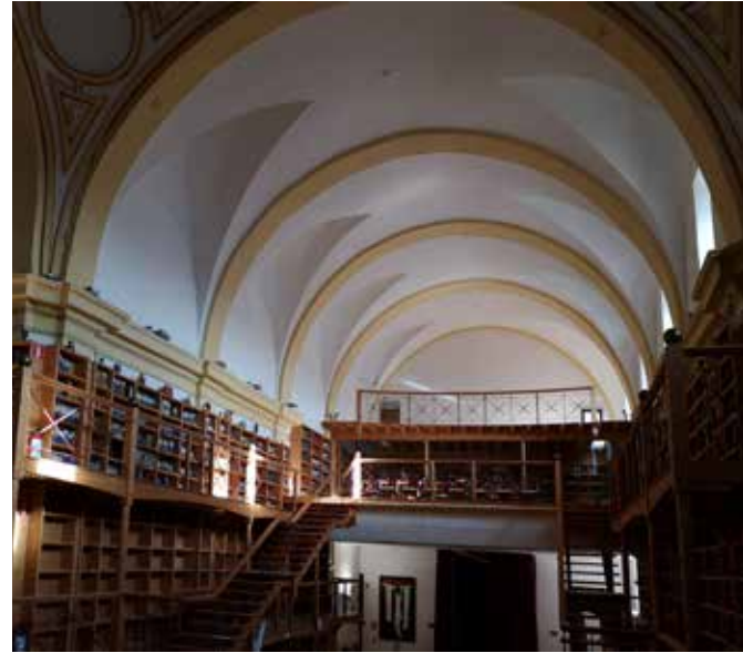
Nave de la iglesia de Mercedarios Calzados
