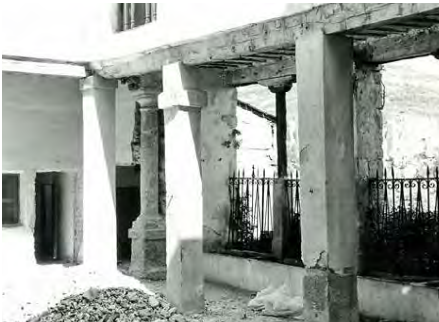
Corredor del lado de la hoz del Huécar antes de la restauración
