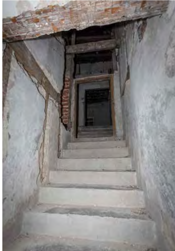
Escalera de acceso a la cárcel real
