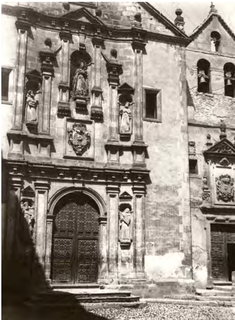
Portadas de la iglesia y del convento de Mercedarios Calzados, según una fotografía antigua
