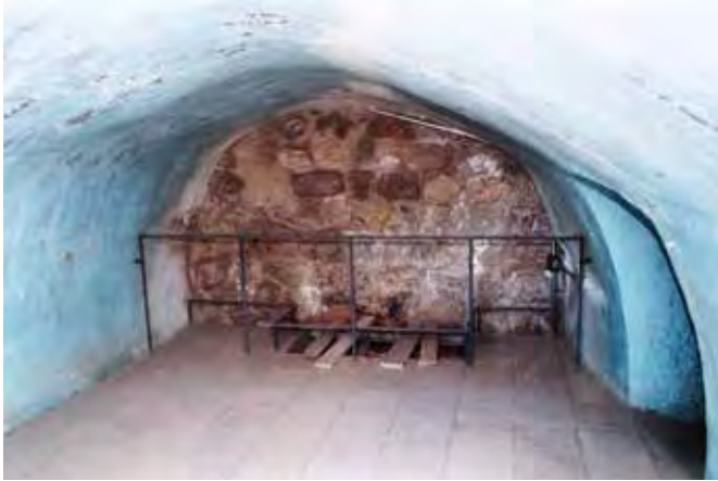
Bóveda del torreón Hurtado de Mendoza, con la muralla del Alcázar al fondo
