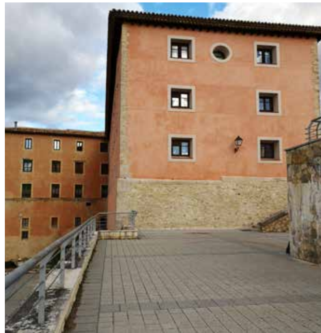
Fachada oeste de la segunda fase y, en primer término, solar de la casa de los condes de Siruela
