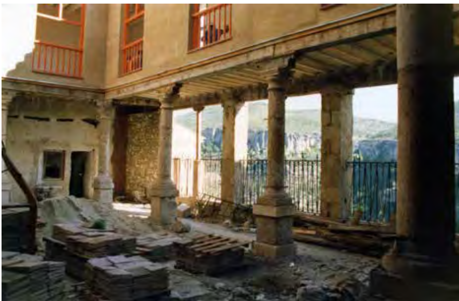
El claustro en restauración. Al fondo, el refectorio y la cocina de 1604
