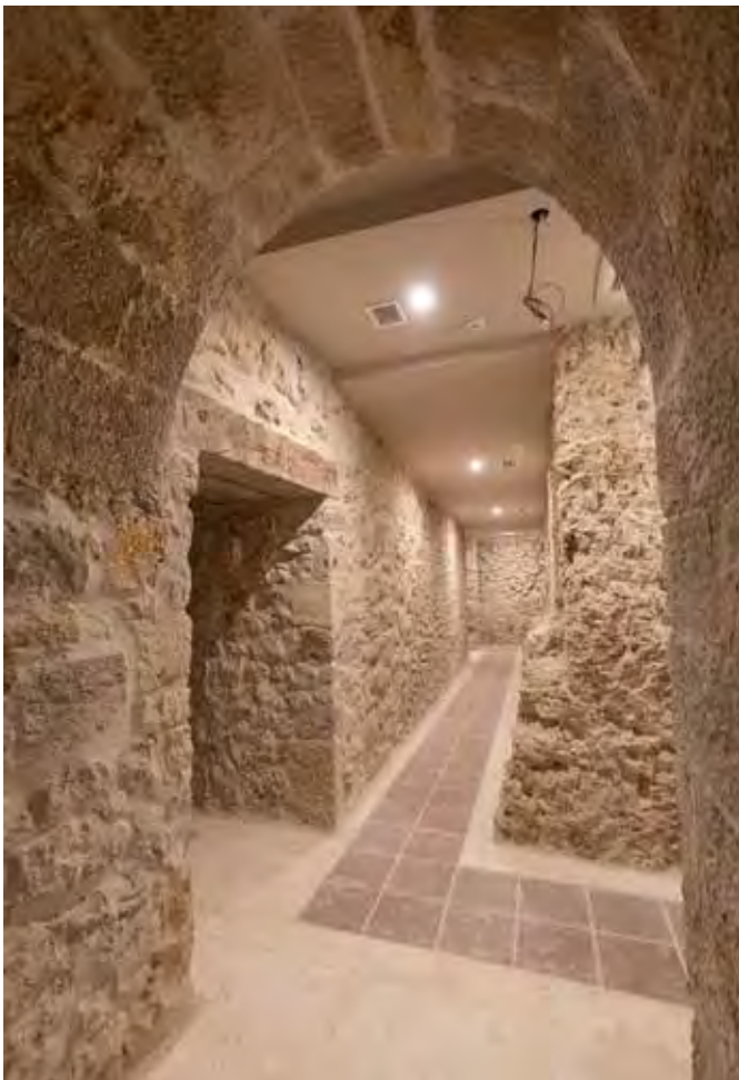
El pasadizo con arco de cantería tras la restauración, con los gruesos muros de sostén
