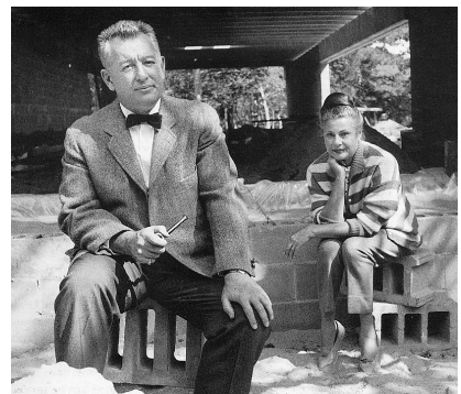
Gordon i Nina Bunshaft asseguts als blocs de les parets
