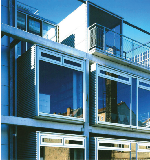
Mòduls prefabricats sobre l'estructura prefabricada de formigó
