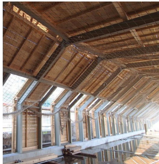
Estructura de suport de la coberta
