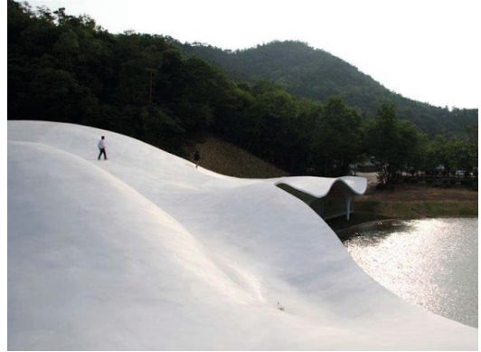
Losa ondulada de la coberta
