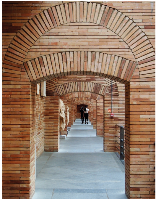
Arc de descàrrega de les sales laterals
