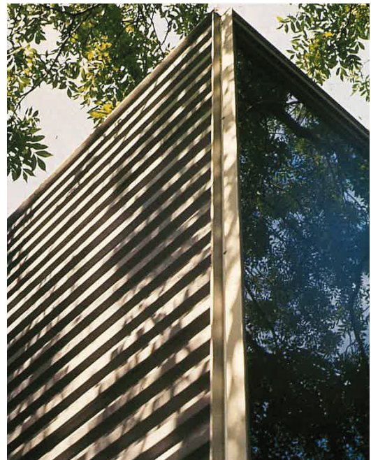
Façana lateral de xapa metàl·lica
