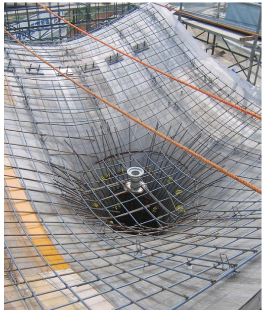
Encofrat del pilar, l'armadura i el desguàs al centre
