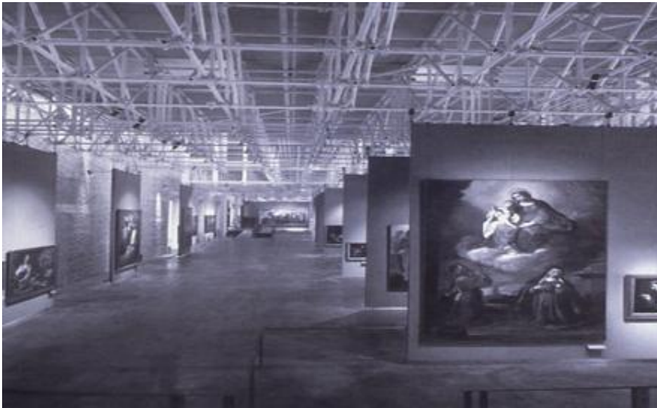
Fig. 6.2 Estructura espacial para integración de instalaciones.
