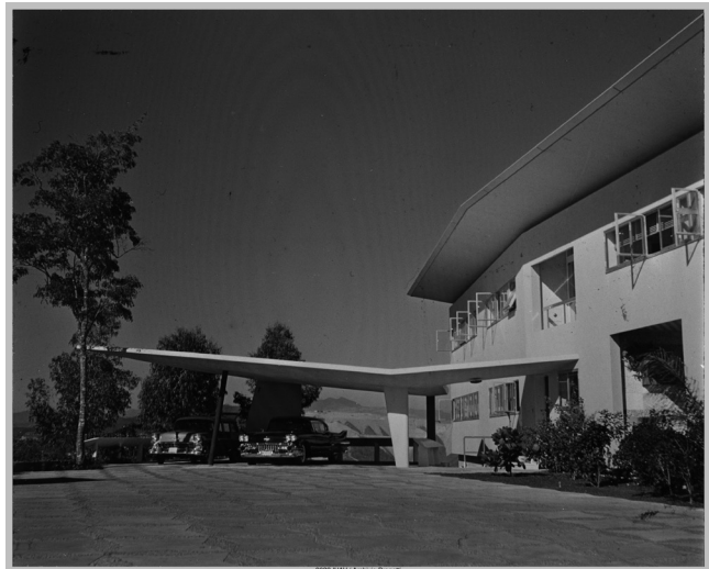
Villa Planchart, marquesina de entrada en el alzado este, 1961. Paolo Gasparini. Cortesía Fondo Giorgio Casali, Archivio Progetti, Università Iuav de Venecia.
