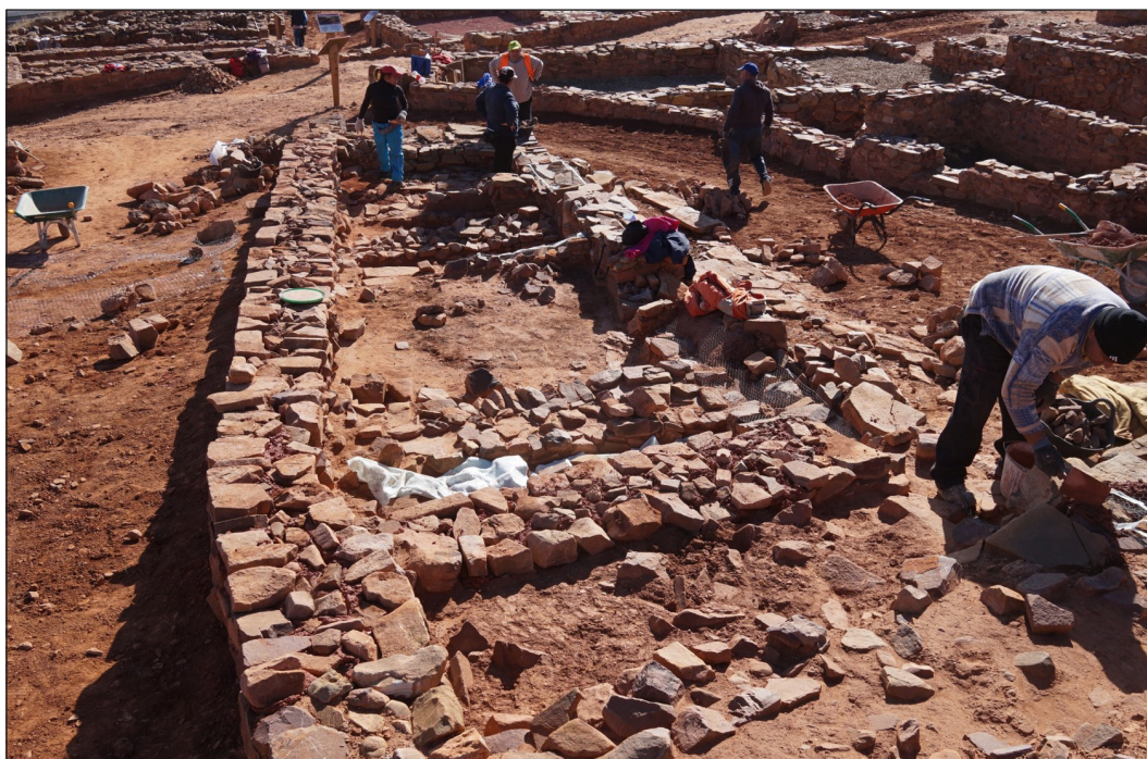
Figuras 5, 6 y 7. Reintegración de morteros y mampostería en edificios poco afectados.
