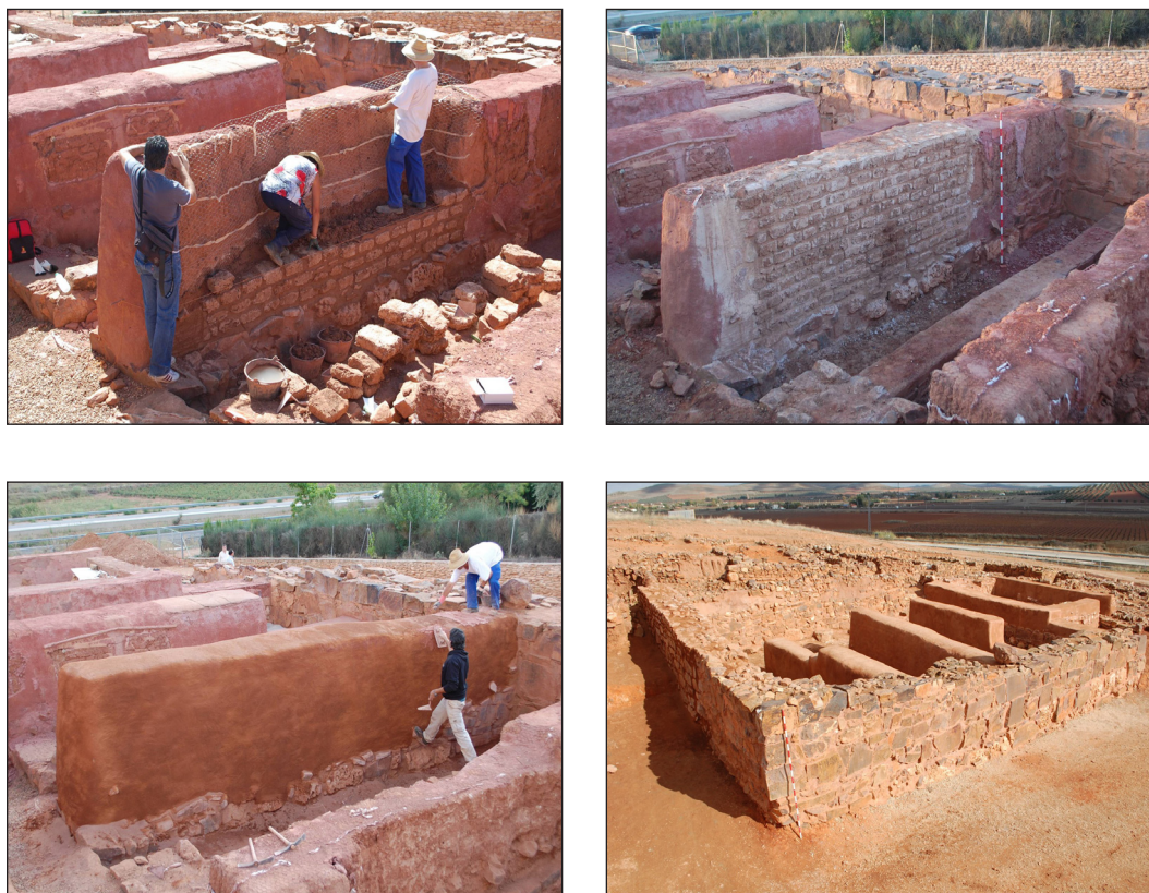
Figuras 8-II. Proceso de restauración de una estructura dañada parcialmente por la lluvia.
