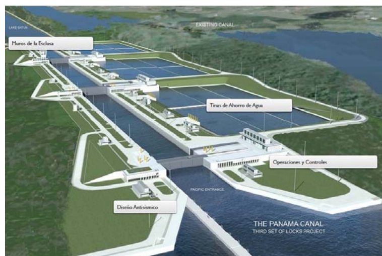
Fig 1. Expansión de la Tercera Esclusa del Canal de Panamá
