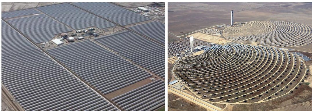
Figura 9.5. Centrals solars tèrmiques. Esquerra: parc termosolar Andasol I (Espanya), de col·lectors de cilindres parabòlics i un sistema d'acumulació tèrmica per sals foses. Dreta: plantes solars de torre, PS01, en primer terme, i PS02, en segon terme, amb els heliòstats respectius (Espanya)
