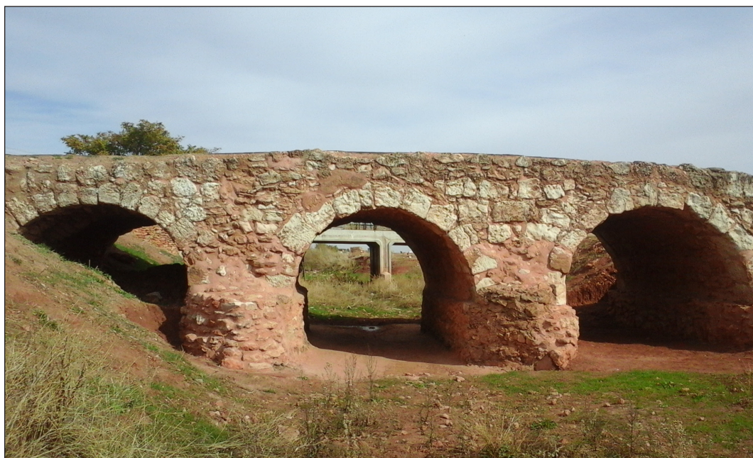
Figura 5. Fotografía del Puente Viejo del Azuer.
