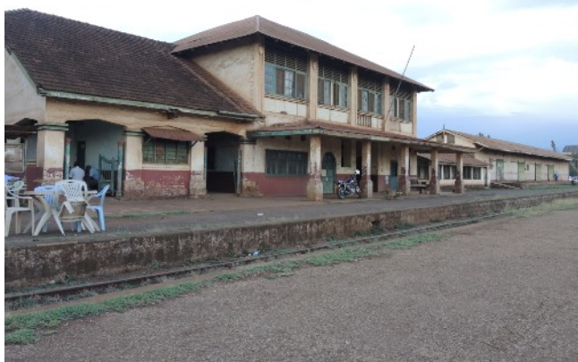
Figura. 03 Edificio principal de la estación de tren. Moshi. Fuente: (García, 2017)
