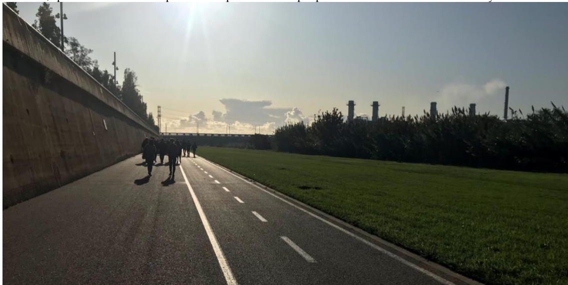
Fig. 3 Parque Fluvial del Besòs. Fuente: Fotografía propia (2019)
