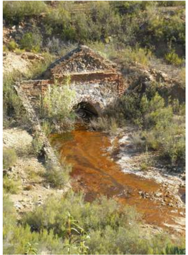
Figura 4.47: Lixiviados ácidos de la galería Los Cepos antes del vertido de La Zarza (septiembre de 2011).
