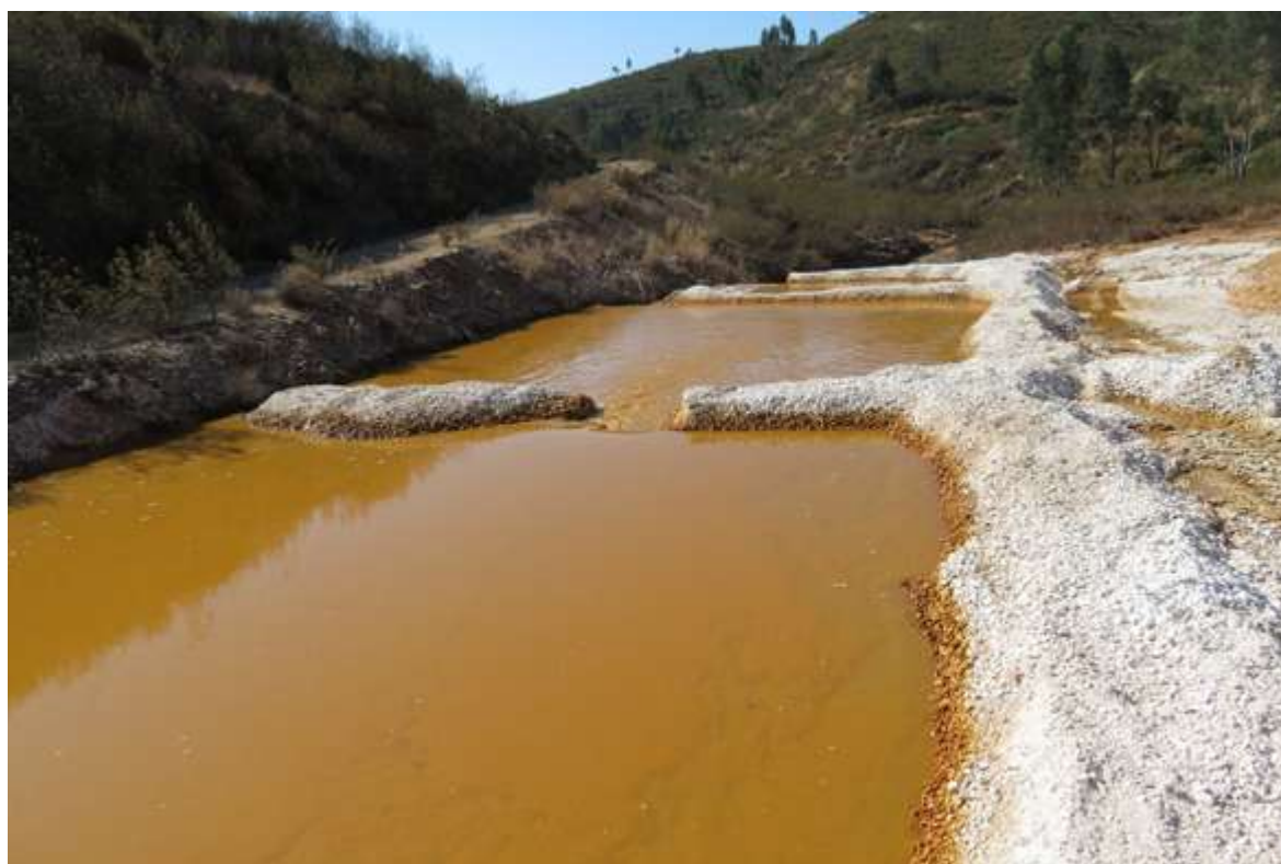
Figura 4.49: Adición de grava caliza para el tratamiento de las aguas ácidas tras el vertido de La Zarza (mayo de 2017).
