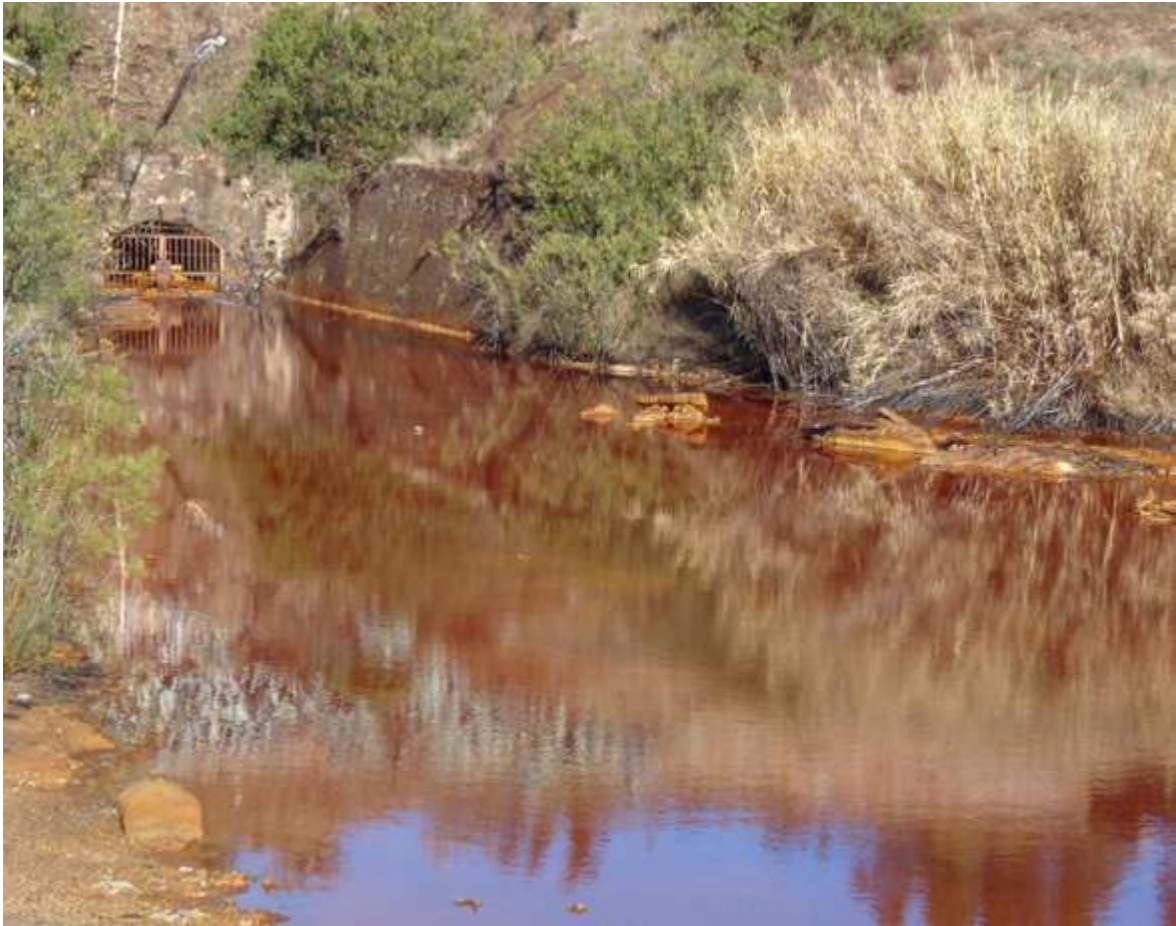
Figura 4.8: Salida de aguas ácidas del Túnel 16 (parte superior izquierda de la fotografía) hacia el río Tinto.
