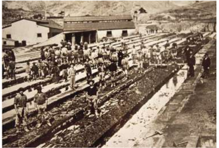
Figura 3.10: Canaleo en las minas de Riotinto para la cementación del cobre en la primera mitad del siglo XX (Fundación Riotinto).
