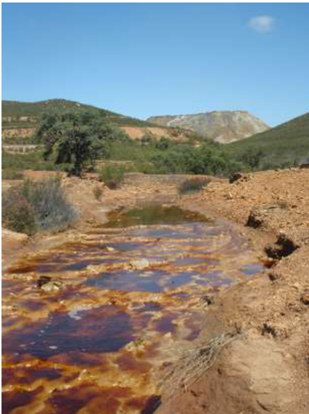
Figura 4.33: Fotografía del rivera San Agustín, principal aporte de AMD al río Meca, con las escombreras de Filón Sur y Corta Esperanza al fondo
