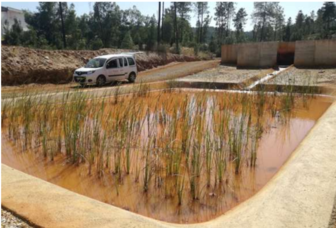
Figura 7.30: Aparición espontánea de Typha domingensis (enea) en la balsa de decantación 1, mostrando la notable mejora de la calidad del agua de entrada.
