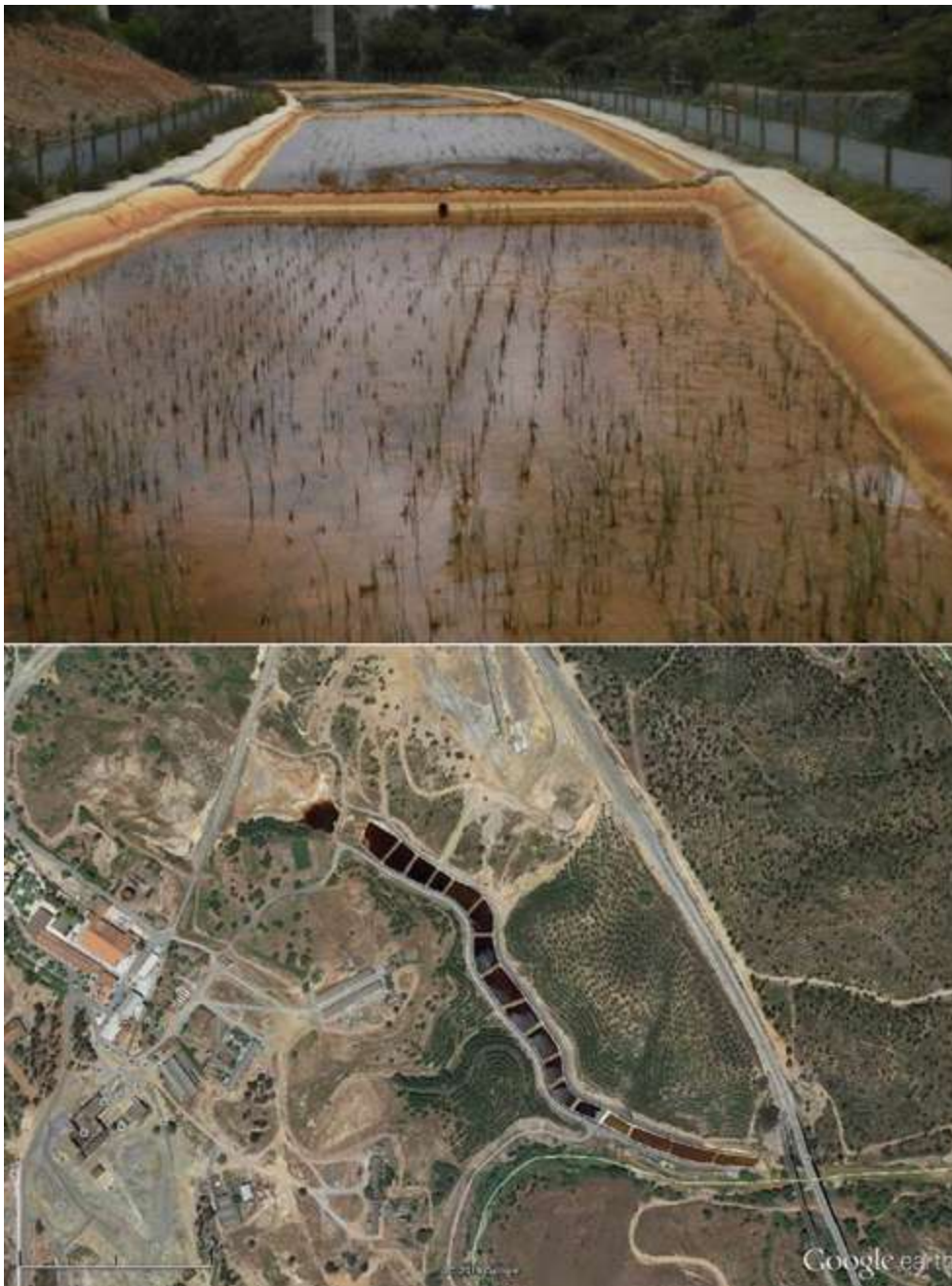
Figura 7.15: Fotografía e imagen aérea del humedal construido en la mina de Lousal, que tiene problemas de funcionamiento por la alta carga de metales (Portugal).
