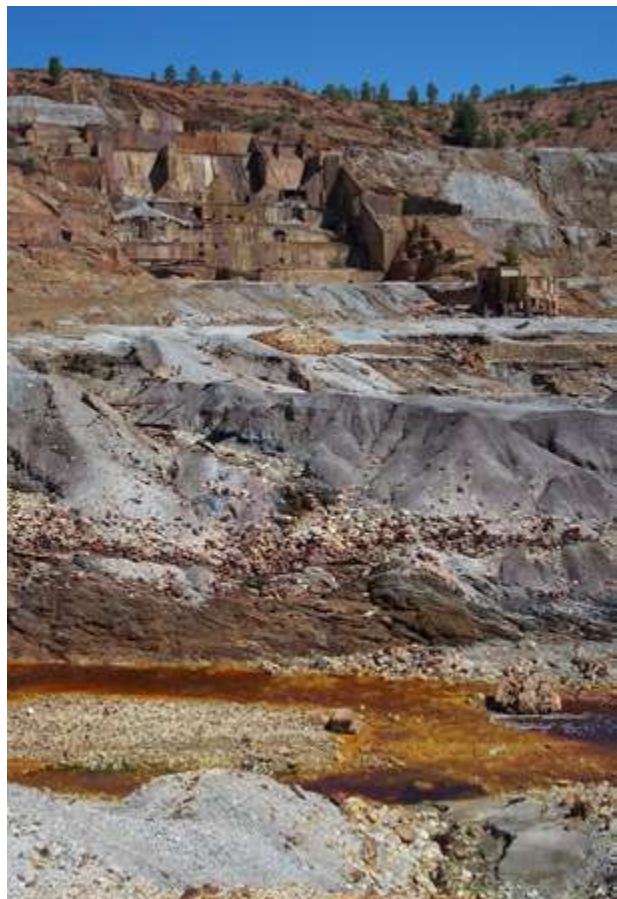
Figura 2.6: Residuos del tratamiento del mineral e instalaciones mineras abandonadas junto al río Tinto (zona de Zarandas-Naya).
