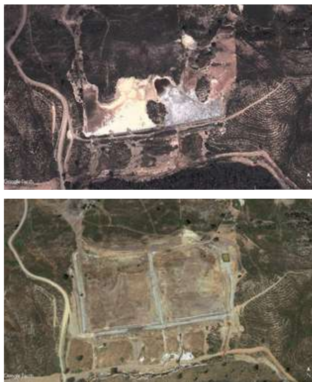
Figura 7.8: Imágenes aéreas de las balsas de lodos pirífticos (“tailings”) en la mina de Monte Romero. Previamente a la instalación (arriba, junio 2009) y tras la instalación de la cubierta (abajo, julio 2013).
