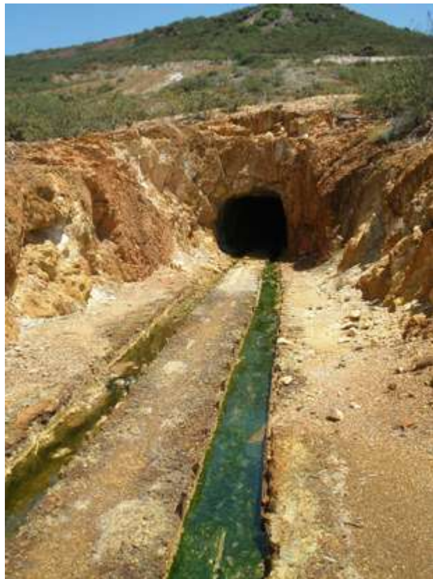
Figura 4.34: Lixiviados ácidos de color verdoso de la Galería La Sabina (minas de Tharsis) que confluyen en el arroyo de Valdeoscuro.
