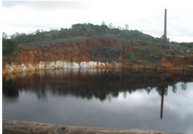
Figura 2.5: Corta inundada con aguas ácidas de la mina Confesionarios.
