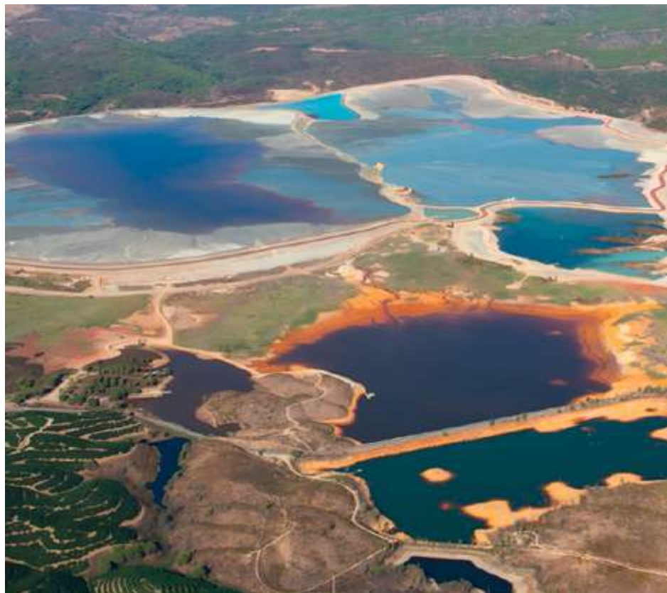
Figura 3.13: Balsas de lodos del Gossan y del Cobre de las minas de Riotinto construidas en los años 70 del pasado siglo y que actualmente están siendo recreadas para almacenar los residuos de la nueva explotación.
