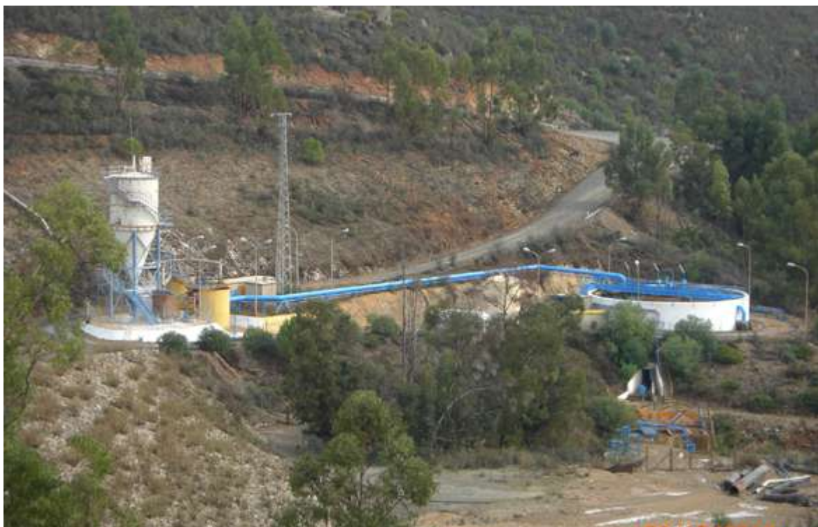
Figura 7.12: Planta de tratamiento activo de Almagrera (actualmente no operativa). Fotografía de Francisco Javier Rodríguez Gallardo.
