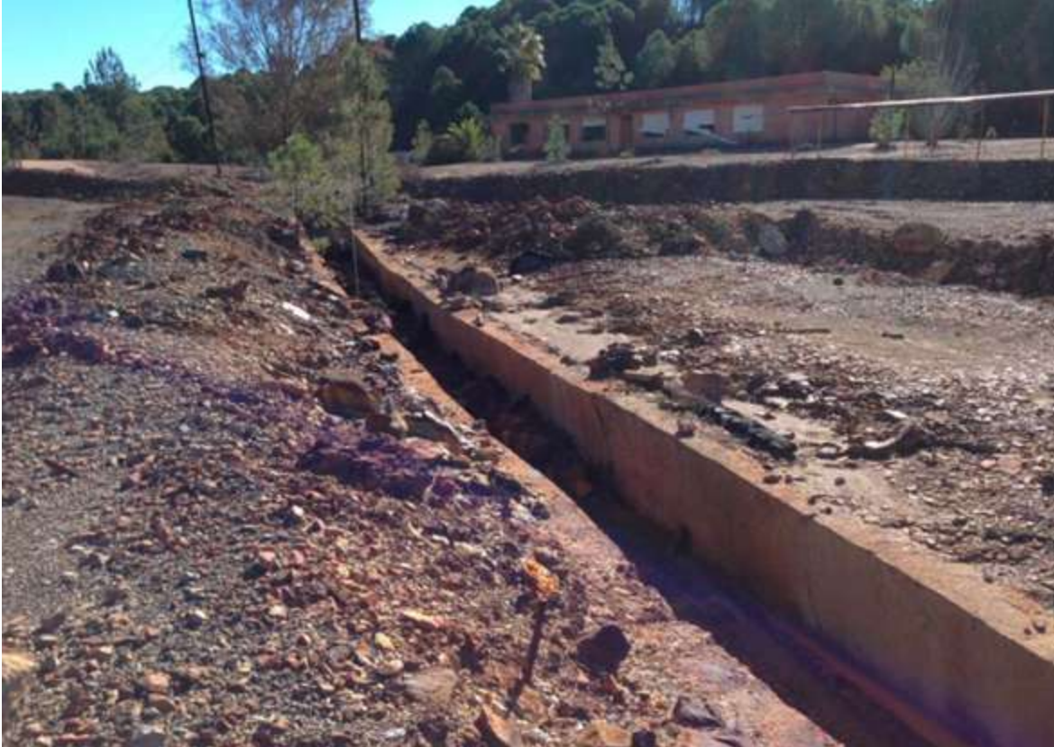
Figura 7.4: Fotografía de un canal perimetral en el entorno de la Mina de Riotinto.
