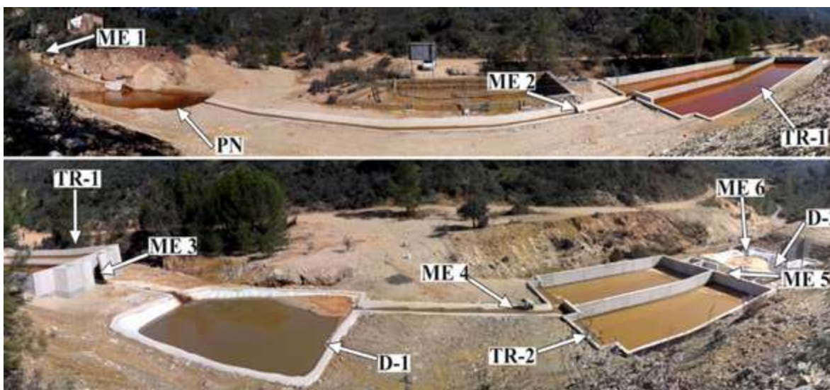
Figura 7.23: Panorámica del sistema de tratamiento pasivo de Mina Esperanza, el agua entra por la parte superior izquierda y sale por la inferior izquierda.
