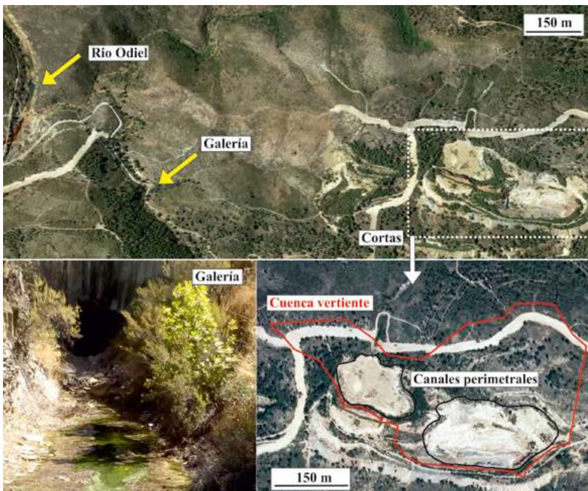
Figura 7.3: Imágenes aéreas y fotografía del vertido de Mina Poderosa, indicando la cuenca vertiente a las cortas y la posible ubicación de los canales perimetrales para reducir los lixiviados ácidos generado (imágenes aéreas obtenidas de Google Earth).
