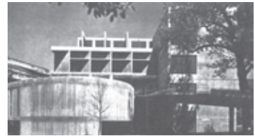
Figura 10. Vista parcial exterior.
