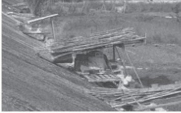
Figura 8. Estructuras en márgenes de contención.
