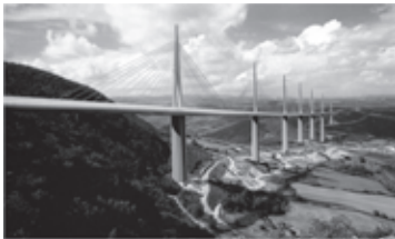
Figura 46. Viaducto visto desde el lado sur.
