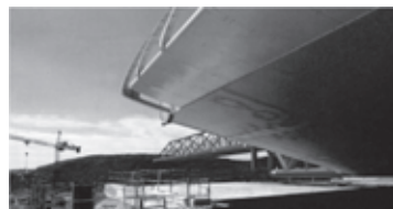
Figura 35. Estructura de lanzadera encuentro y tablero semi terminado.
