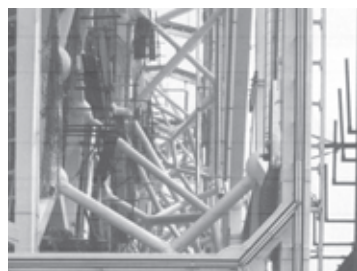
Figura 37. Detalle estructura fachad.
