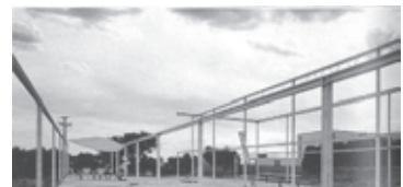
Figura 13. Montaje de estructura atomillada.
