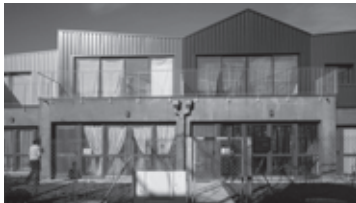
Figura 34. Módulos de viviendas en fachada sur.
