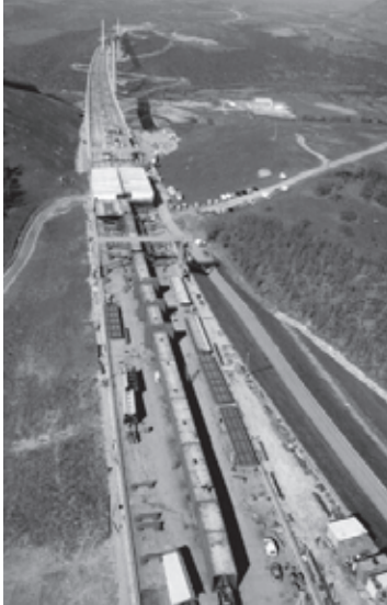
Figura 27. Transporte de vigas cajón.
