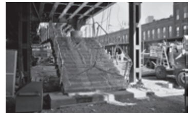
Figura 21. Reforma estructural para paso escalera
