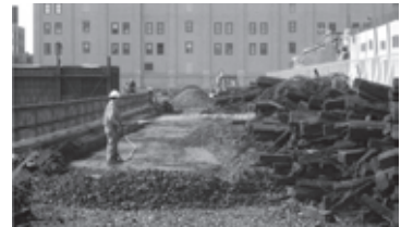
Figura 14. Desmonte de gravas y tierras.
