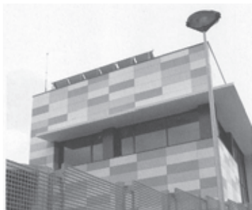
Figura 4. Fachada de hormigón polímero.
