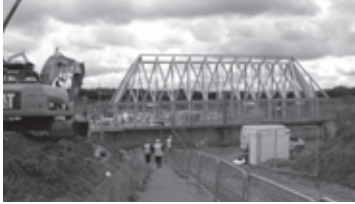
Figura 5. Construcción y laguna desecada.
