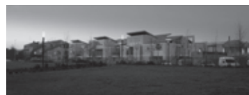
Figura 45. Vista nocturna del conjunto.
