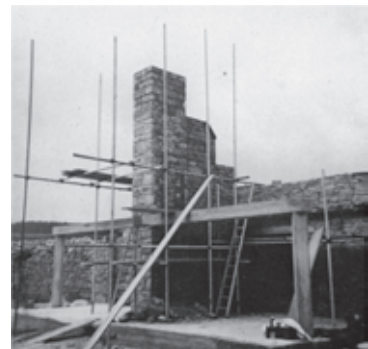
Figura 9. Construcción, forjado techo planta baja.
