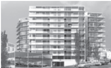
Figura 18. Viviendas en Saint Nazaire, obra final.
