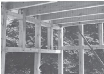
Figura 13. Roblonado elementos estructurales.
