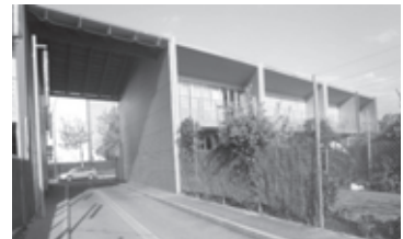
Figura 53. Parcial de fachada a patio.
