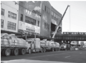
Figura 16. Acopio material en cruces con calles.
