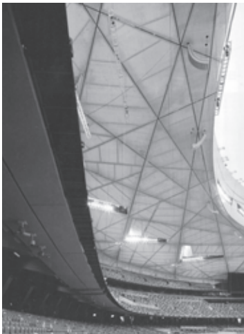
Figura 53. Interior estadio con los dos voladizos.
