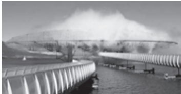
Figura 40. Pasarelas de acceso y salida.
