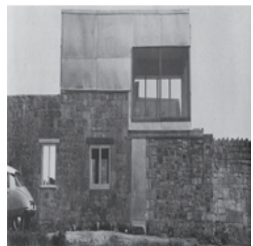
Figura 16. Fachada a calle y coche Citroën.
