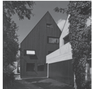
Figura 10. Vista exterior de la reforma.
