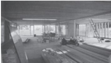
Figura 15. Madera en bruto a pie de obra.
