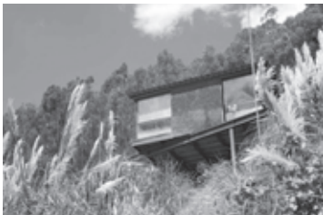
Figura 3. Casa en una ladera.
