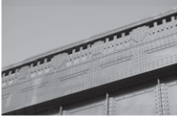
Figura 22. Restauración de pintura.
