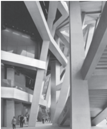
Figura 47. Vista intradós de graderío.
