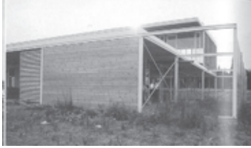
Figura 25. Ubicación cuarto instalaciones.
