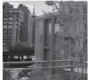
Figura 37. Final tramo terminado y ascensor.
