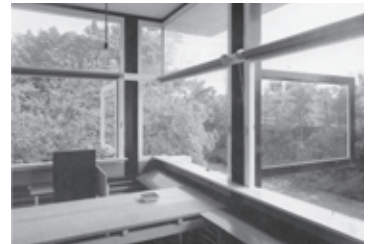
Figura 31. Ventanas en esquina, sala estar.
