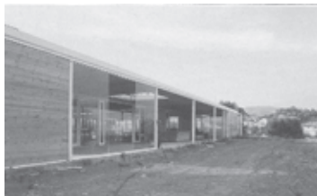
Figura 28. Vista exterior fachada sur.
