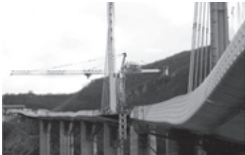
Figura 31. Mástil, puntales y flechas del tablero.
