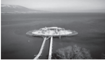
Figura 39. Edificio nube en posición de reposo.
