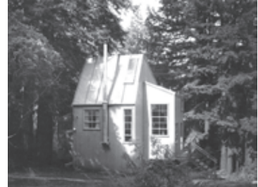
Figura 34. Fachada a sur-oeste.
