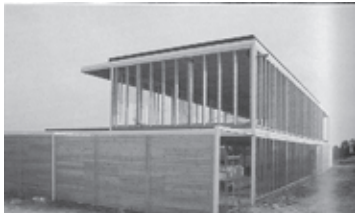
Figura 16. Construcción de cerramientos.
