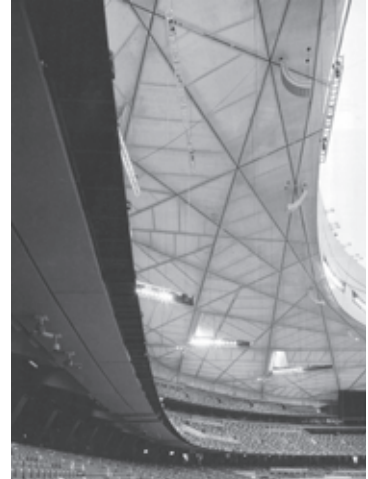
Figura 54. Detalle estructura marquesina.
