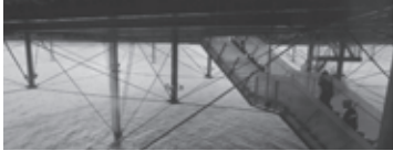
Figura 46. Estructura bajo la plataforma.
