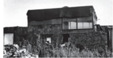
Figura 14. Cubierta provisional y cierre de plástico.
