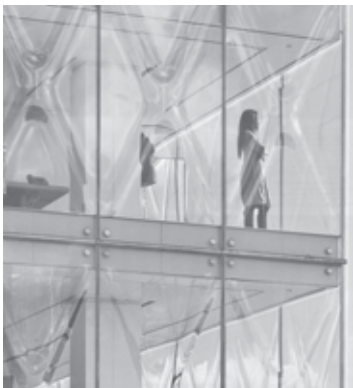
Figura 14. Montaje del vidrio en fachada.
