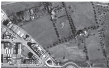
Figura 1. Situación de la granja y casa de Reus.
