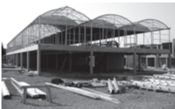
Figura 10. Edificio en construcción.
