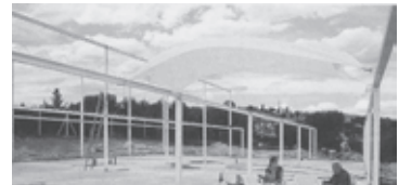
Figura 12. Plancha de cimentación y estructura.
