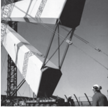
Figura 39. Transporte del mástil sobre el tablero.
