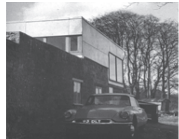
Figura 15. Resalte en muro y vidrios restituidos.
