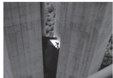
Figura 21. Parte superior de la pila, bajo tablero
