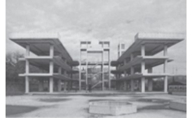
Figura 1. Estructura inicial de hotel.
