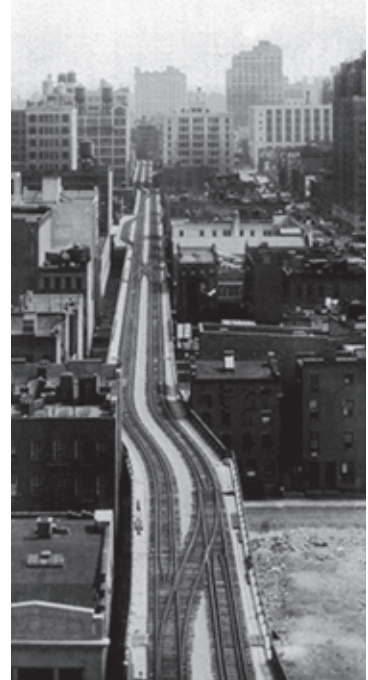
Figura 4. Tramo central de la línea férrea.
