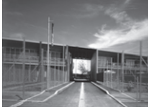
Figura 50. Fachada interior a sudoeste.
