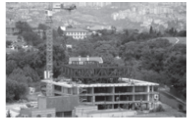
Figura 3. La obra en construcción.
