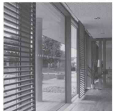
Figura 11. Nivel entre pavimentos dentro fuera.
