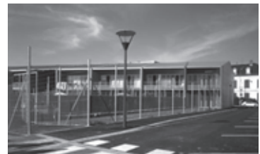
Figura 55. Vista exterior desde calle transversal.
