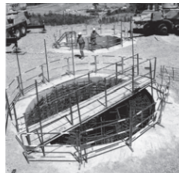
Figura 16. Cimentación de un pilote de la pila.
