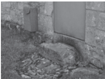
Figura 26. Peldaño de entrada a la casa.
