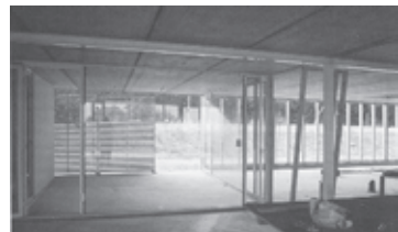
Figura 19. Montaje de fachadas.
