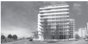
Figura 19. Viviendas en Saint Nazaire, obra final.
