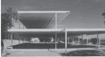
Figura 14. Losas de hormigón prefabricadas.
