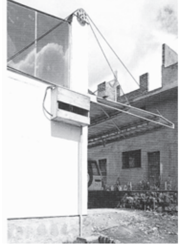
Figura 10. Detalle soporte marquesina garaje.
