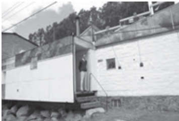
Figura 8. Vista del acceso y fachada a calle.
