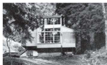
Figura 29. Fachada sur y gran vidriera.
