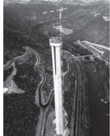
Figura 19. Pila en cota de tablero.
