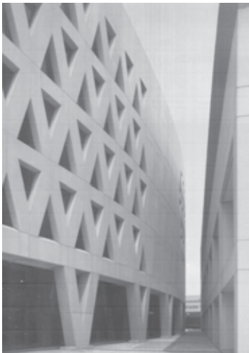
Figura 21. Escorzo de los dos edificios.
