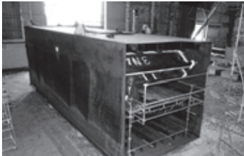
Figura 23. Ejecución cajón del tablero.
