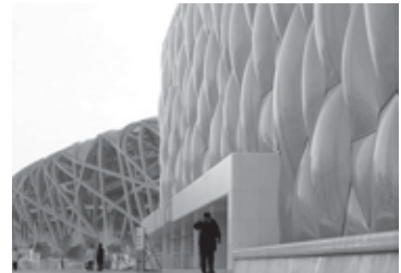
Figura 41. Vista parcial de las dos instalaciones.
