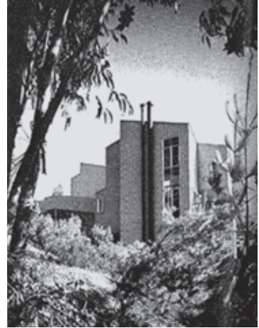
Figura 41. Fachada lateral (imagen reciente).
