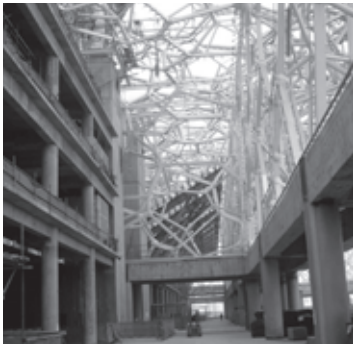
Figura 33. Estructura interna de hormigón.
