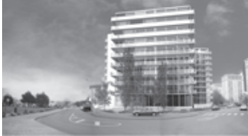
Figura 17. Viviendas en Saint Nazaire, estado actual.
