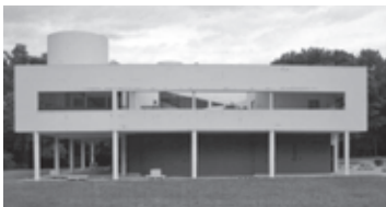
Figura 3. Ville Savoie, fachada principal.
