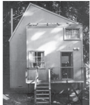
Figura 23. Escalera exterior y porche de acceso.
