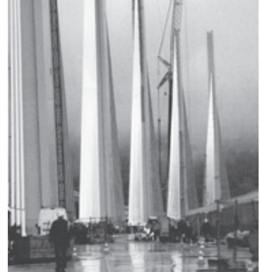
Figura 42. Colocación de cables.
