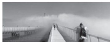
Figura 50. Pasarela de acceso.
