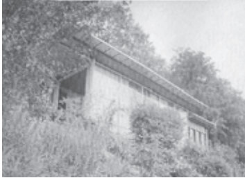
Figura 47. Vista fachada sur.
