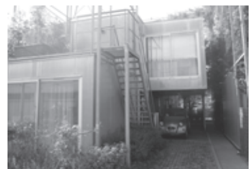
Figura 28. Pasaje y paneles sandwich en fachadas.
