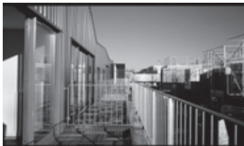
Figura 35. Módulos de viviendas en fachada sur.
