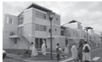
Figura 44. Vista general exterior.
