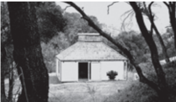
Figura 7. Exterior y puerta de acceso.
