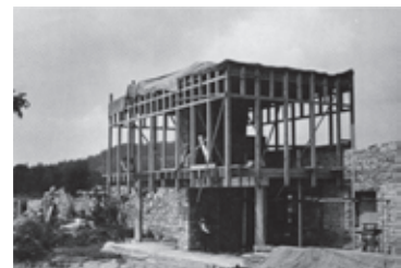
Figura 10. Estructura de madera.
