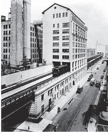
Figura 1. Línea férrea en servicio.
