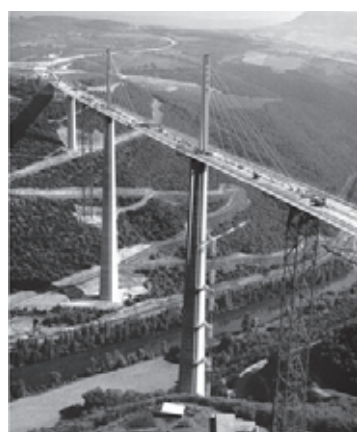
Figura 38. Puente en fase de construcción.
