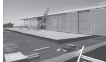
Figura 22. Cubierta de madera, tela asfáltica.
