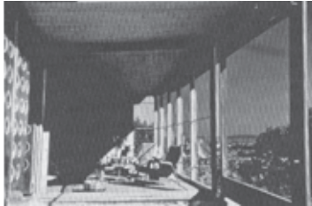
Figura 48. Vista terraza a sur y salón.
