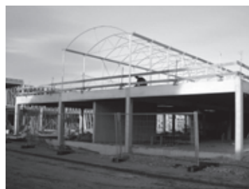
Figura 6. Visión transversal (en construcción).
