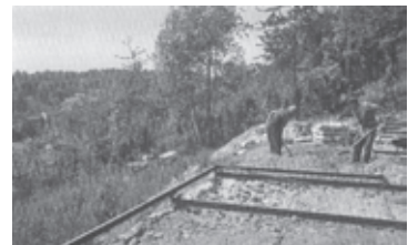
Figura 34. Construcción planche cimentación.
