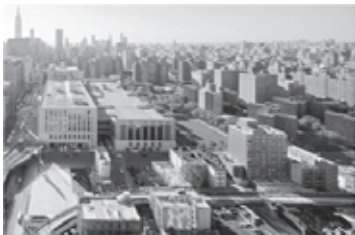
Figura 25. Final tramo 2 y ramal en ejecución.
