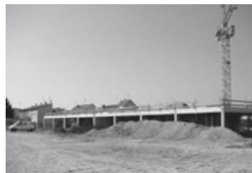
Figura 5. Visión longitudinal (en construcción).
