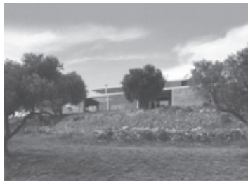
Figura 27. Vista desde cota inferior de solar.
