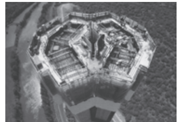
Figura 20. Detalle encofrados trepantes.
