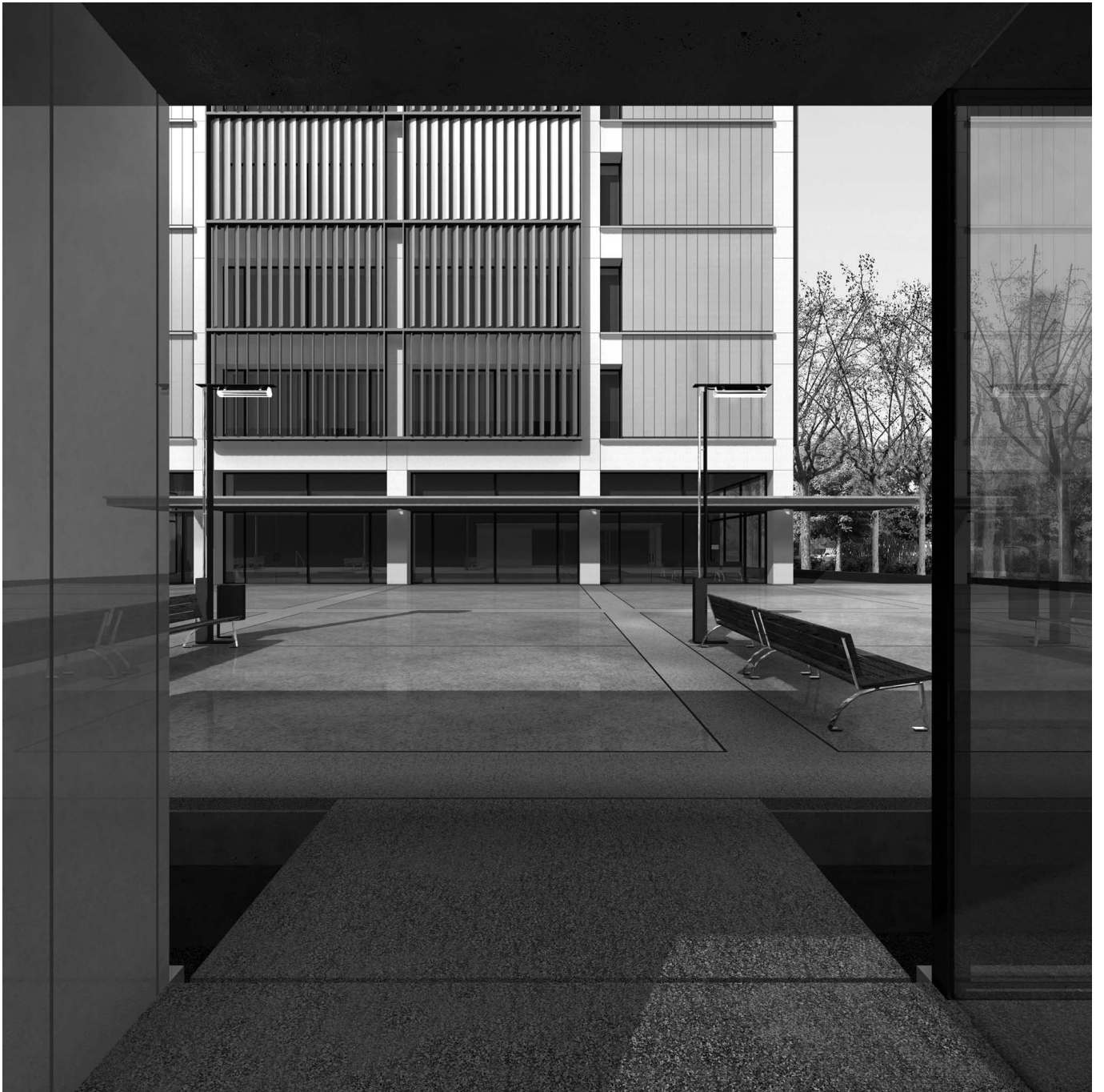
Torre de viviendas. L'Hospitalet de Llobregat, 2005
