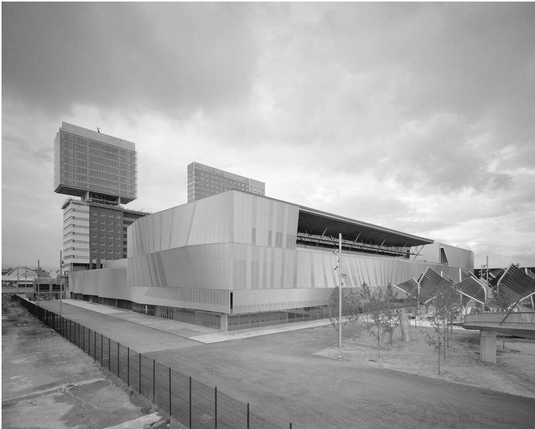
Fig. 5.12 Centro Internacional de Convenciones de Barcelona (2004)
