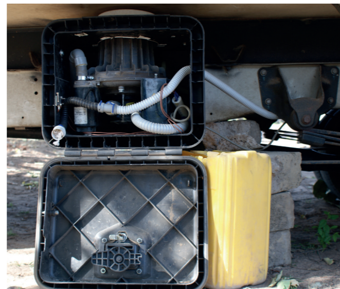
Bomba de succión de fluidos. Fuente propia.
