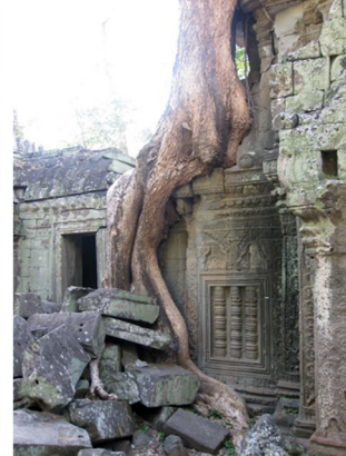
Fig. 57.3. Efectos diversos de las raíces de los árboles originados por la desecación del terreno o la fuerza expansiva y descontrolada en algunos templos asiáticos (Angkor, Siem Riap, Camboya).
