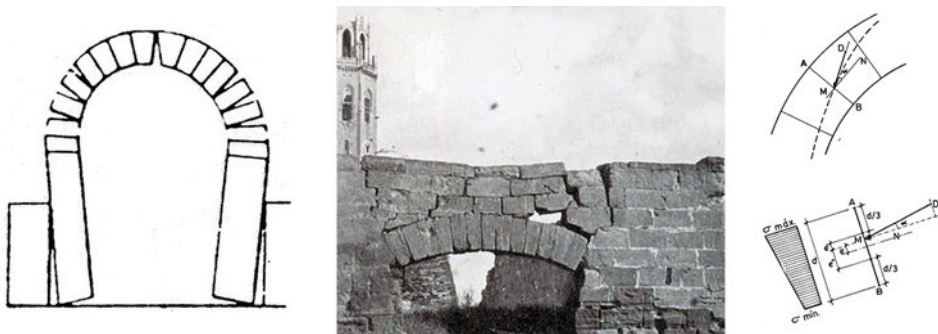
Fig. 25.5. En el gráfico de la izquierda, esquema de fisuración en una bóveda afectada por exceso de carga. En la fotografía, arco descomprimido por movimiento en uno de sus arranques. En los gráficos de la derecha, condición de deslizamiento entre dovelas, la cual se presenta cuando el ángulo DMN formado por la resultante y la normal al plano de la junta supera el ángulo de fricción entre dovelas.
