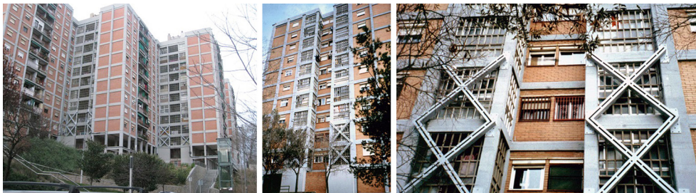
Fig. 30.1. Edificios de 12 plantas con estructura porticada de hormigón armado, con aspas metálicas de rigidización de los pórticos en las plantas inferiores para mejorar la absorción de las acciones horizontales del viento.
