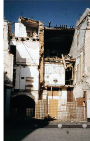
Fig. 3.2. Representación esquemática del proceso de desgaste de un muro de tierra afectado por la ascensión capilar del agua del terreno. En la fotografía, muro colapsado en su parte delantera coincidente con la parte saliente de la medianera, desprotegida de la acción del agua y sin conservación.
