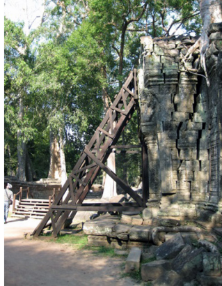
Fig. 57.3. Efectos diversos de las raíces de los árboles originados por la desecación del terreno o la fuerza expansiva y descontrolada en algunos templos asiáticos (Angkor, Siem Riap, Camboya).
