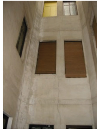
Fig. 1.2. Esquema de las líneas isostáticas de compresión en un edificio de varias plantas. En la foto, ejemplo de muro de ladrillo de 14 cm de grosor fisurado siguiendo también las direcciones del modelo de líneas isostáticas en un patio interior de ventilación de un edificio urbano.
