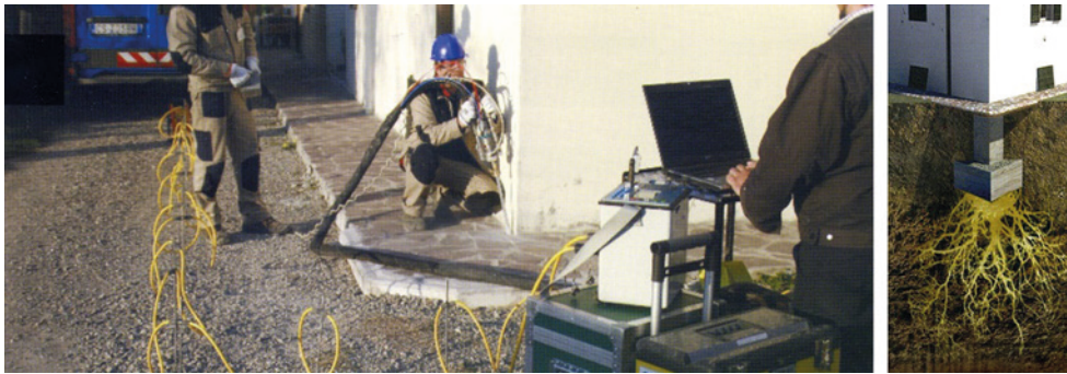
Fig. 28.7. Proceso de inyección de resina expansiva en edificio con daños por asentamiento diferencial. A la derecha, visionado del ámbito de penetración del producto en el terreno.
