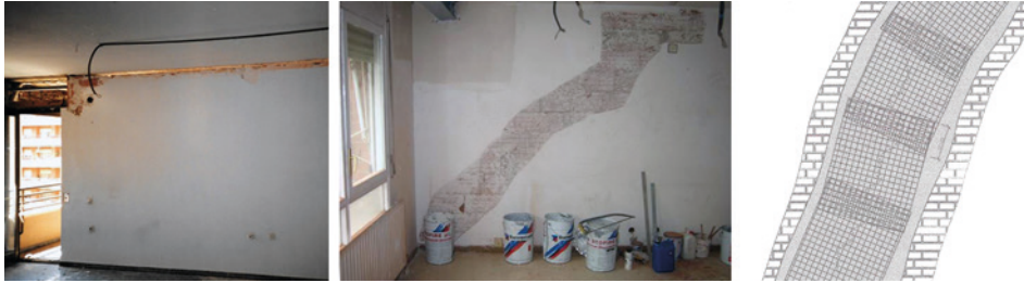
Fig. 19.6. En la foto de la izquierda, desatraque de la tabiquería antes de proceder a su sellado con material elástico. En la foto del centro, extracción del enyesado resiguiendo una grieta antes de proceder a su sellado con malla de fibra de vidrio embebida en el yeso de reposición, según se muestra esquemáticamente en el gráfico.
