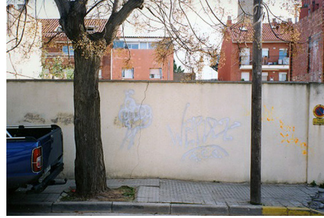
Fig. 57.2. A la izquierda, esquema de los posibles efectos de las raíces del arbolado sobre los edificios y los elementos de las instalaciones urbanas. A la derecha, ejemplo del efecto de las raíces sobre la pavimentación y la tapia próximas.
