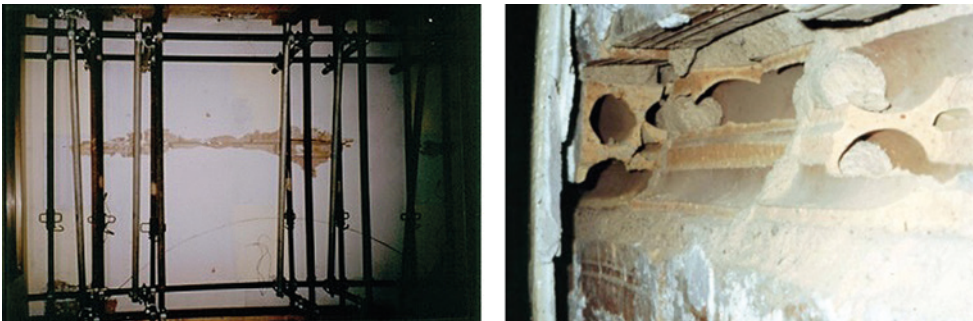
Fig. 4.1. Muro portante de ladrillo hueco de 14 cm de espesor roto bruscamente. En la cala de la foto de la derecha se percibe el aplastamiento de las piezas cerámicas de la hilada intermedia y la rotura vertical central.
