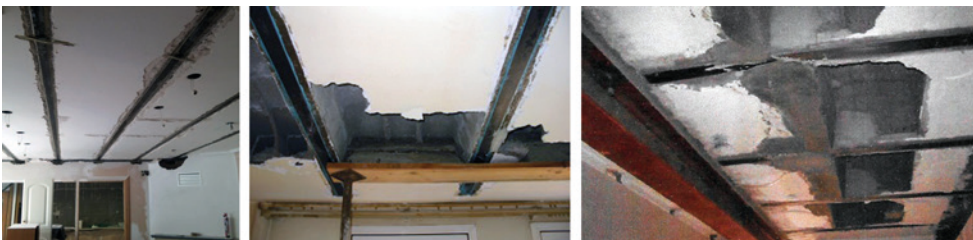
Fig. 15.3. En la foto izquierda y central, disposición de bandas de fibra de carbono para el refuerzo de viguetas. El tablón apuntalado en el extremo de las viguetas evita el despegue de las bandas durante la polimerización de la resina de adherencia en los lugares de máximos esfuerzos rasantes (efecto spalling). En la foto de la derecha, refuerzo a los esfuerzos de corte mediante macizado de los entrevigados en los extremos de las viguetas pretensadas, junto a una jácena plana con inercia reforzada por el perfil HPN inferior.
