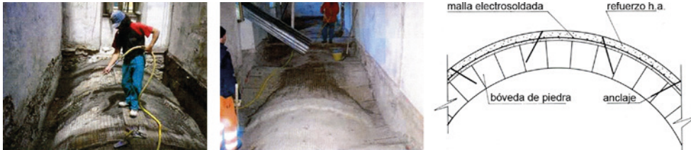
Fig. 25.9. En las fotos, ejemplo de puesta en obra de refuerzo a base de hormigón armado. En el gráfico, sección de regresado de hormigón armado anclado a una bóveda de piedra.
