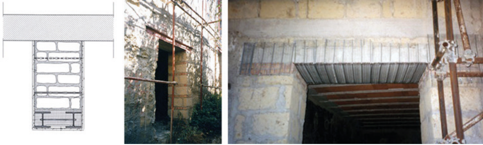
Fig. 12.5. Reconstrucción de dintel en muro de piedra con perfiles metálicos dispuestos en paralelo con recubrimiento de malla metálica.
