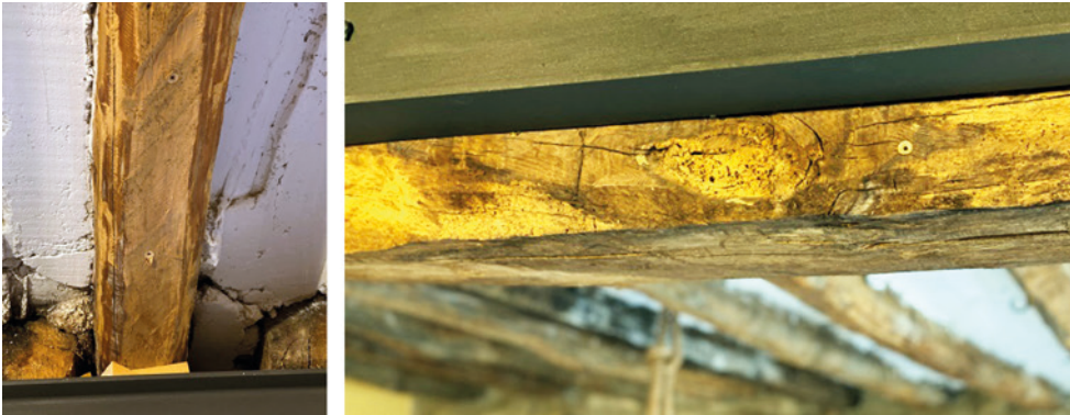
Fig. 14.4. Tratamiento curativo mediante desbastado superficial e inyección de producto químico en las vigas y viguetas de un forjado de madera afectado por carcomas. Obsérvense las perforaciones practicadas y la colocación de boquillas específicas cada 30 cm aproximadamente para la introducción del líquido inyectado. Como tratamiento complementario se suele dar una protección superficial mediante pincelado o pulverización.
