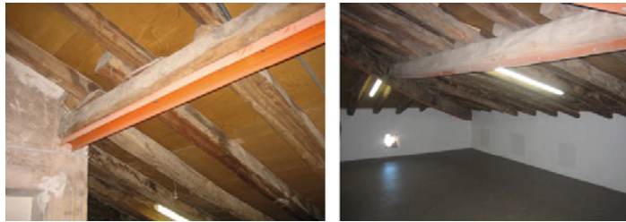
Fig. 18.4 En la foto de la izquierda, refuerzo de una viga de madera con un perfil metálico UPN. En la foto de la derecha, sustitución de algunos elementos del forjado utilizando también perfiliería metálica.
