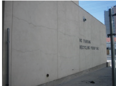
Fig. 8.4. En el gráfico, grietas verticales de retracción hidráulica en un muro de contención. En la foto, grietas de retracción hidráulica horizontales en un muro de hormigón armado de una fachada. En ambos casos, las grietas son paralelas y homogéneamente separadas.
