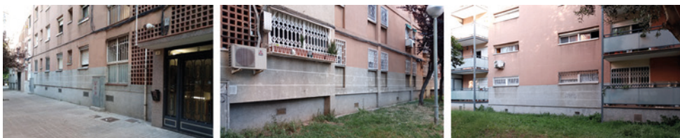
Fig. 35.3. Ejemplos de disposición a posteriori de rejillas de ventilación de las cámaras sanitarias en los edificios de un barrio residencial.
