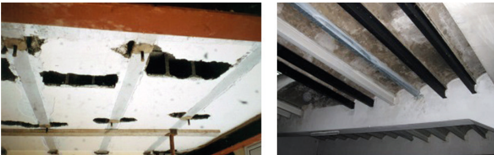
Fig. 15.2. En la foto izquierda, viguetas con boquillas de inyección colocadas, para proceder a la inyección de la resina epoxídica. En la foto de la derecha, refuerzo o sustitución funcional de viguetas mediante colocación de perfil metálico por su parte inferior.
