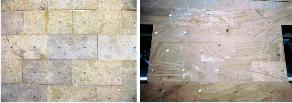
Fig. 40.8. Dos ejemplos de refijaciones visibles.
