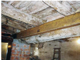
Fig.18-5. Refuerzo o sustitución funcional clásica de una viga de madera con perfiles metálicos presionados entre sí por las caras laterales con espárragos roscados.
