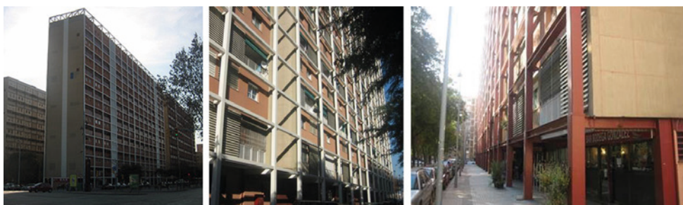
Fig. 30.3. Bloques de 16 plantas con estructura metálica reforzada por el exterior a las acciones del viento mediante una estructura metálica adicional que envuelve los edificios y aumenta su brazo mecánico.
