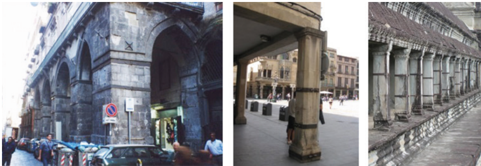
Fig. 11.3. Pilares en edificios históricos reforzados con anillos metálicos.
