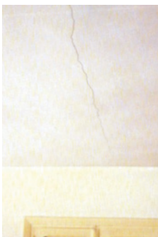
Fig. 20.1. Localización de las fisuras coincidiendo con la localización de los cambios de material entre vigueta y revoltón.
