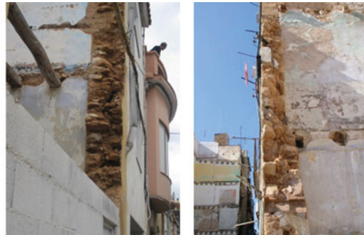
Fig. 1.3. Fractura interna típica de muros gruesos con escasa cohesión en la parte interna de su sección, lo cual es propio de muchos muros de piedra con mampostería no concertada.
