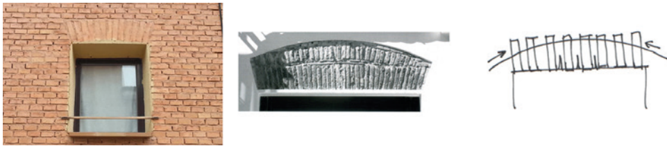
Fig. 12.4. En la foto y el gráfico central, dintel de ladrillo clásico con indicación de la línea de presiones. En el gráfico de la derecha, localización típica de las grietas, especialmente probables cuando las juntas se disponen verticalmente.
