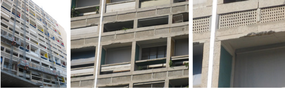
Fig. 9.3. Rehabilitación de las fachadas en el edificio de la Unité d'Habitation de Marsella, fuertemente afectadas por los efectos de la corrosión de las armaduras en los elementos estructurales de hormigón armado.
