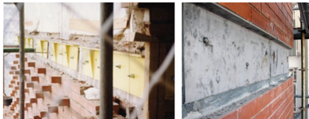
Fig. 36.4. Formación de junta elástica horizontal y disposición de angular de apoyo en la línea de dinteles mediante la extracción y reposición de dos hiladas de ladrillo. Los tubos de sujeción del angular se prolongan verticalmente hacia abajo para prever puntos de fijación que evitan el vuelco del muro, pero permiten su libre desplazamiento vertical.
