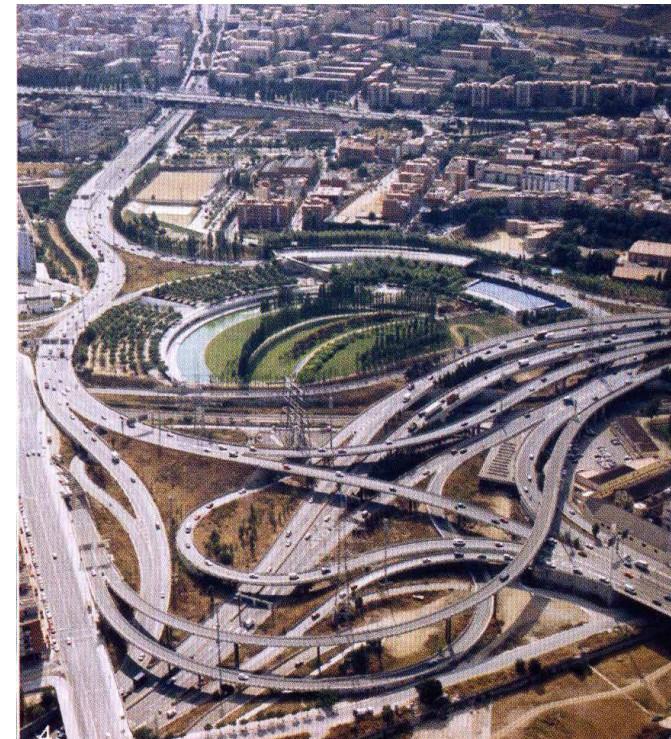
Fig. 03: Ruptura anillo de la Trinidad
