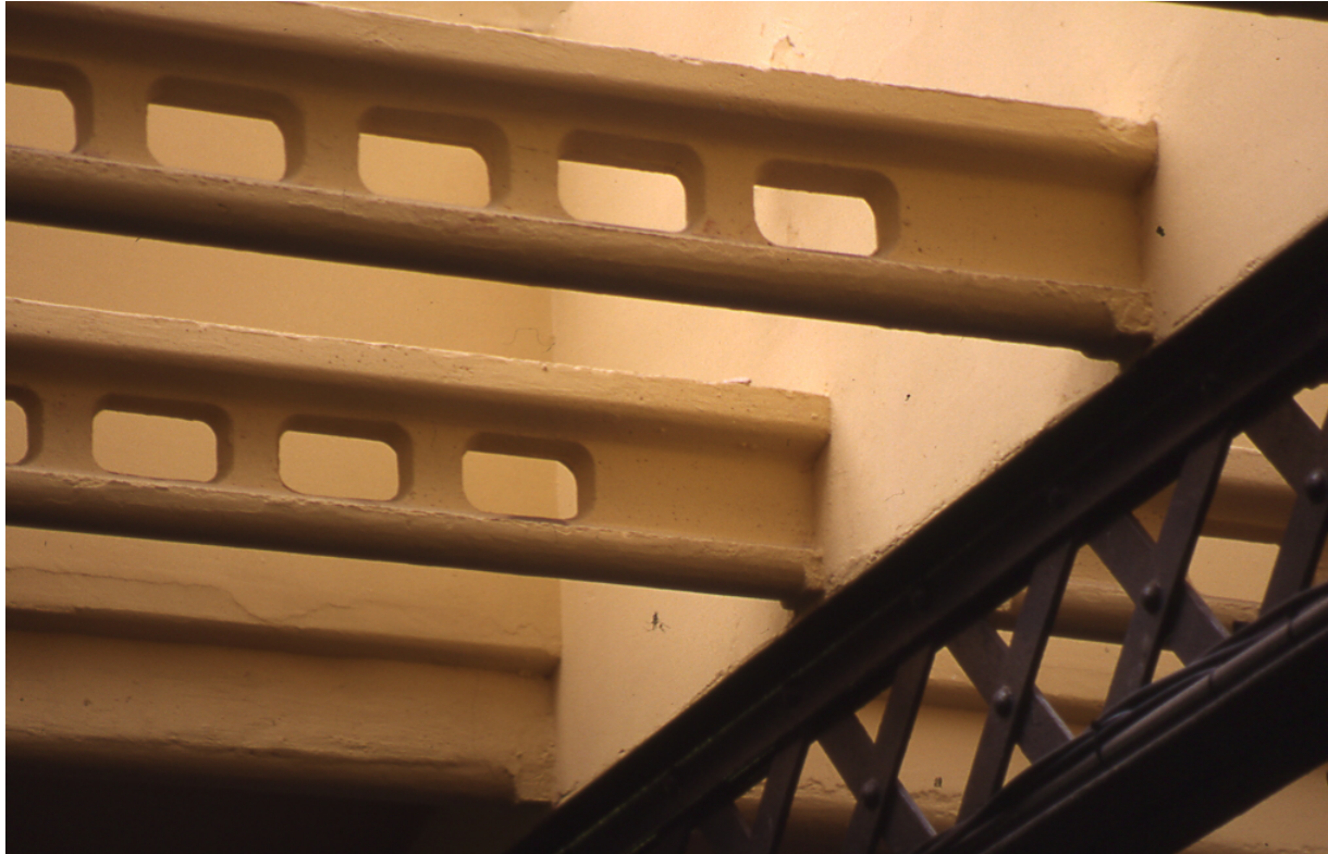
Figura 67 Sostre de formigó armat de gelosia que s'introdueix tímidament a finals del primer terç del segle XX
