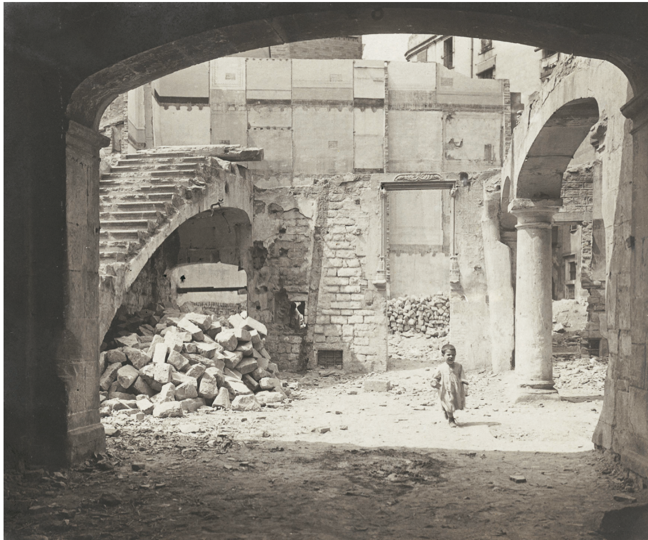
Figura 21 Obres d'obertura de la Via Laietana. Frederic Ballell. 1910. Arxiu fotogràfic de Barcelona.
