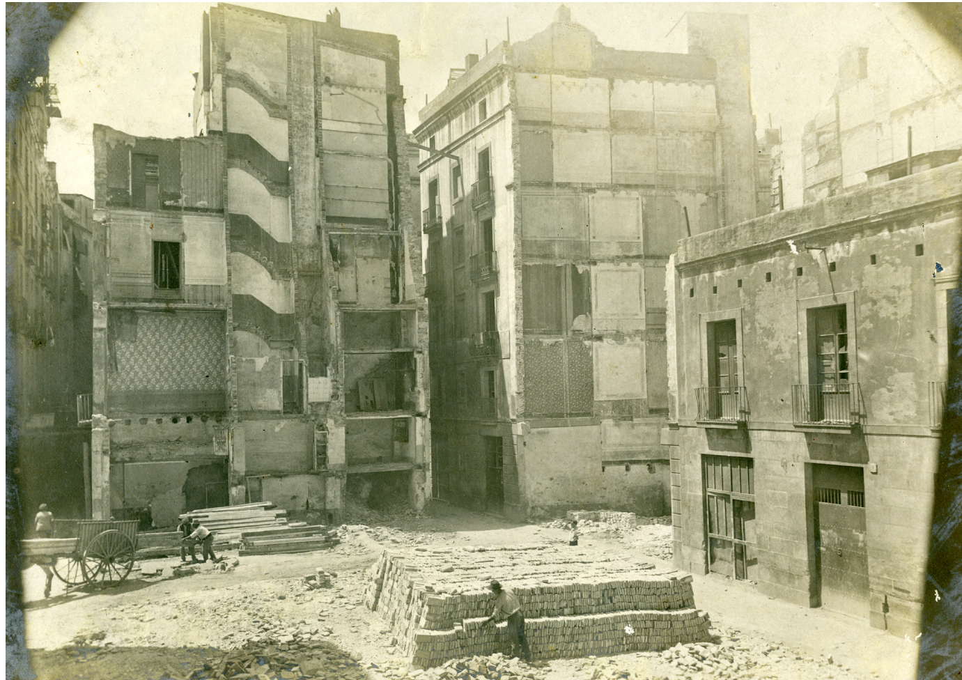
Figura 60 Replegament i classificació de materials a conseqüència de l'enderroc de cases a la Ciutat Vella per tal d'obrir la Via Laietana. Arxiu fotogràfic de Barcelona
