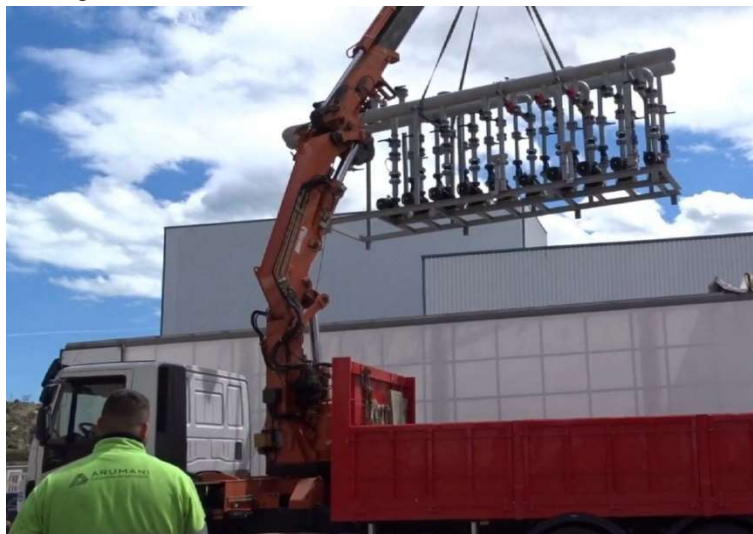
Fig. 3 Proceso de carga de skid montado y pre-fabricado, listo para transporte, con estructura auto-portante. Fuente: Arumani. (2019)
