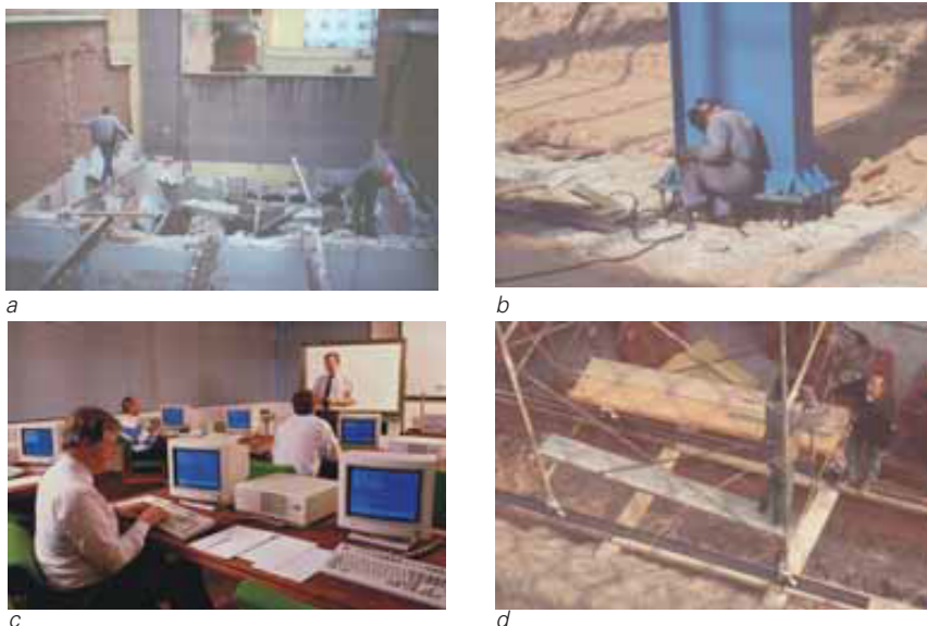
Fig. 2.2. Cuatro ejemplos donde se aplica distinta normativa de Evaluación de Riesgos.
