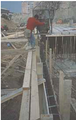
Fig. 2.13. Vertido de hormigón, en muro pantalla, encofrado a doble cara, con cangilón. Organización de la obra en dos fases dada su dimensión (los trabajos se encuentran en la segunda fase).
