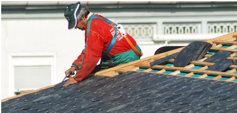
Foto 1.3 Riesgo de trabajos en altura. Ejemplo; colocación de piezas de pizarra en cubierta inclinada.
