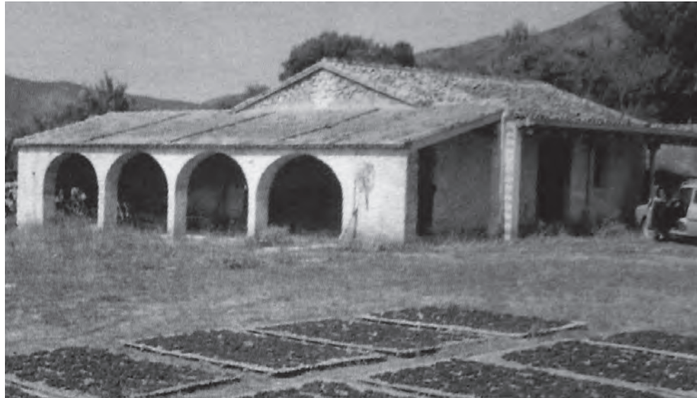
Fig. 205. Riurau del Tossalet. Fabrica de mampostería revocada. Foto gentileza de Joan Giner.
