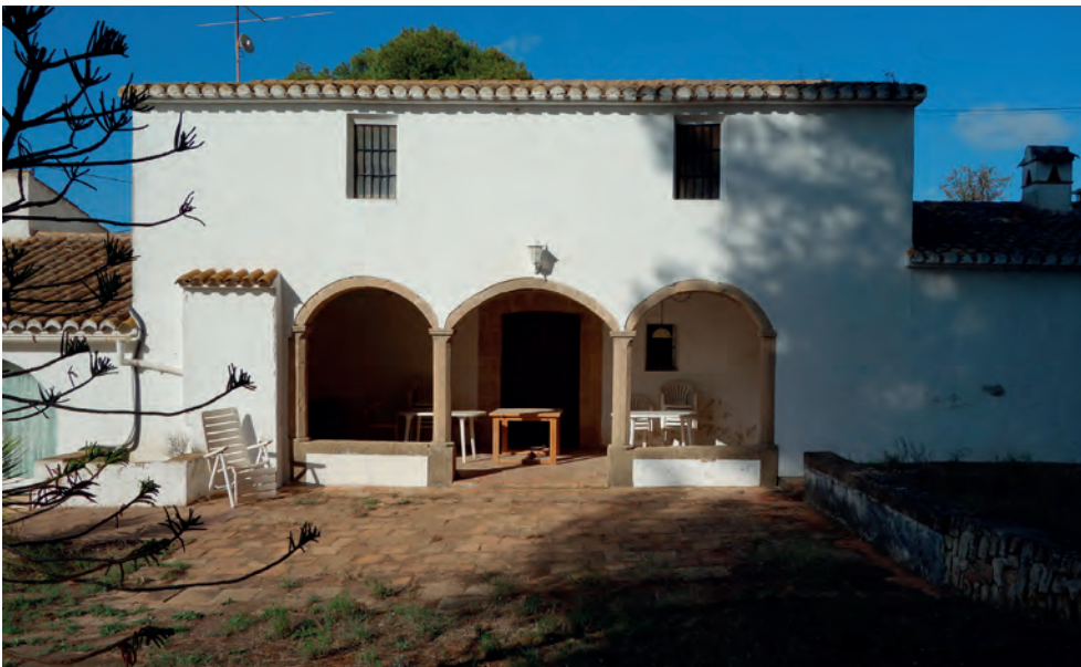
Fig. 209. Riurau de l'Arnauda en Xàbia. El riurau en el proceso de reconstrucción en su nueva implantación urbana, resuelto con una fábrica de mampostería con arcos de dovelas y hastiales resueltos con sillares de tosca, todo ello de recuperación del edificio original. Foto P. Guardiola en Riuralogia nº 5.
