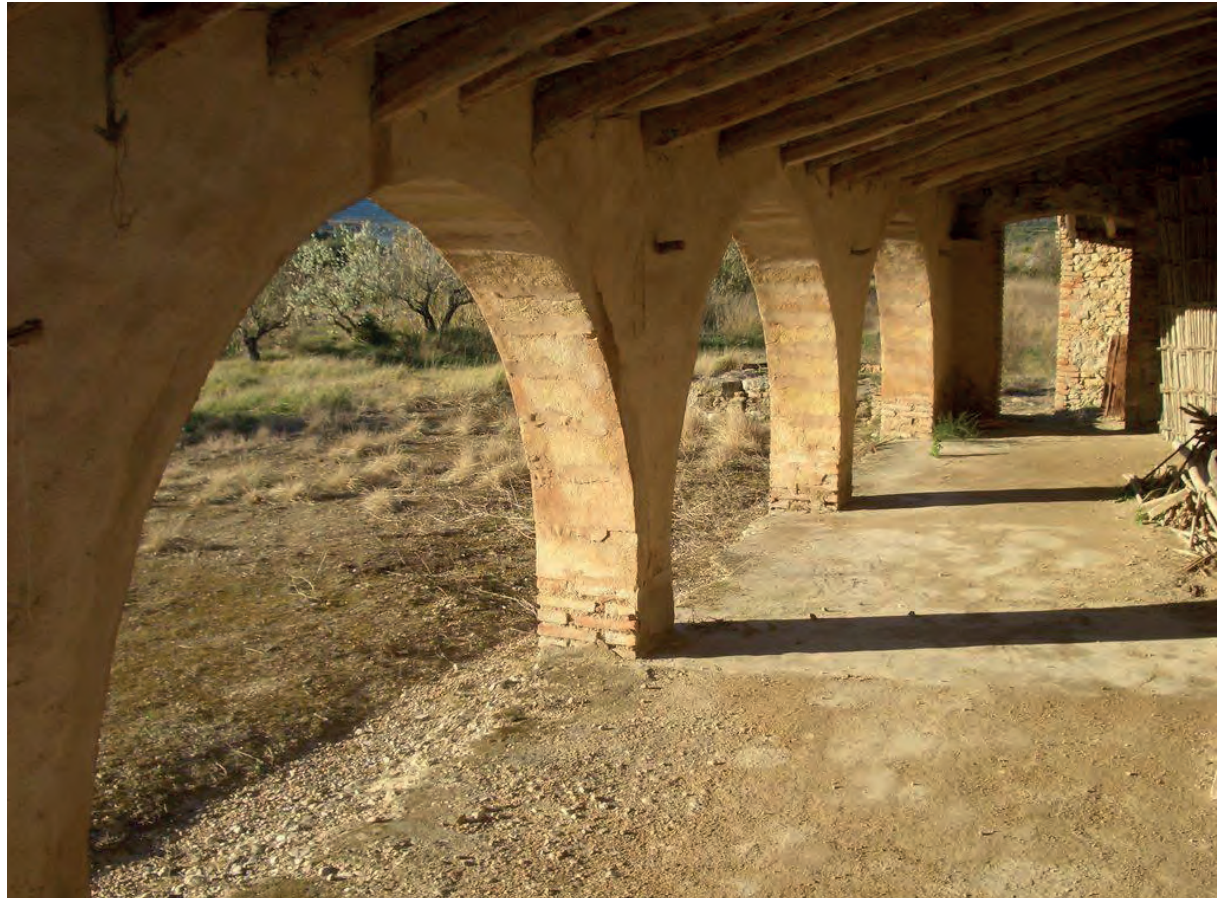
Fig. 242. Arcada del Riurau de Constantí, Terrateig (Vall d'Albaida). Arcos de medio punto de amplia traza y muy baja altura de impostación. Foto C. Fuster.
