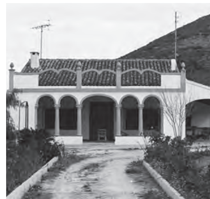
Fig. 281. a y b. Naies en Xàbia (La Marina). Porches compuestos en estos dos casos por cinco vanos, el central más ancho y carpanel, las laterales de medio punto, dos ellos levantados sobre columnas de piedra tosca. El carácter doméstico y lúdico domina al conjunto. Fotos MDR.
