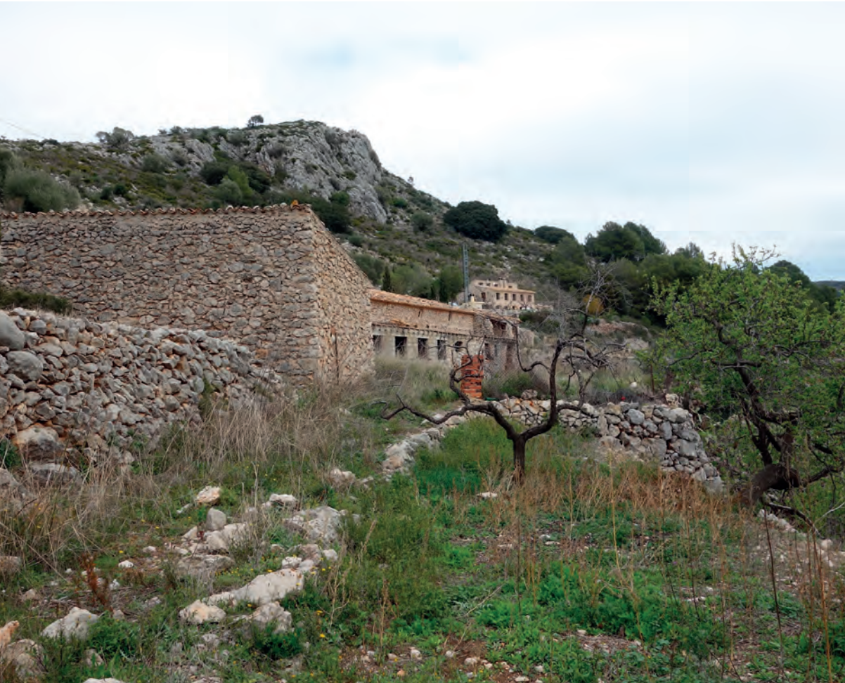
Evolución del paisaje de riuraus en el Coll de la Creu en Tárben (La Marina). Vista del paisaje en los inicios del siglo xx, estado actual y planta de uno de los edificios.
