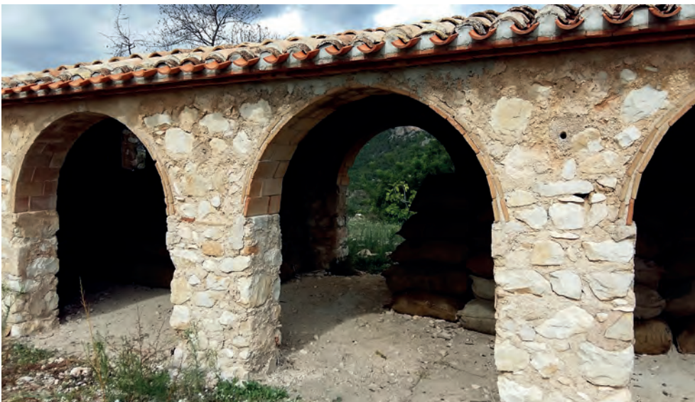
Fig. 229. Riurau de l'Ama. Beniardà (La Marina). Detalle de las fábricas de la fachada, con una mampostería en la construcción de los machones, y un cuerpo superior de mampostería encofrada, posiblemente a la vez que la construcción de la cimbras para construir las rosca de los arcos. Foto MdR.
