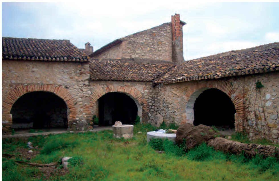
Fig. 212. Riurau de la Casa de l'Alfás en Ador (La Safor). Vista del sistema de arcos de ladrillo a sardinel con piezas de dimensiones de época foral en lo que fue el antiguo Trepig de l'Alfás, más tarde transformado en riurau para la explotación de la uva pasa. Las fábricas, sobre las que se construyen los arcos de ladrillo, son mamposterías de alguna manera inciertas, bien como resultado de sucesivas reparaciones o por ser en origen encofradas a la manera de tapia. Foto publicada en la página web: Riuraus amb Panses .
