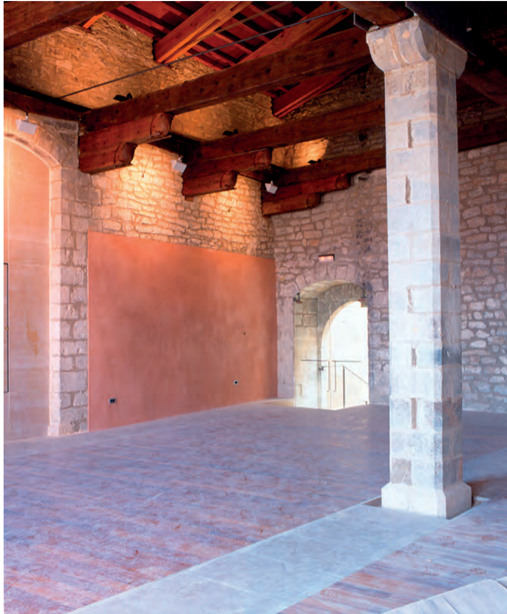
Fig. 24. Ayuntamiento de Morella. Sala del Justicia. Foto J. Roig. Viguería y dobles ménsulas con figuras zoomórficas o antropomórficas, sostén de lo que debió ser un forjado perteneciente a la desaparecida torre del edificio original. Restauración de M del Rey e I. Magro de 1996-98.
