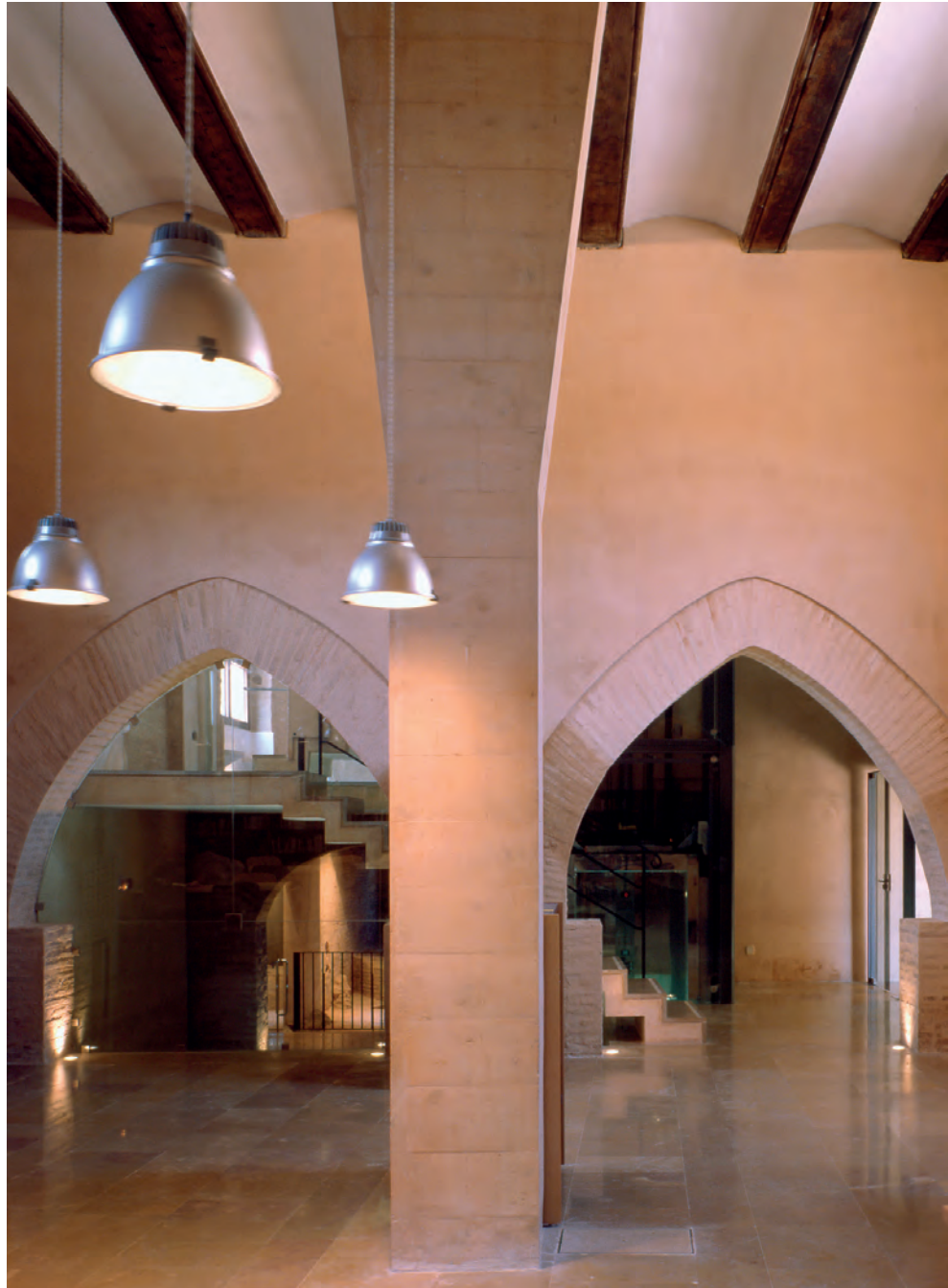
Fig. 83. Alquería de Barrinto, Benicalap. València (l’Horta). Espacio interno de la actual biblioteca municipal, con los arcos del porticado tardomedieval ya restaurados. Foto Mdr.
