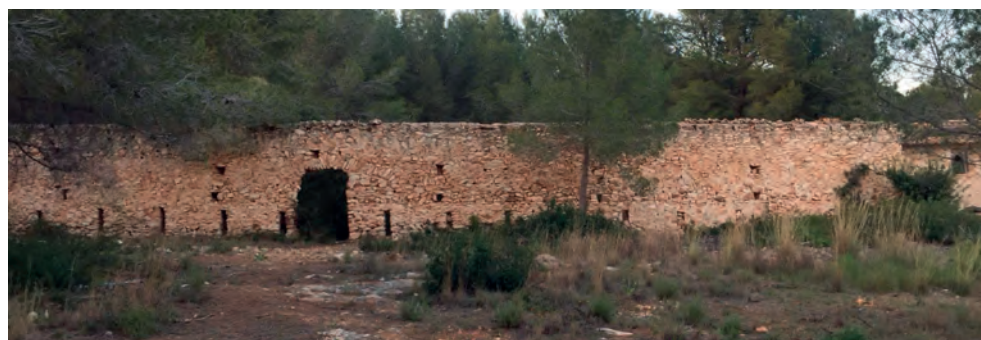
Fig. 203. Casa Feliu, pared trasera del antiguo riurau. Calp (La Marina). Muro de mampostería configurando la pared de cierre de un riurau de una crujía, donde podemos ver las escotaduras de ventilación del riurau. Un arco de descarga abría una puerta que unía con las instalaciones de las camas de sol a las que nos hemos referido en varios apartados de este libro. La mampostería que hoy existe con piedra vista fue en su tiempo revocada por un mortero de cal, como muestran aún los restos en ciertos lugares más protegidos del muro. Foto MdR.
