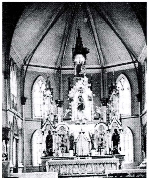
Fig. 12.37 Iglesia metálica prefabricada construida por Eiffel
