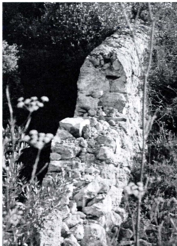
Fig. 1.3. Valla de piedra en Garraf. La anchura es la mínima para el tipo de piedra
