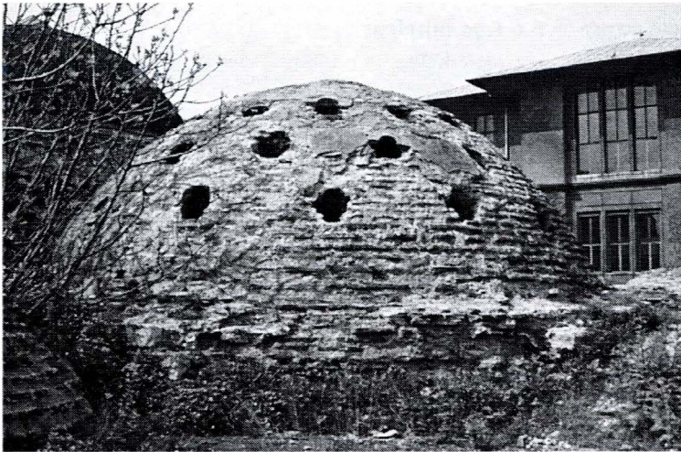
Fig. 5.33 Pequeños óculos en una cúpula aparejada
