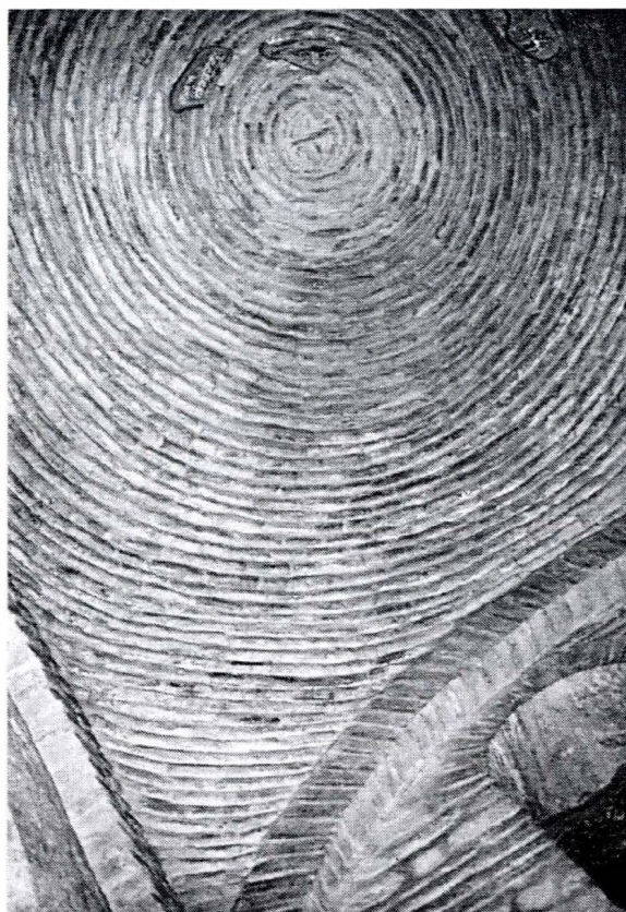
Fig5.30 Pechina de ladrillos para soporte de cúpula
