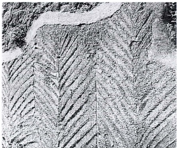
Fig. 3.55 Revoco grueso de preparación
