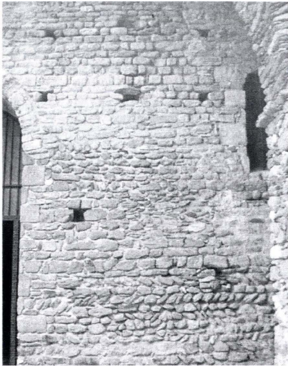
Fig. 8.20 Muro del narthex de San Pedro de Roda
