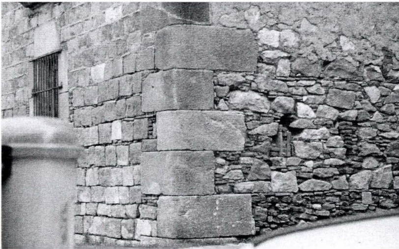
Fig. 1.10. Esquina reforzada con grandes sillares
