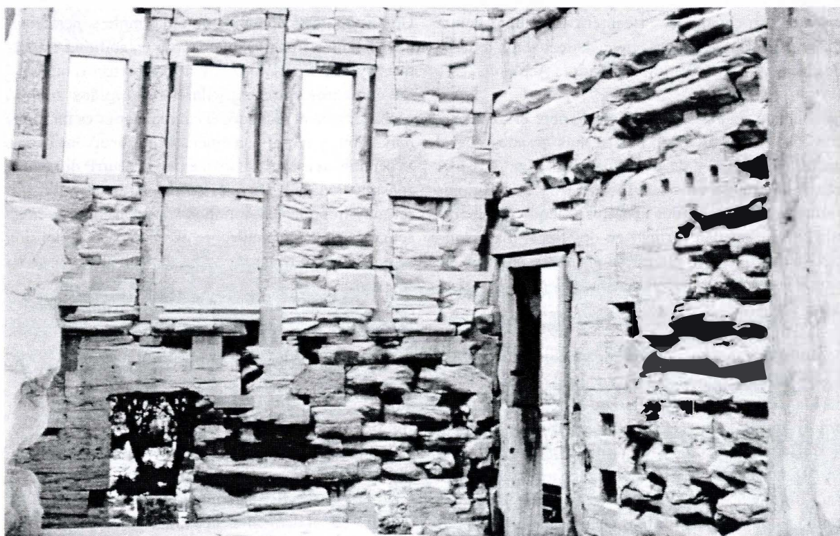
Fig. 2.17. Aparejo del Erecteión desde el interior de la cella.
