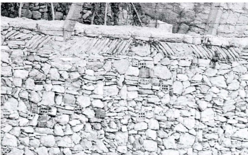
Fig. 1.11. "Opus spicatum" actual con material de derribo en Vilanova
