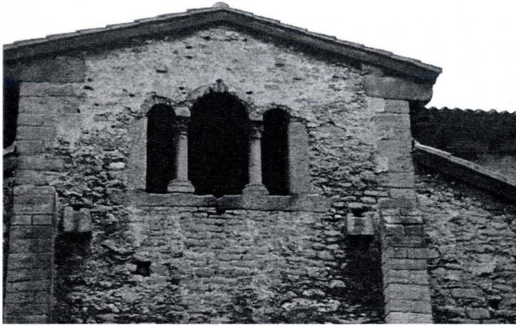
Fig. 6.4.11 Exterior de San Julián de los Prados con el canecillo de esquina
