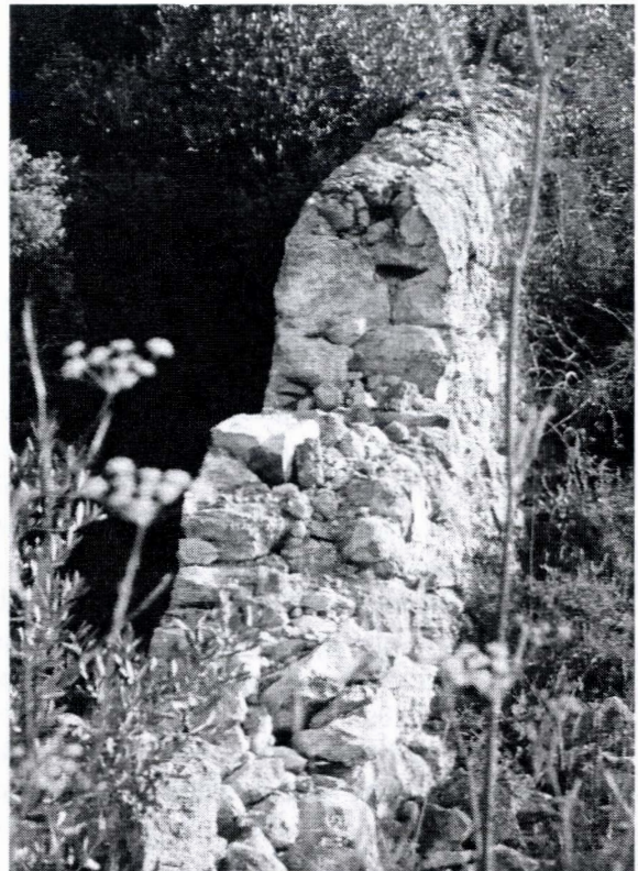
Fig. 1.3. Valla de piedra en Garraf. La anchura es la mínima para el tipo de piedra
