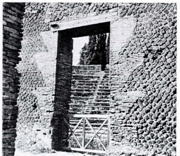
Fig. 3.20 Detalle de jamba
