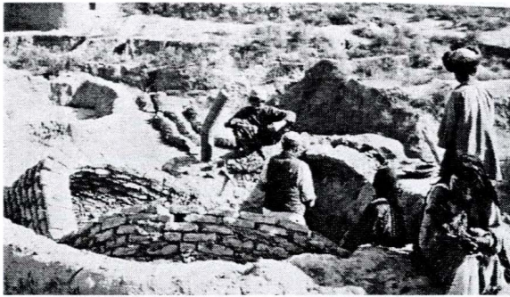
Fig. 7.72 Construcción de una cúpula sin cimbra con pechinas abovedadas
