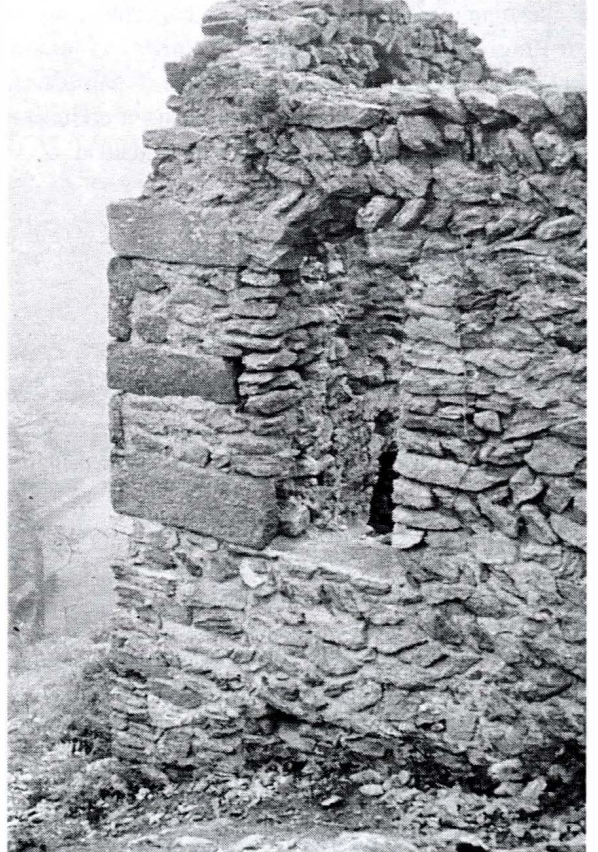
Fig. 6.5.8 Esquina con refuerzo de sillares cerca de San Pedro de Roda
