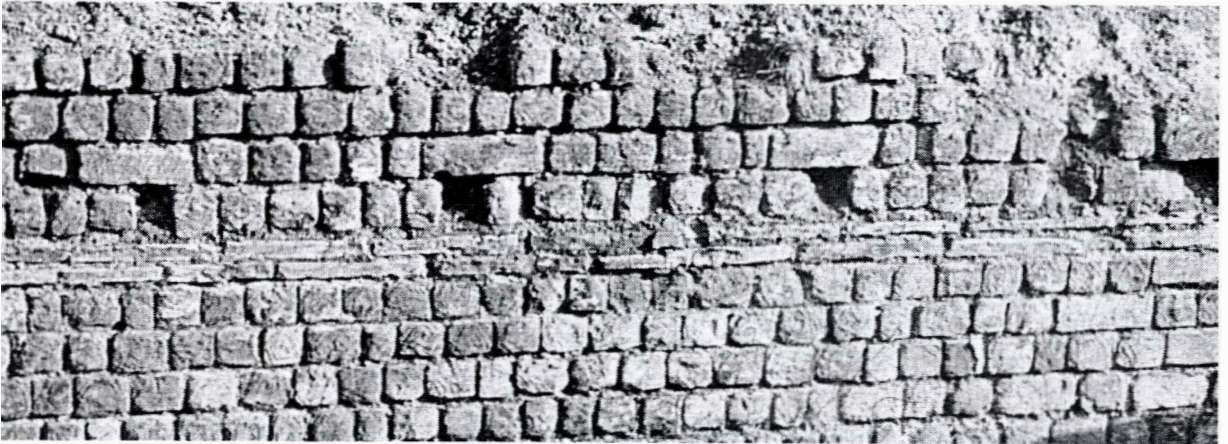
Fig. 3.18 Zuncho en muro de sillarejo
