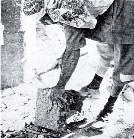
Fig. 7.58 Ajuste de las caras de un sillar
