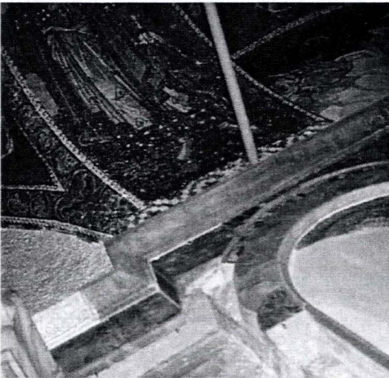
Fig. 5.47 Aplacados de mármol en San Salvador de Chora
