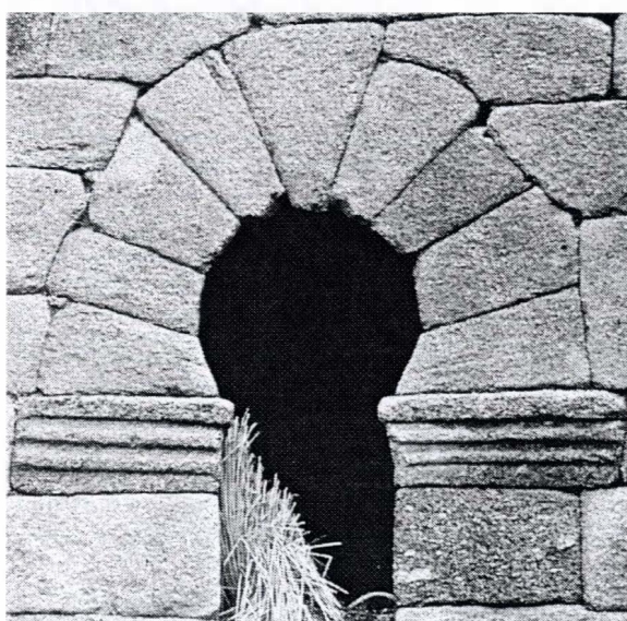
Fig. 6.3.7 Ventana despiezada en espina de pez en Santa María de Melque
