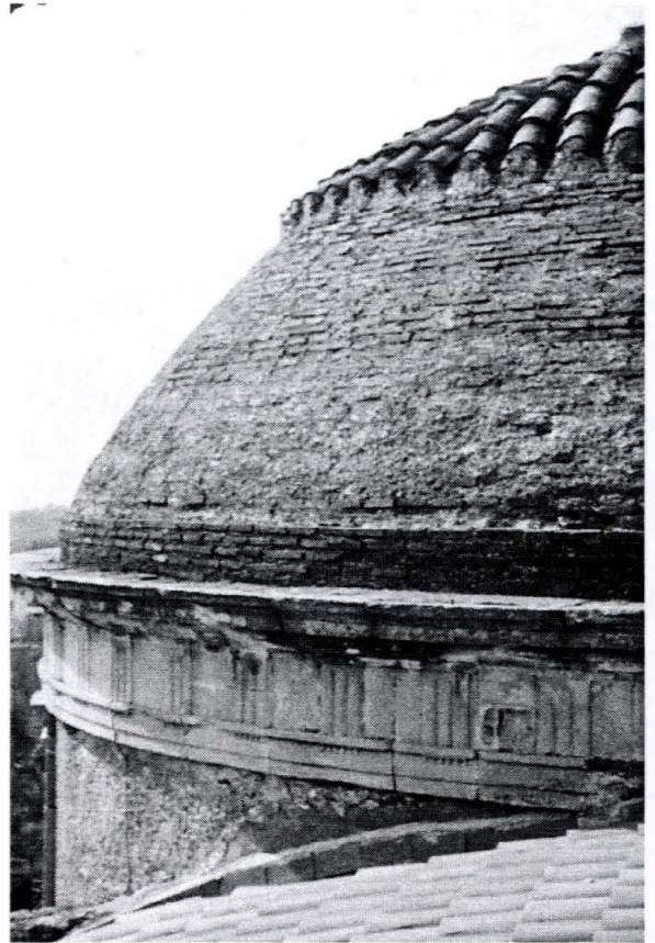
Fig. 10.64 Detalle de la cúpula del cimborrio de la iglesia de San Andrés. La Selva del Camp
