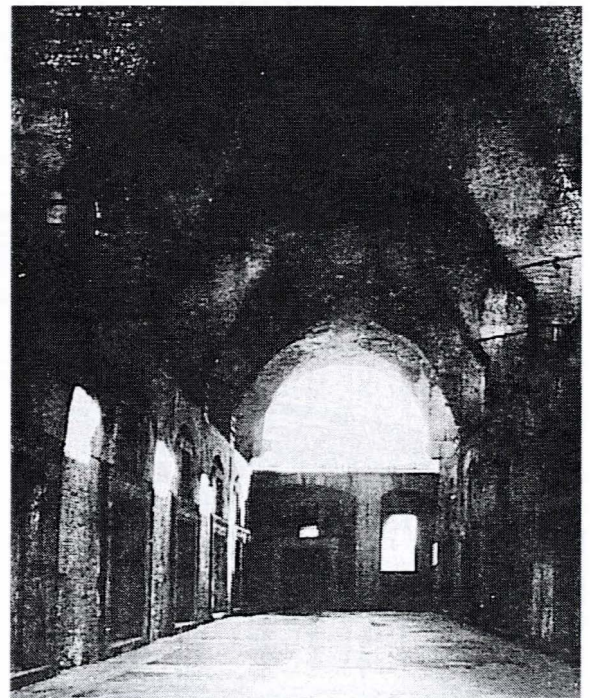
Fig. 3.48 Bóveda penetrada por lunetos de iluminación en el mercado de Trajano
