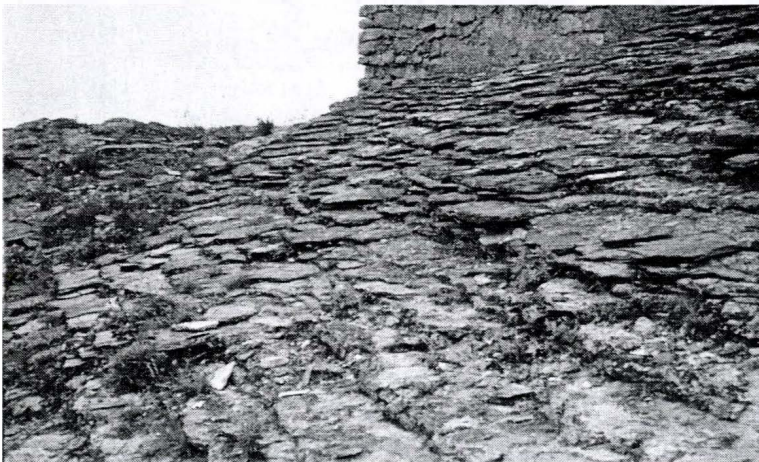
Fig. 6.5.16 Cubierta de la Iglesia de Santa Elena
