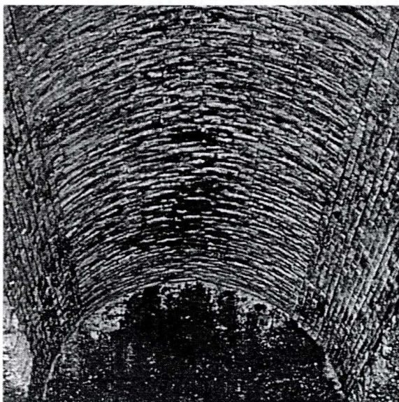
Fig. 3.41 Bóveda acabada con ladrillos
