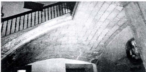
Fig. 10.62 Escalera de la Real Chancillería. Granada
