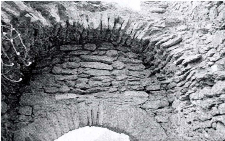
Fig. 6.5.15 Arranque de bóveda de piedra de laja en Santa Elena
