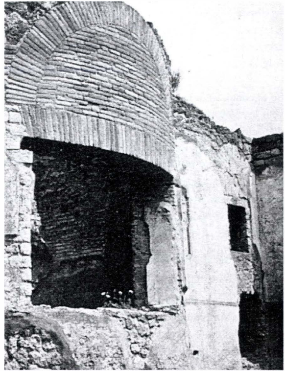
Fig. 3.22 Arco de descarga curvo
