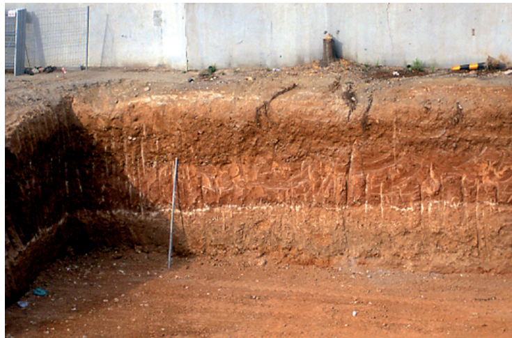
Fig. 70 El tricyclo en la ampliación de la Biblioteca de la ETSAB. Obsérvese la capita de tortora (de color blanco) con la arcilla encima y los limos debajo.
