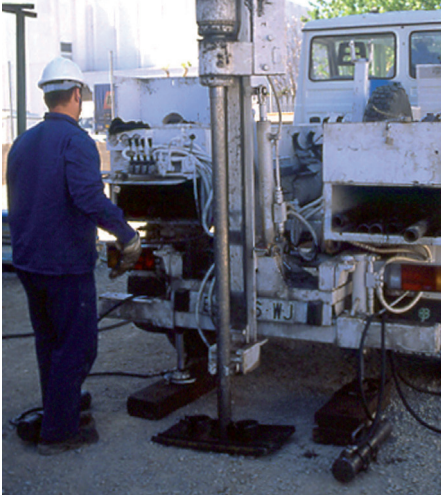
Fig. 87 Detalle del penetrómetro dinámico durante el ensayo. Se ven las líneas a 20 cm para ir contando el número de golpes.
