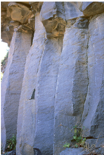
Fig. 2 Columnas de basalto en la cantera de Boscarró (incorporadas directamente a la iglesia de la Colonia Güell).
