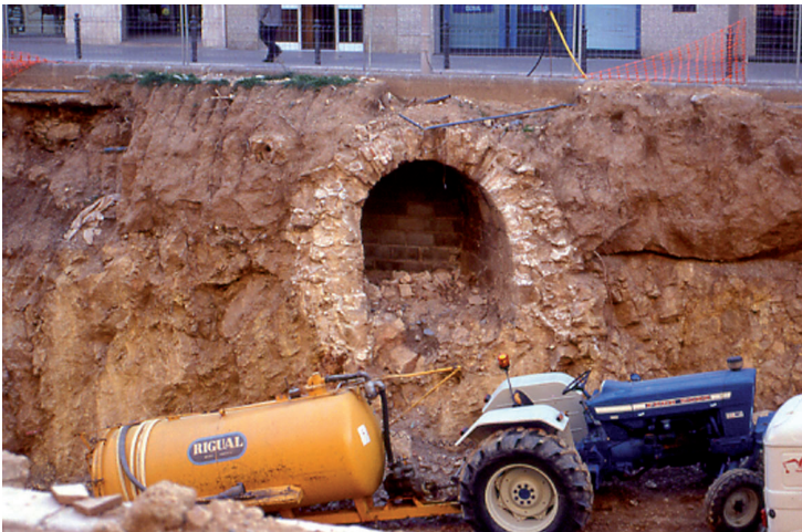
Fig. 194 Una alcantarilla «olvi- dada» en la Rambla Nova de Tarragona.
