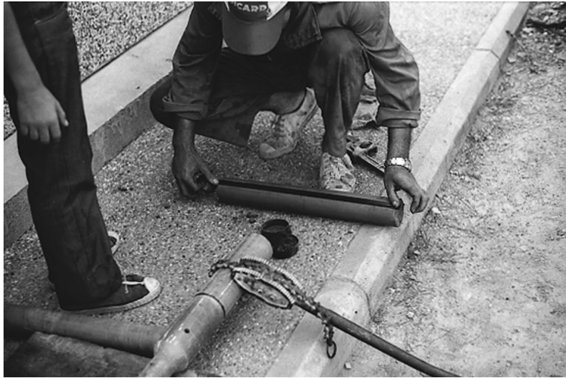
Fig. 181 Precintado de la muestra inalterada en el tomamuestras antes de enviarla al laboratorio (Fuente: ETSAB, 1979).
