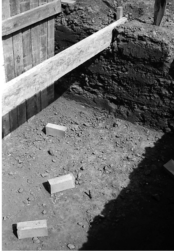
Fig. 195 Ensayo de la parpelina al fondo de cada zapata excavada antes de verter el hormigón de limpieza. El ensayo de la parpelina consiste en clavar manualmente una parpelina (escarpa) en el fondo de cada zapata para detectar bolsadas blandas, cuevas, roca o restos.
