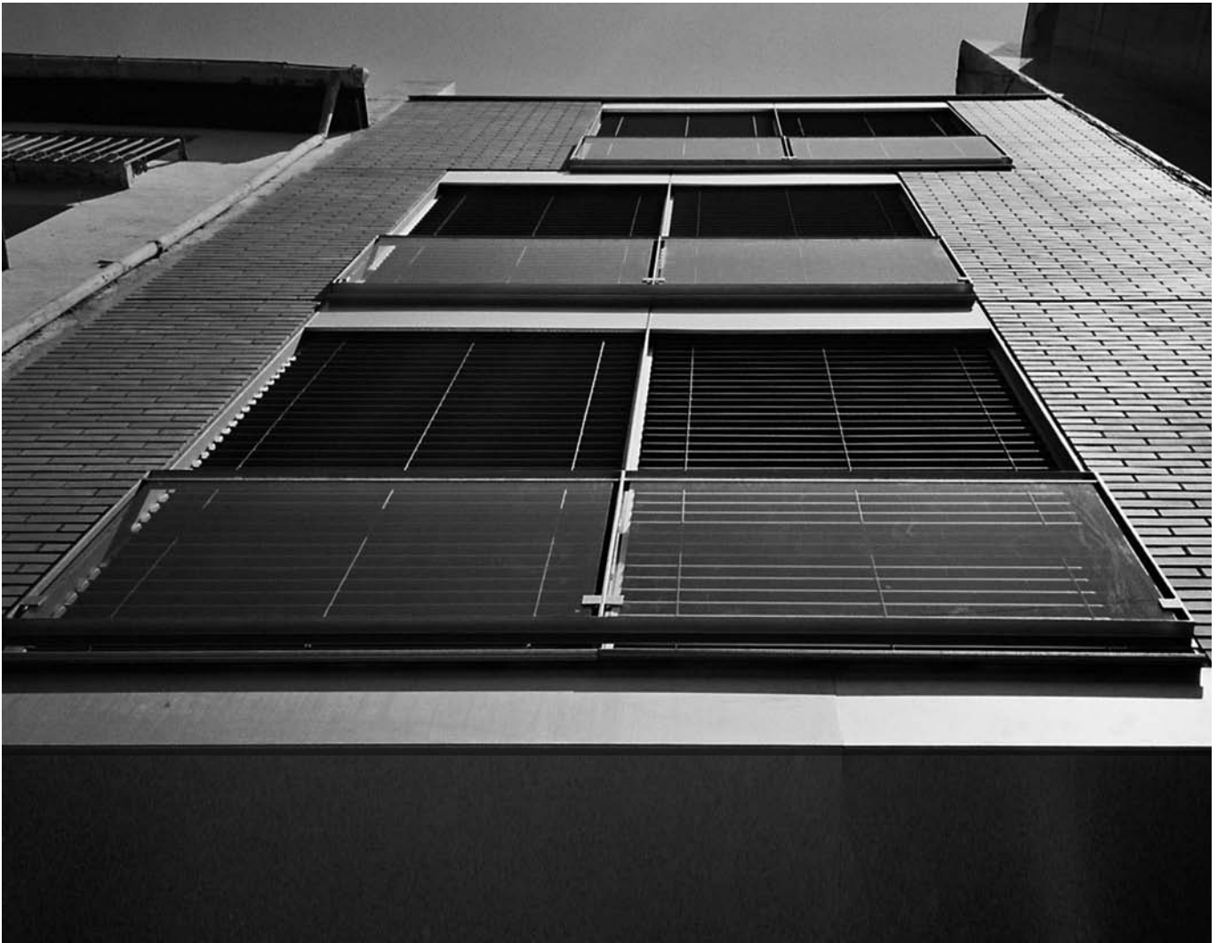
Fachada de edificio de viviendas. Onda, Castellón, 1999 21
