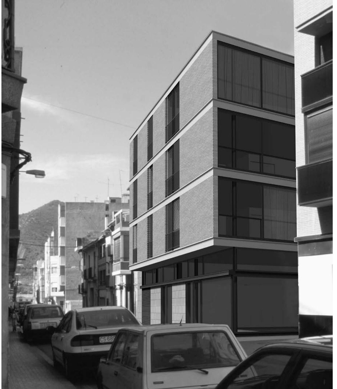
Edificio de viviendas. Onda, Castellón, 2001 33
