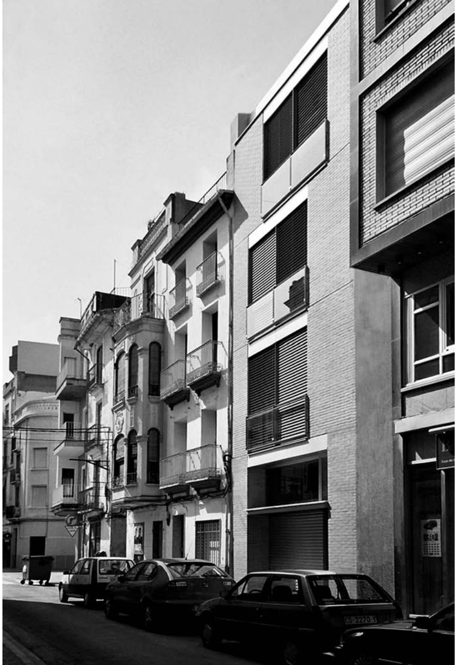
Fachada de edificio de viviendas. Onda, Castellón, 1999
