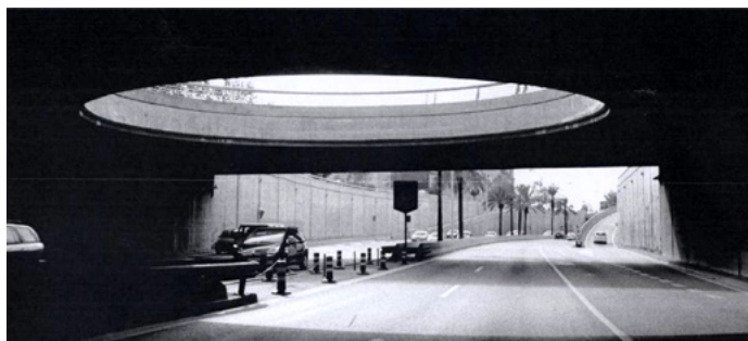
Vista de la vía segregada en Ronda de Dalt
