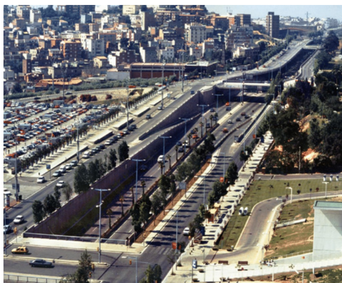
Vista de la Ronda de Dalt a su paso por Vall d'Hebron
