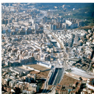
Construcción de la Ronda de Dalt, 1991
