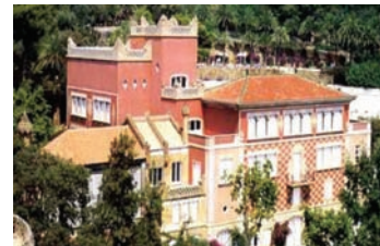
Casa Güell o Casa Larrard, actual Colegio Baldori i Reixac
