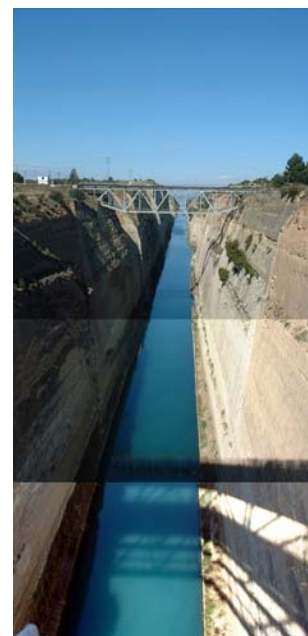
Puente sobre el Canal de Corinto, 14.02.2005
