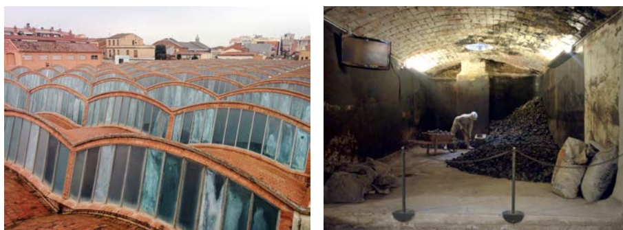
Figura 1,2 El Museo de la Ciencia y de la Técnica de Cataluña en Terrassa, albergado en la fábrica textil del Vapor Aymerich (Fuente: Archivo personal de los autores)
