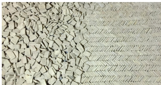
Fig. 1 Pavimento romano. Horreum. Narbonne. Autor: Fontàs, J (2019)
