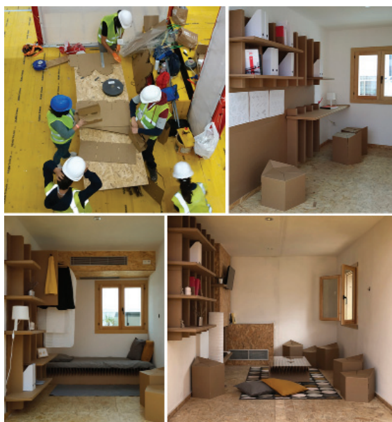
Fig. 7 Etapa de construcción en Szentendre. Hungría, julio 2019 y resultado de las estancias terminadas con el mobiliario de cartón
