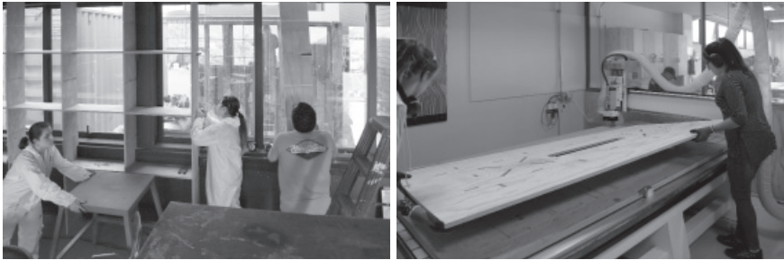
Fig. 1 y 2 Fabricación y montaje del nuevo espacio del Taller de Práctica. Fuente: Escuela de Arquitectura USS (2019)
